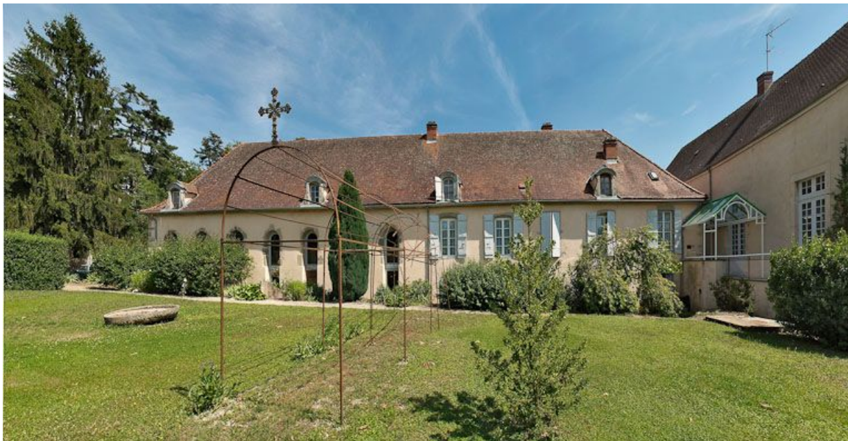
Façade postérieure de l'ancien hôpital.
