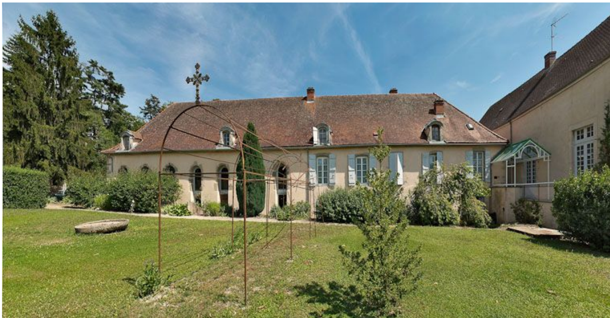
Façade postérieure de l'ancien hôpital.
