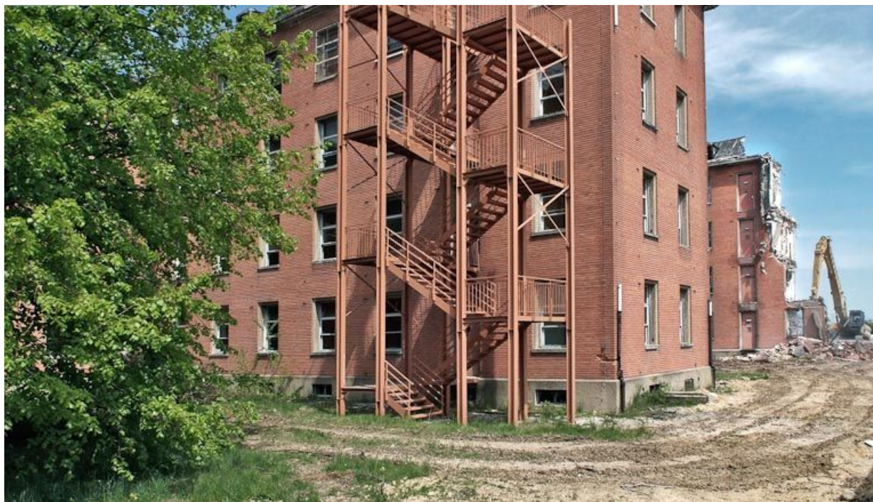
Bâtiment hospitalier en cours de démolition.
