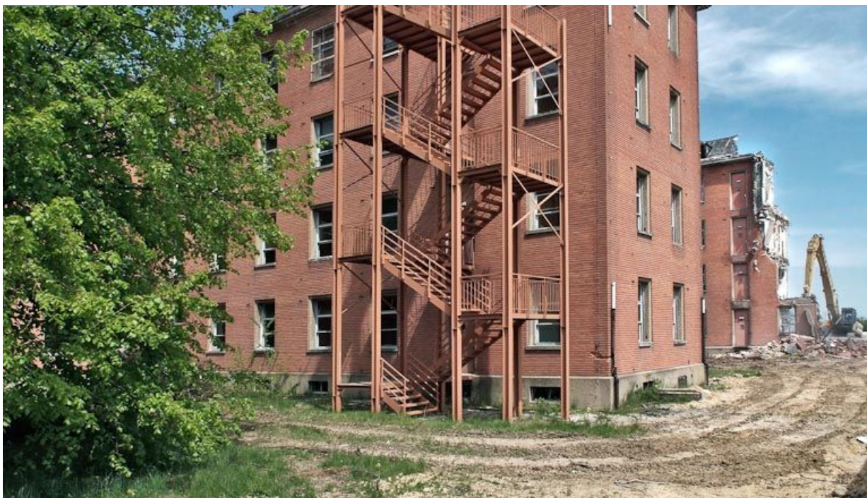
Bâtiment hospitalier en cours de démolition.
