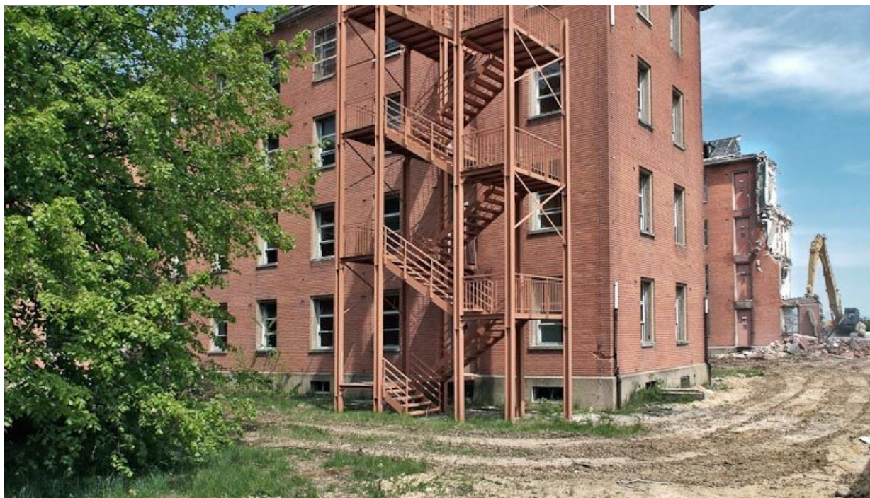
Bâtiment hospitalier en cours de démolition.
