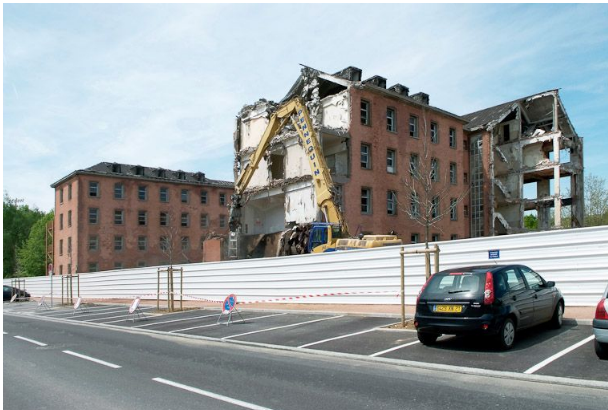
Bâtiment hospitalier en cours de démolition. 21, Dijon Stade
