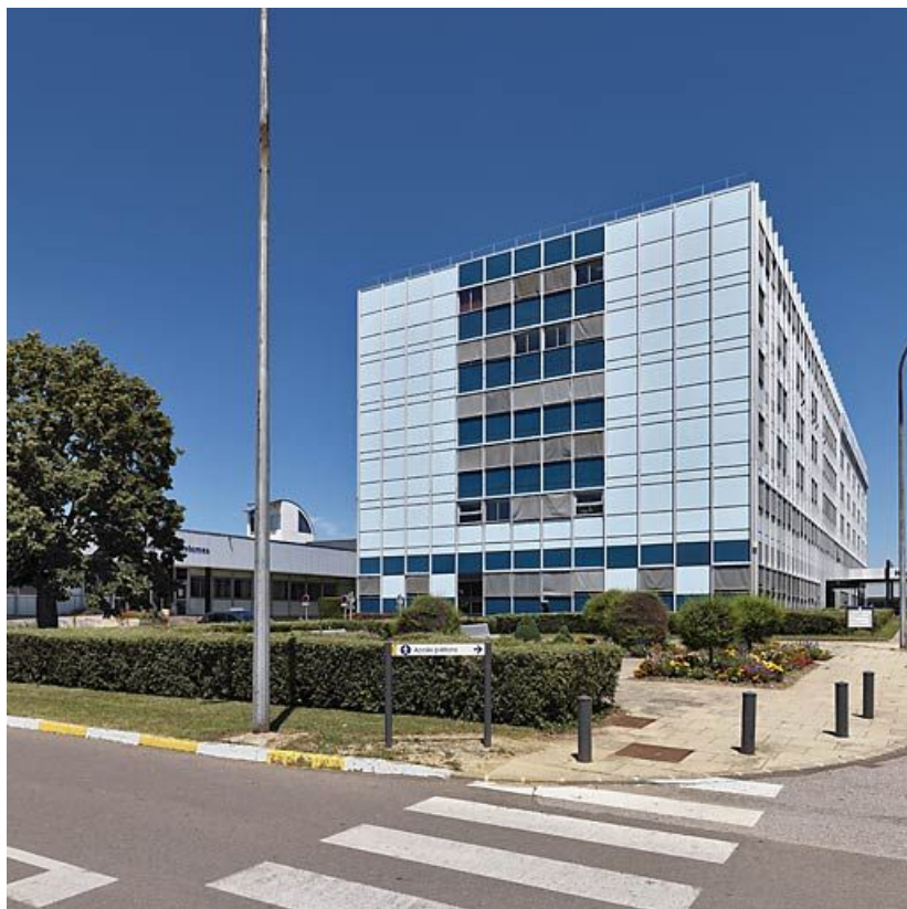
Bâtiment principal, vue d'ensemble de trois-quarts.
