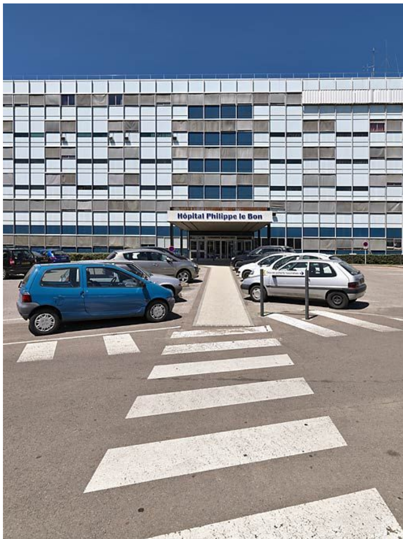
Bâtiment principal, partie centrale de la façade. 21, Beaune Guigone-de-Salins
