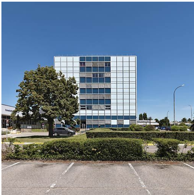
Bâtiment principal, élévation latérale.
