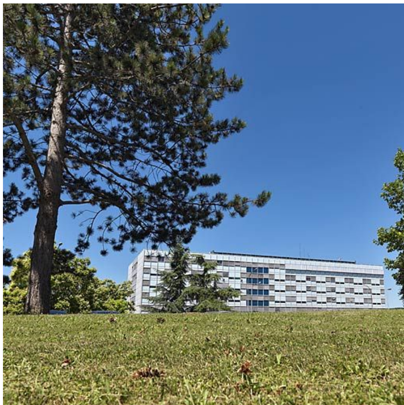
Bâtiment principal, vue d'ensemble.
