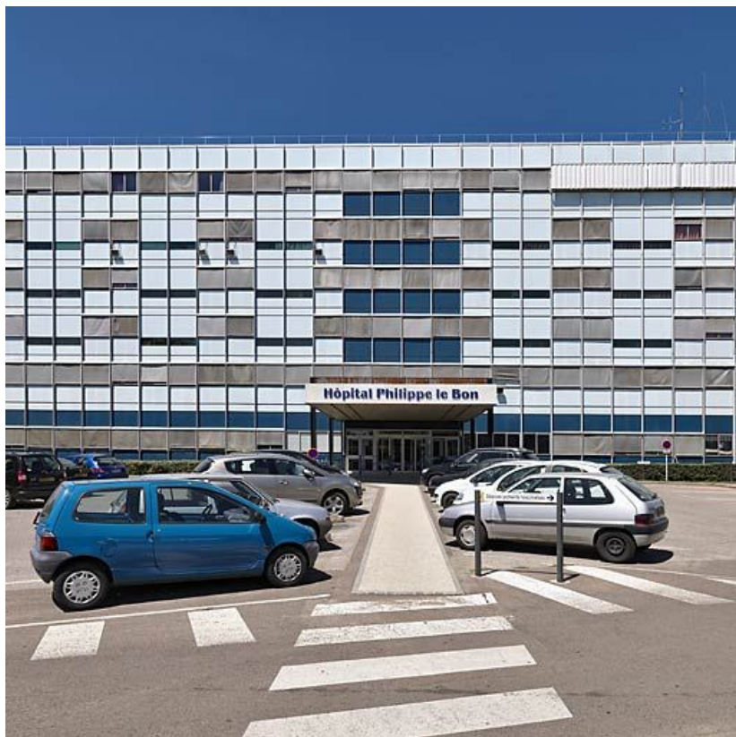
Bâtiment principal, partie centrale de la façade.
