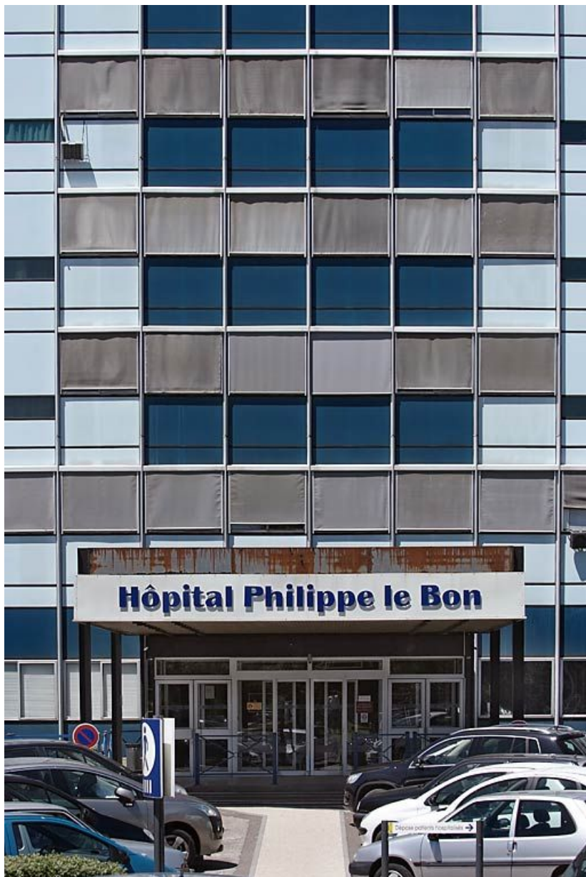
Bâtiment principal, détail de la façade.
