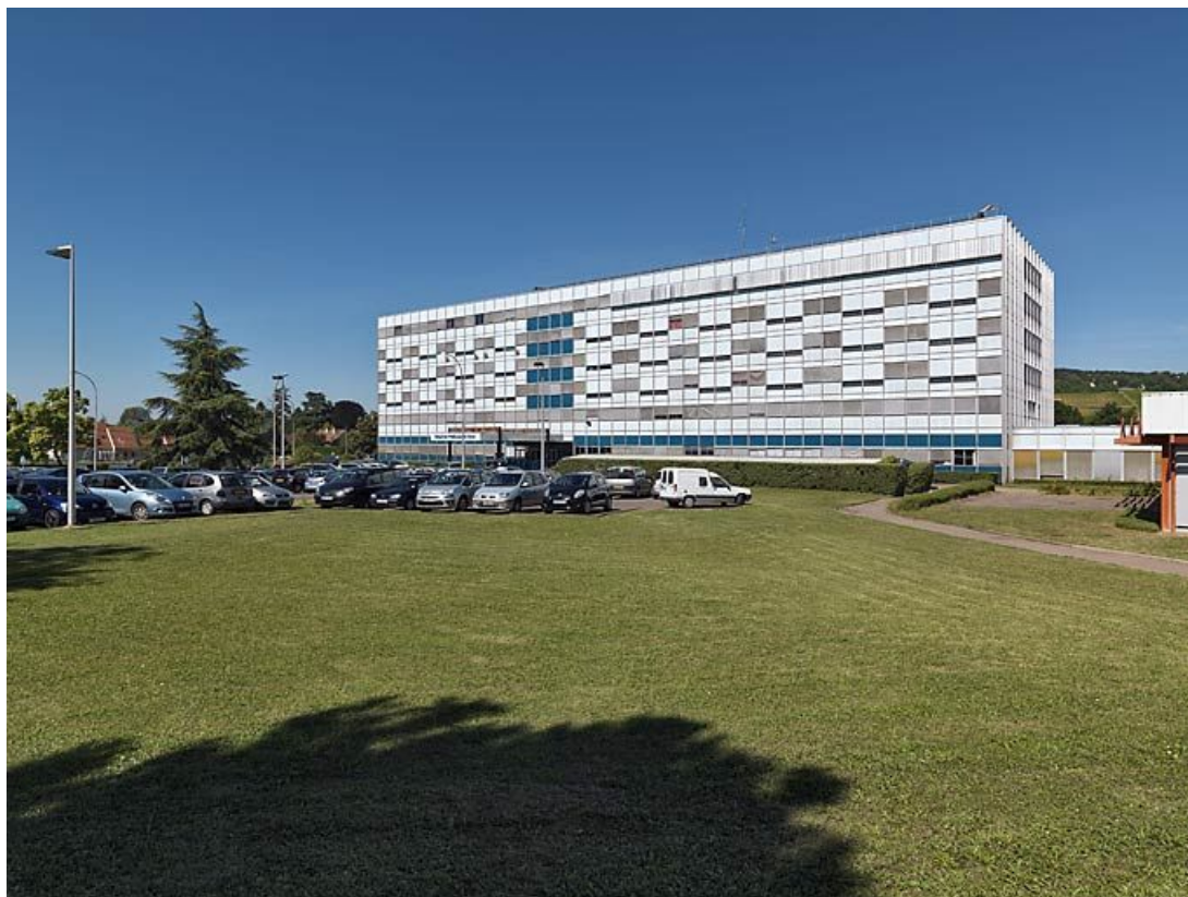
Bâtiment principal, vue d'ensemble.
