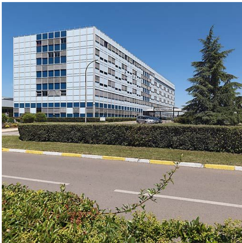
Bâtiment principal, vue d'ensemble de trois-quarts.
