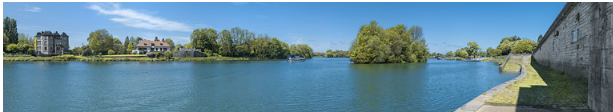
Panorama de la Saône à hauteur du passage de l'ancien pont : on distingue à gauche les vestiges de la culée. 21, Seurre, lieudit : PK 187
