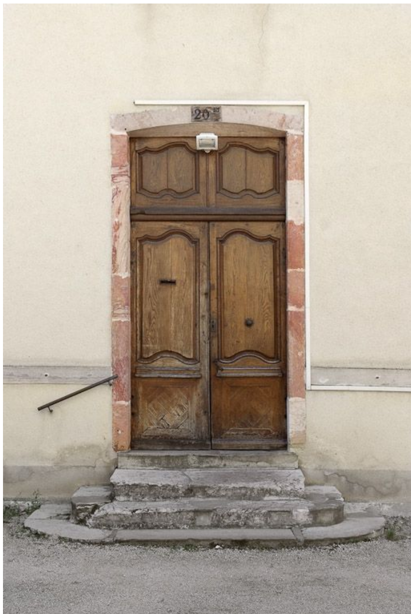
Ancienne porte de la mairie employée dans la façade nord. 21, Auxonne, 20 B rue Davot
