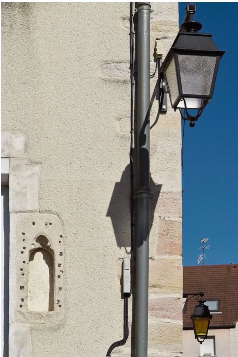
Façade ouest : détail de la petite niche trilobée en rempli. 21, Auxonne, 20 B rue Davot
