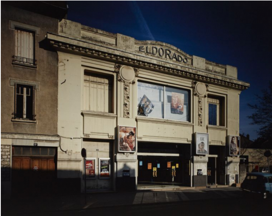
Vue d'ensemble de la façade en 1994.
