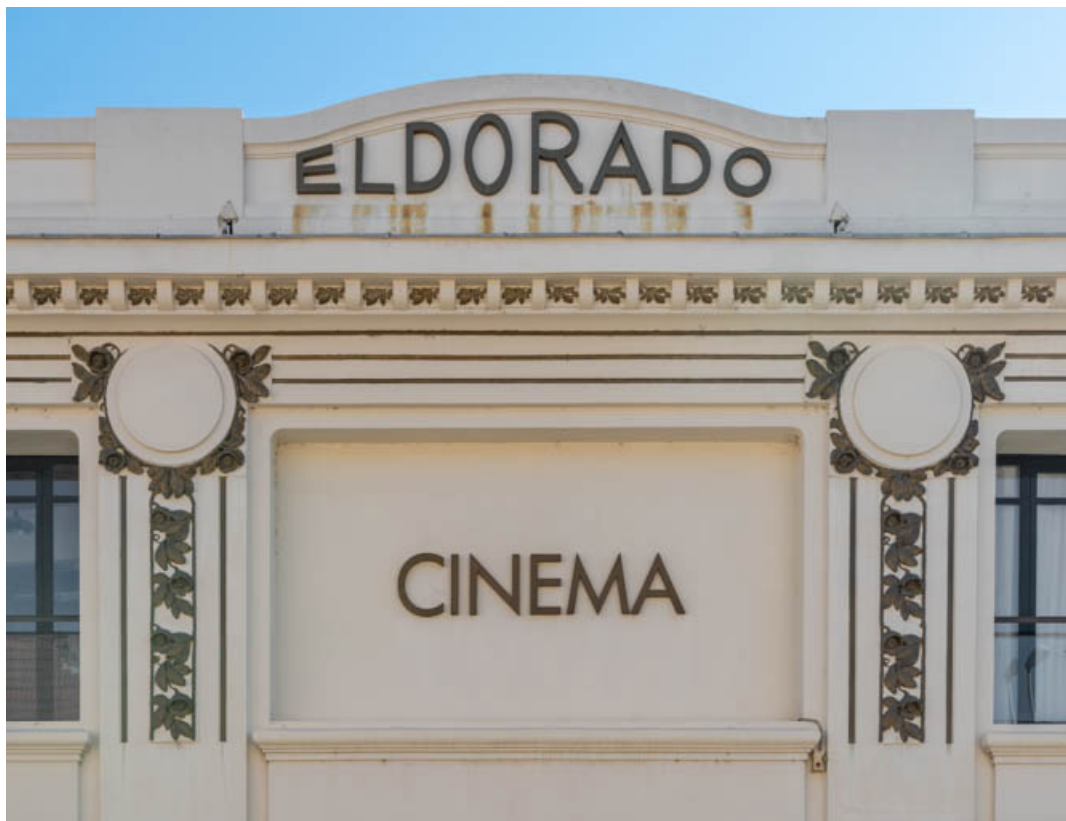
Façade antérieure : décor de la partie haute et couronnement.
