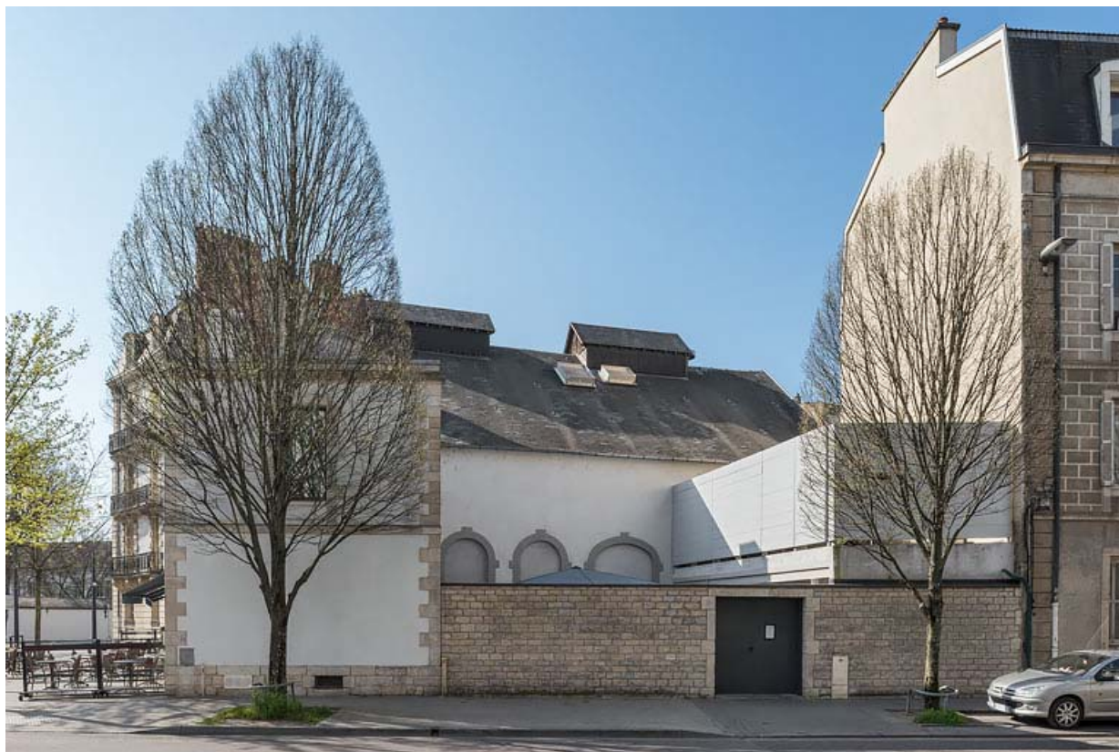
Façade latérale droite. 21, Dijon, 82 rue Devosge
