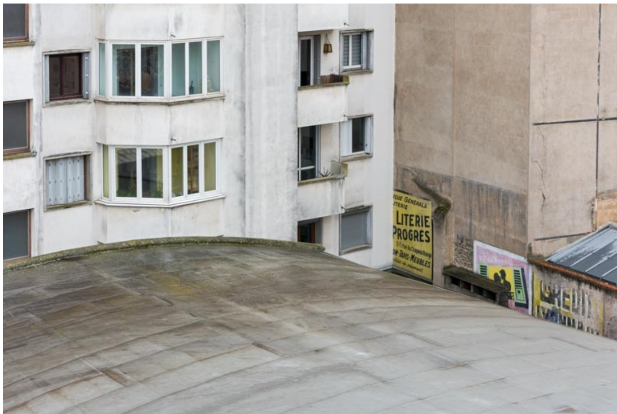
Immeuble rue Maréchal Foch (façade postérieure), salle 3 (toiture) et vestiges de peintures murales. 21, Dijon, 16-20 bis avenue du Maréchal Foch
