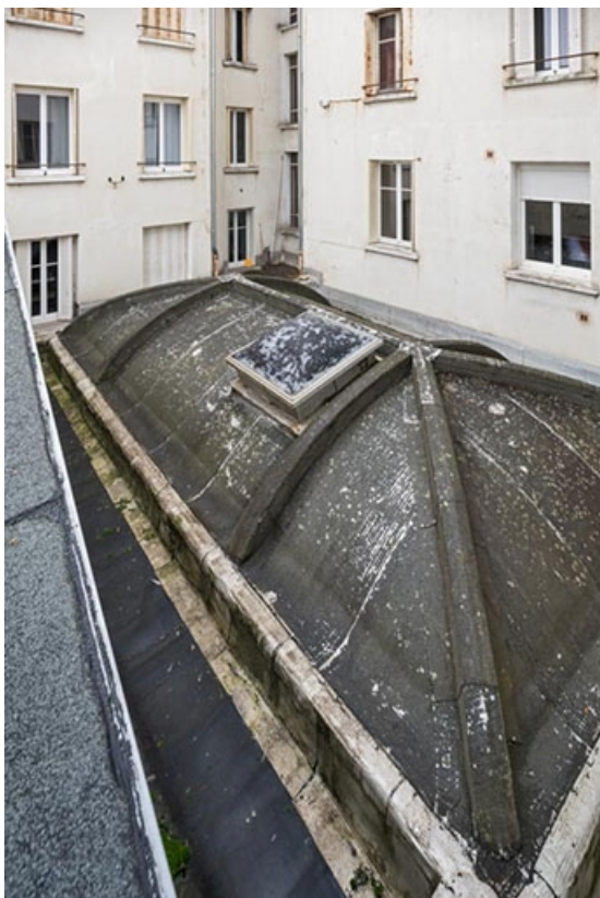
Toit de la salle 9, vu depuis celui de la salle 2.
