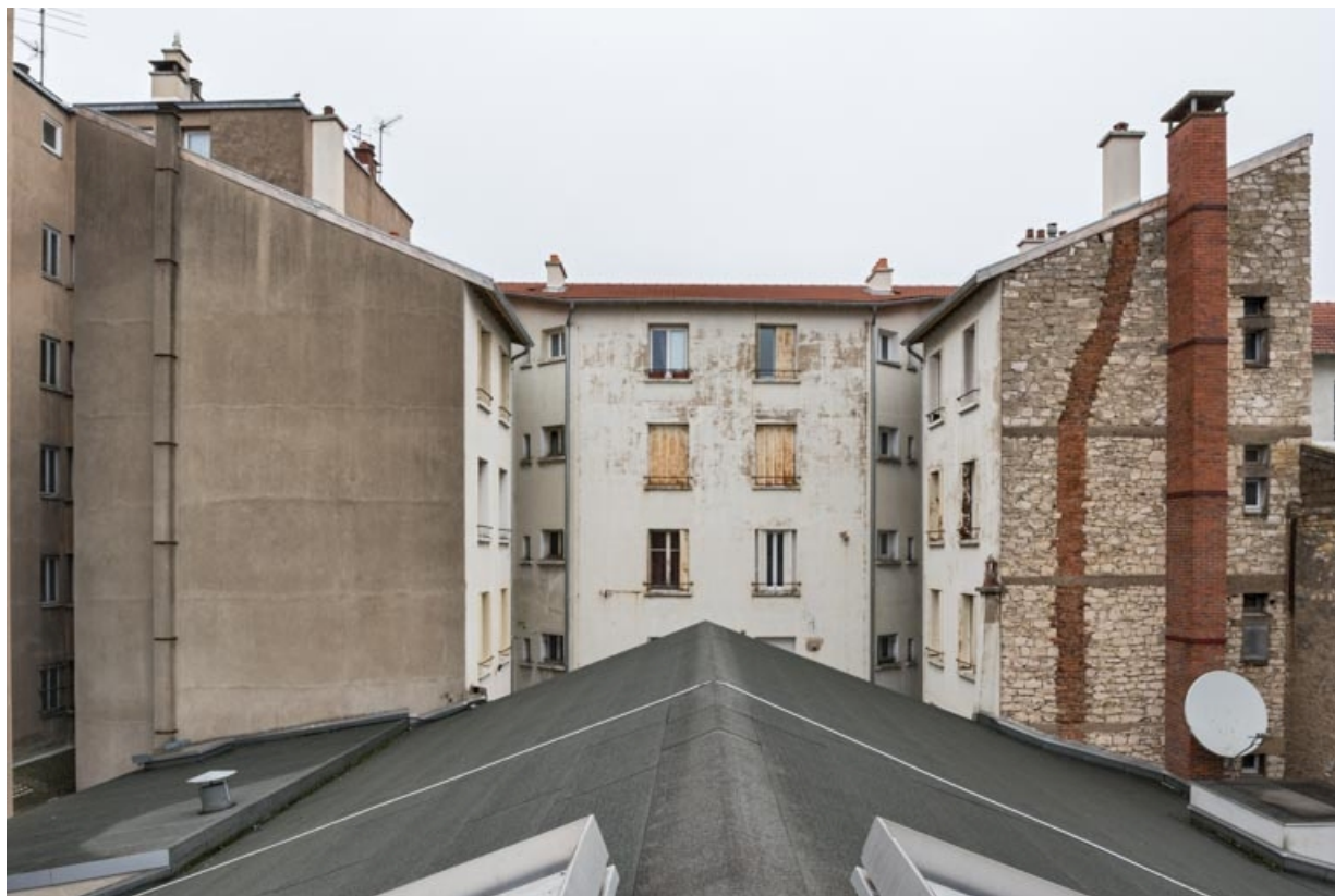
Façade postérieure, depuis le toit de la salle 2. 21, Dijon, 17-19 rue des Perrières
