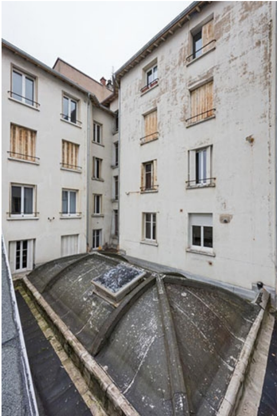
Façade postérieure, aile ouest et toit de la salle 9.
