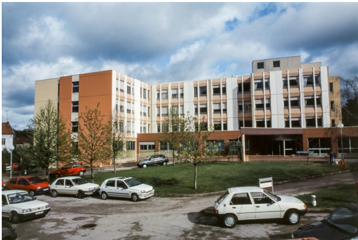
Bâtiment de l'établissement hospitalier pour personnes âgées dépendantes, vue d'ensemble. 21, Dijon, 2 rue Jules Violle
