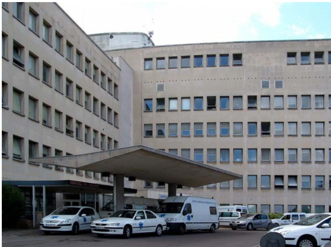
Entrée principale de l'hôpital et son auvent.
