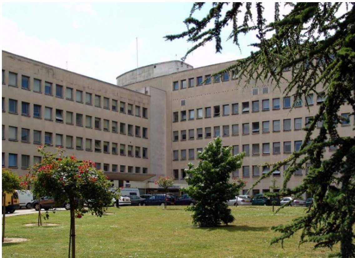
Corps principal, élévation sur le boulevard Maréchal-de-Lattre-de-Tassigny, vue générale. 21, Dijon, 2 boulevard Maréchal-de-Lattre-de-Tassigny
