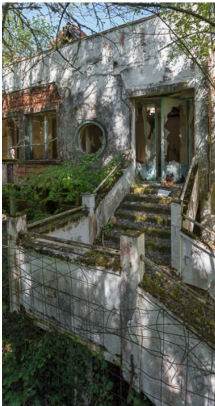
Bâtiment principal, façade antérieure, porte d'entrée précédée de son perron. 21, R.D.17 Magnien rue de la Source, lieudit : écart de Maizières
