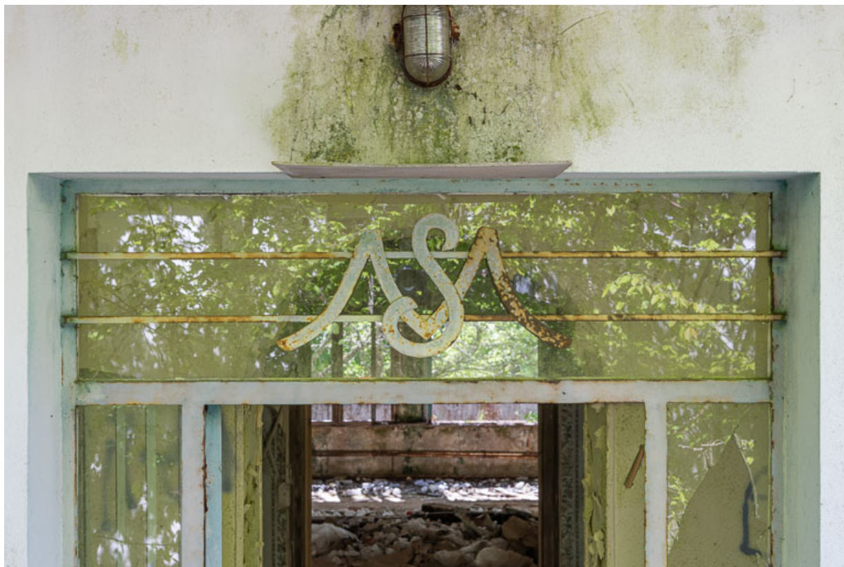
Bâtiment principal, façade postérieure, porte d'entrée, détail. 21, R.D.17 Magnien rue de la Source, lieudit : écart de Maizières
