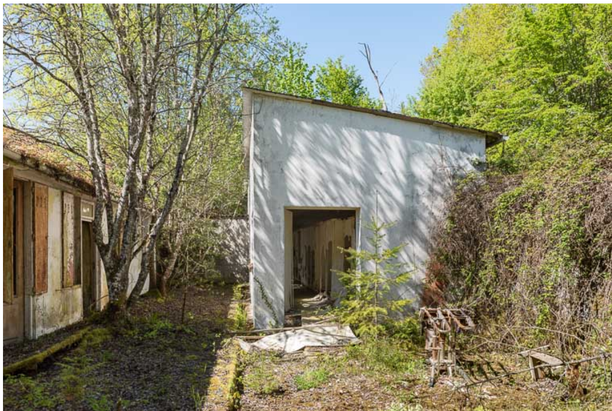
Bâtiment des bains, vue extérieure.
