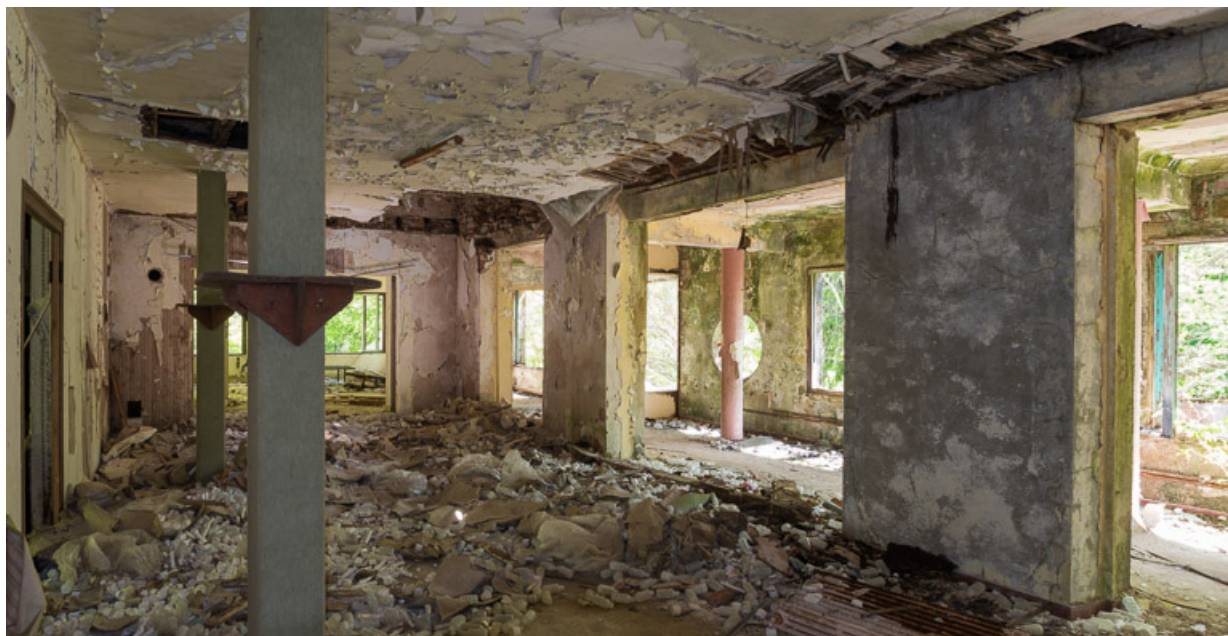
Bâtiment principal, vue intérieure de la salle commune au rez-de-chaussée.
