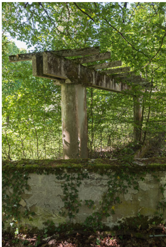
Pergola, vue depuis le nord-est, détail.
