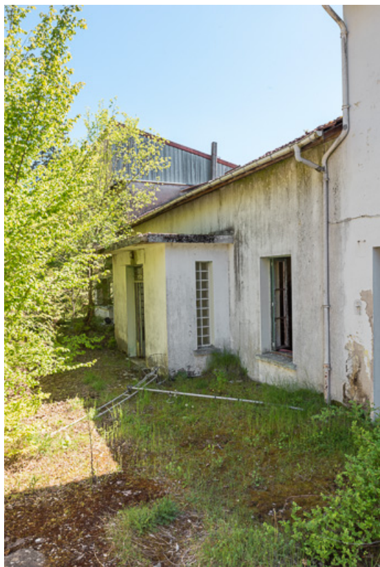
Bâtiment principal, façade postérieure, vue de trois-quarts avec l'entrée en saillie.
