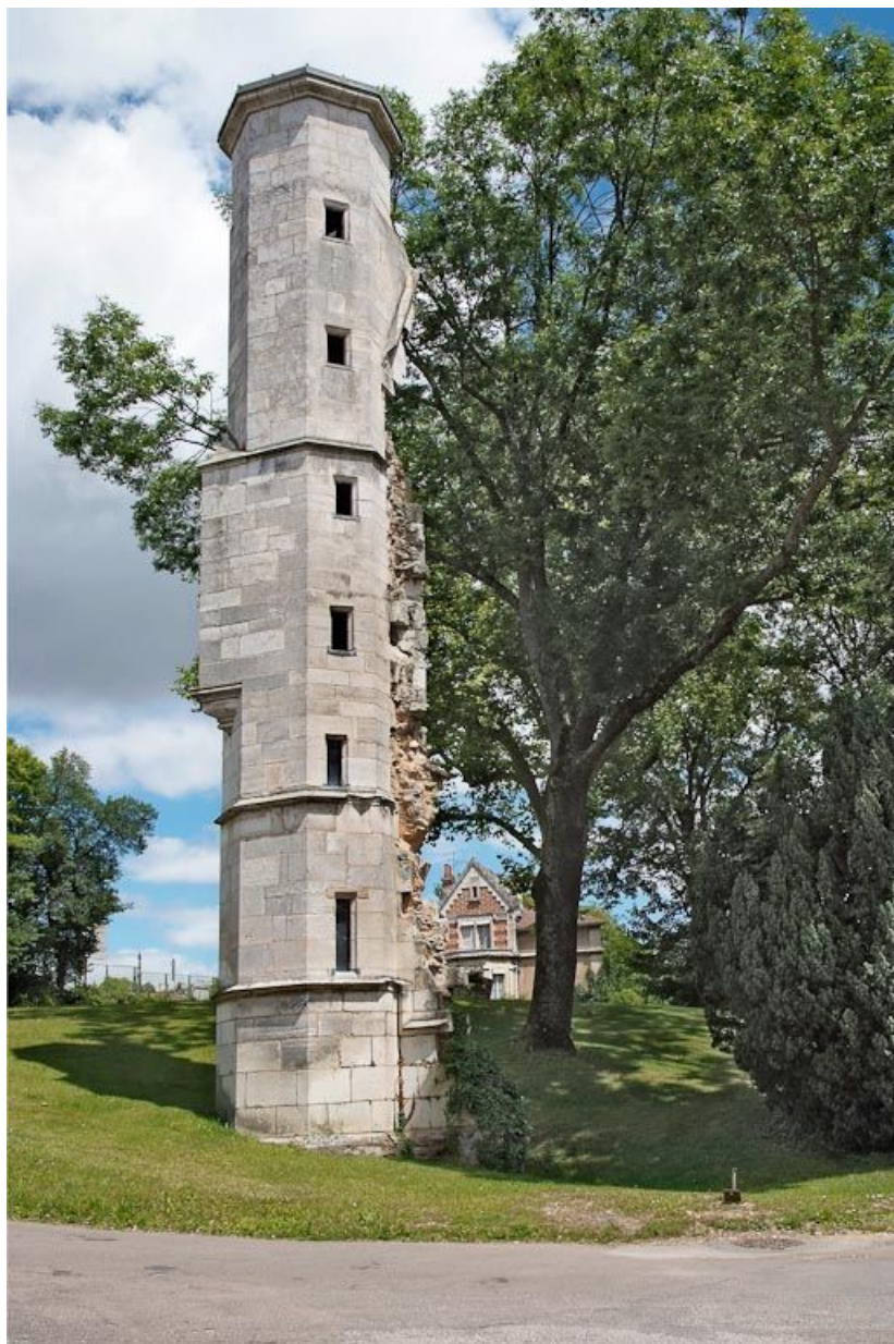
Tourelle d'escalier de l'ancien oratoire.
