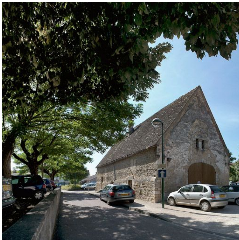
Façade antérieure et élévation gauche. 21, Beaune Moulin-Saint-Jacques
