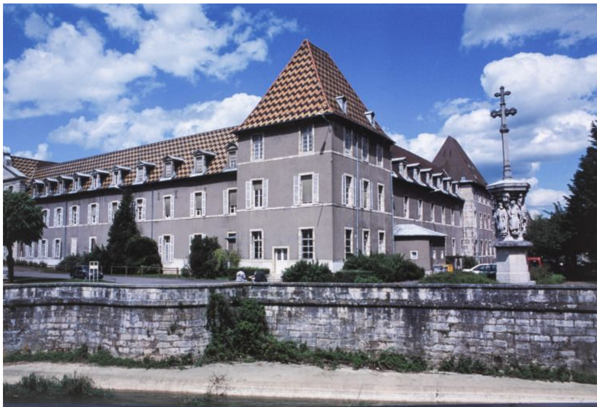
Vue prise du sud-ouest.
