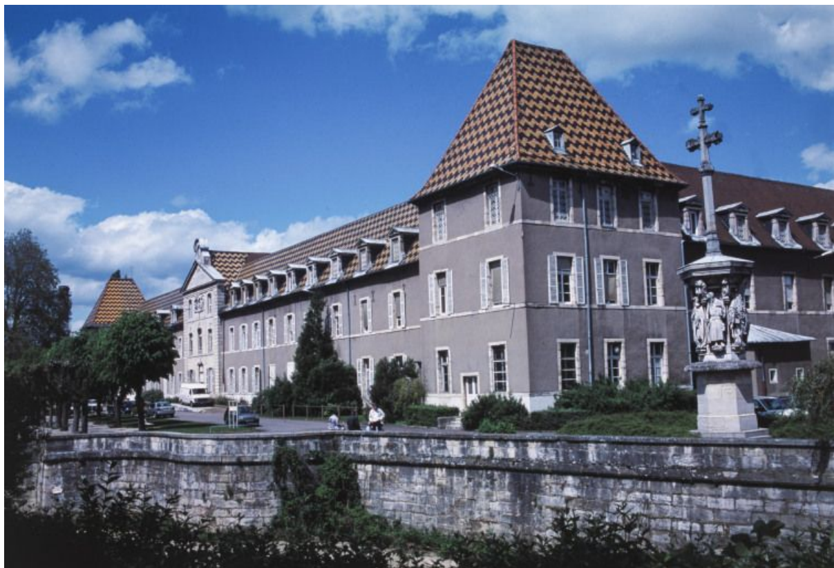
Façade postérieure (ouest) et croix de l'ancien cimetière. 21, Dijon Hôpital
