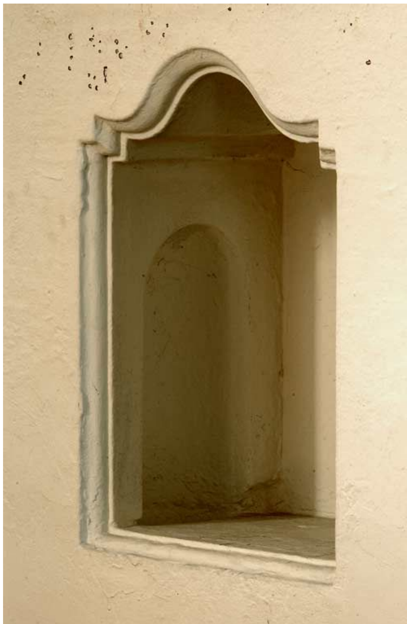
Aile droite : chapelle, lavabo du mur droit du chœur.
