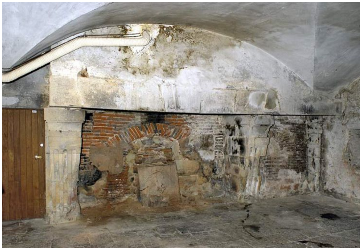
Ancien hôtel du gouverneur : sous-sol, cheminée.
