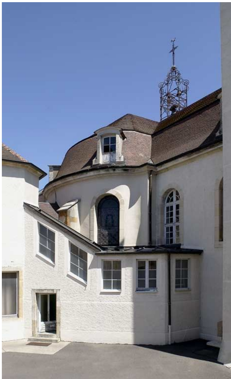
Aile droite : élévation postérieure, chevet de la chapelle.
