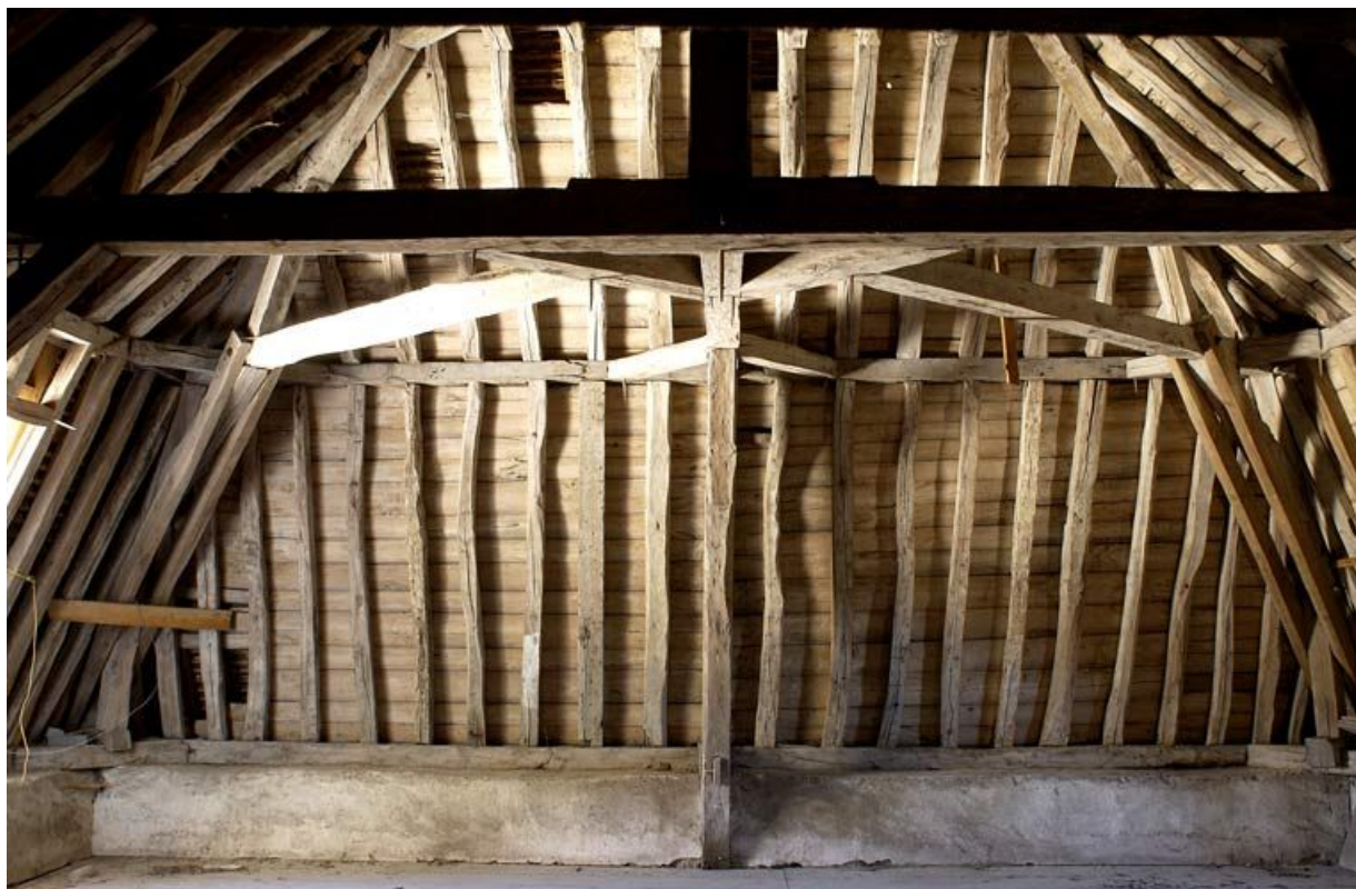
Aile droite : charpente, croupe sur la salle Sainte-Marthe. 21, Semur-en-Auxois, 7 rue de l' Hôpital
