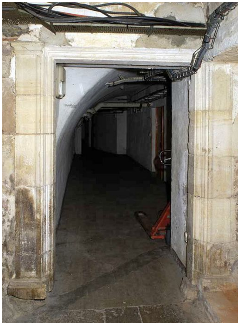
Ancien hôtel du gouverneur : sous-sol, porte. 21, Semur-en-Auxois, 7 rue de l' Hôpital
