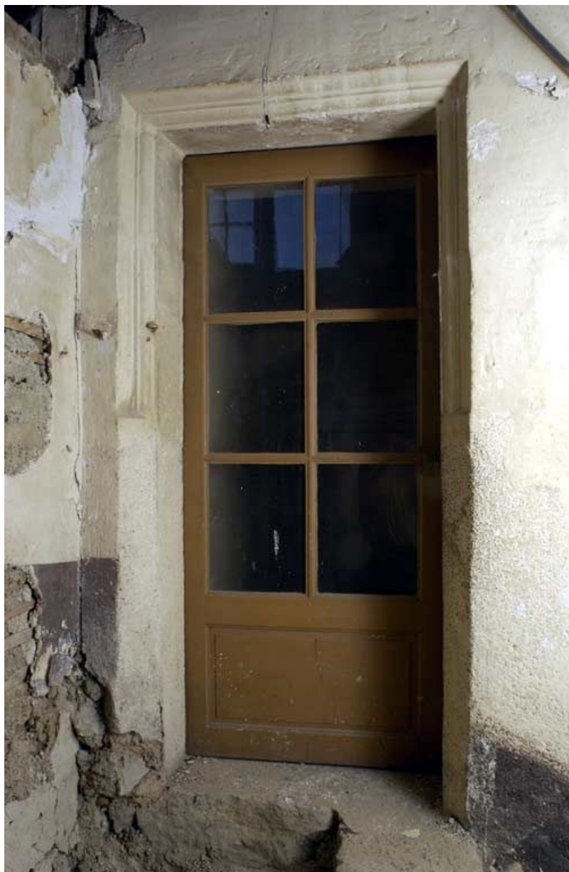
Ancien hôtel du gouverneur : fenêtre transformée en porte au fond du passage donnant accès au laboratoire. 21, Semur-en-Auxois, 7 rue de l' Hôpital
