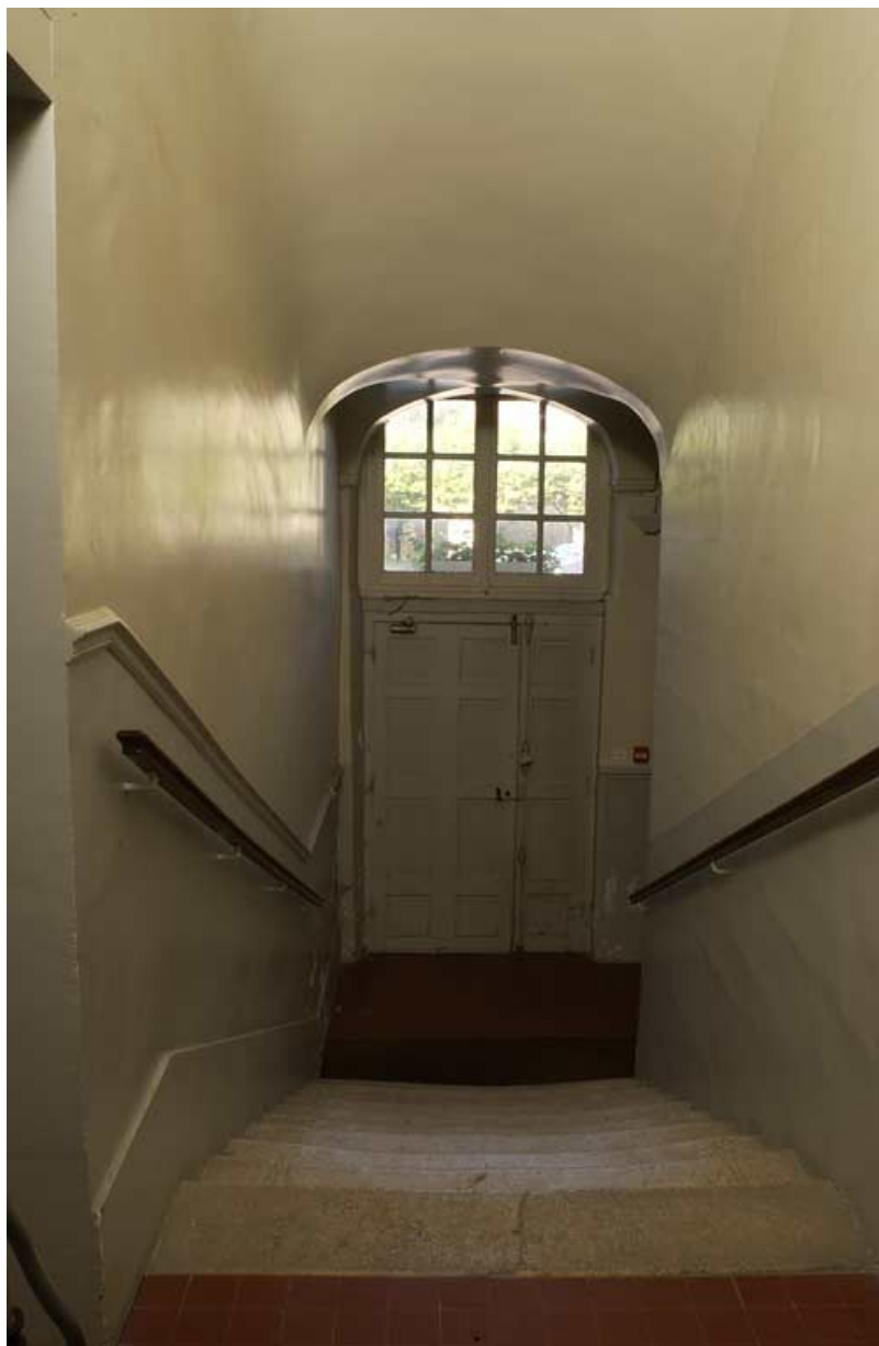
Ancien hôtel du gouverneur : escalier rampe sur rampe, 2e volée entre le rez-de-chaussée surélevé et la porte d'entrée principale. 21, Semur-en-Auxois, 7 rue de l' Hôpital
