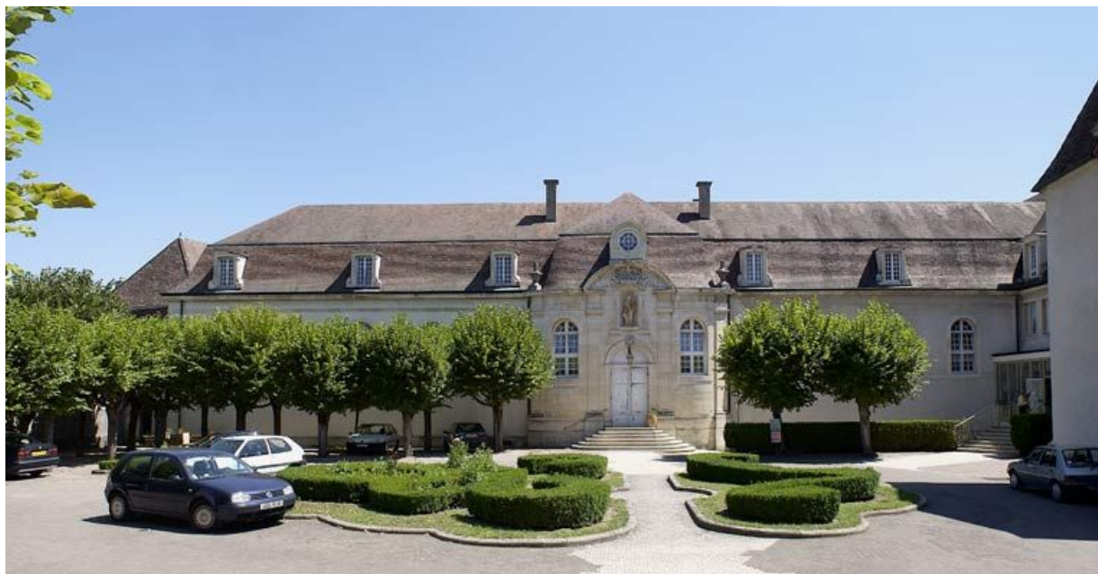
Aile gauche dite fondation Arnault : élévation sur la cour antérieure.
