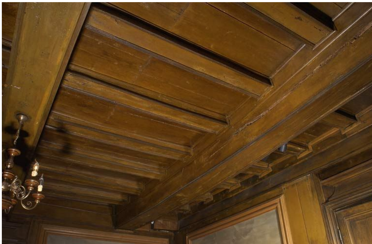
Ancien hôtel du gouverneur : salon, plafond à solives apparentes. 21, Semur-en-Auxois, 7 rue de l' Hôpital
