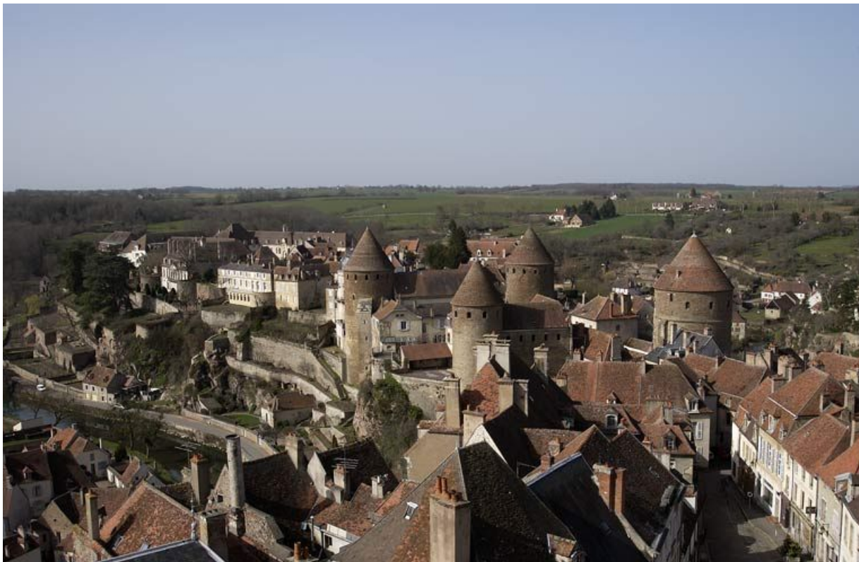
Vue d'ensemble de l'hôpital prise depuis les toits de la collégiale Notre-Dame. 21, Semur-en-Auxois, 7 rue de l' Hôpital
