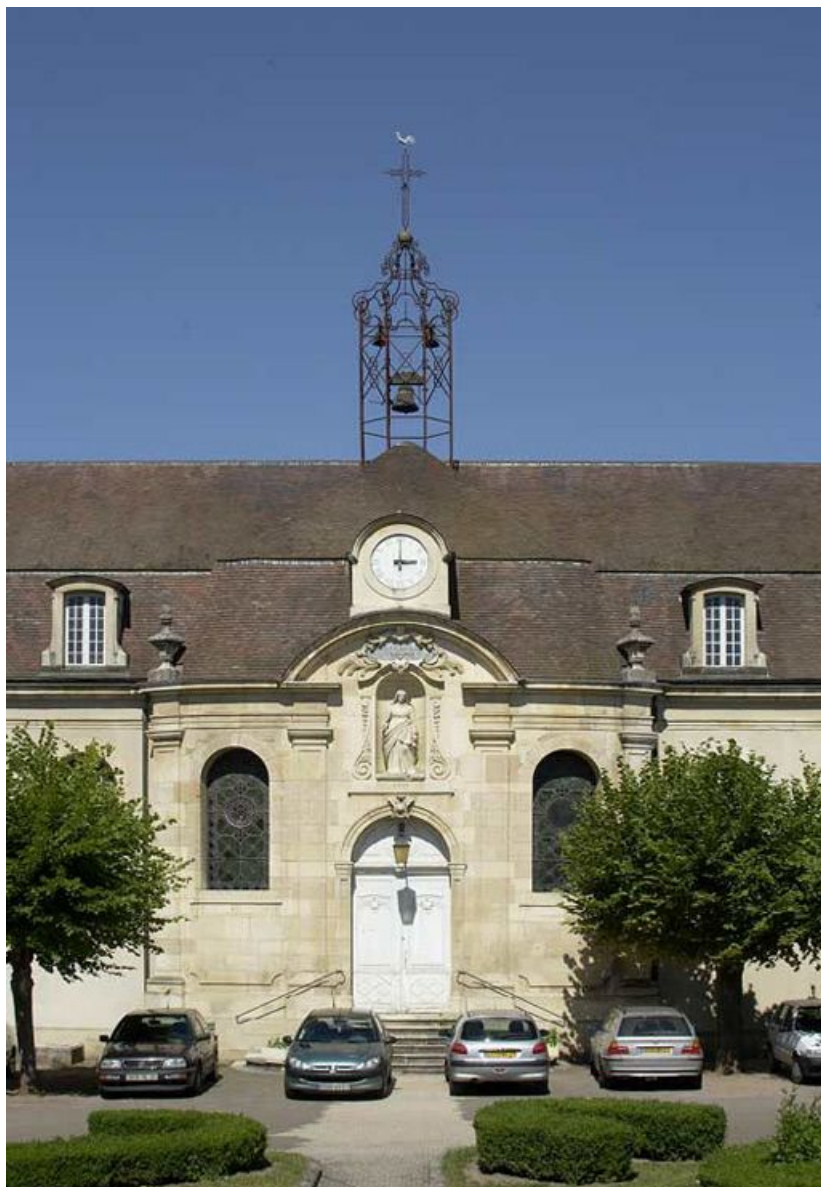
Aile droite : élévation sur la cour antérieure, travée de la chapelle.
