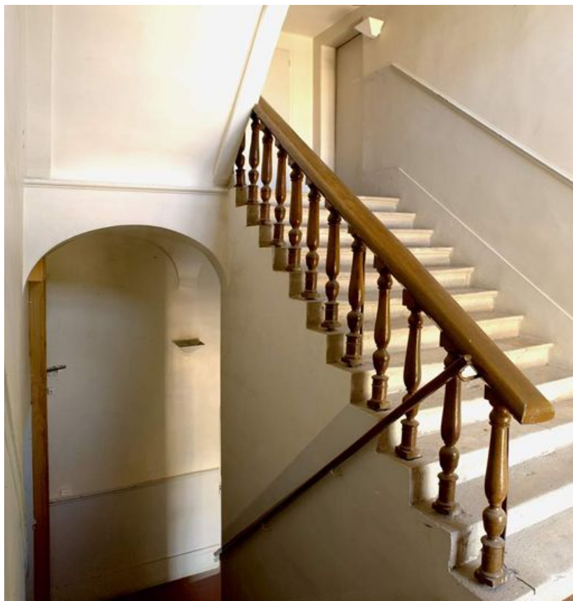
Ancien hôtel du gouverneur : escalier rampe sur rampe, 4e volée à rampe d'appui à balustres. 21, Semur-en-Auxois, 7 rue de l' Hôpital
