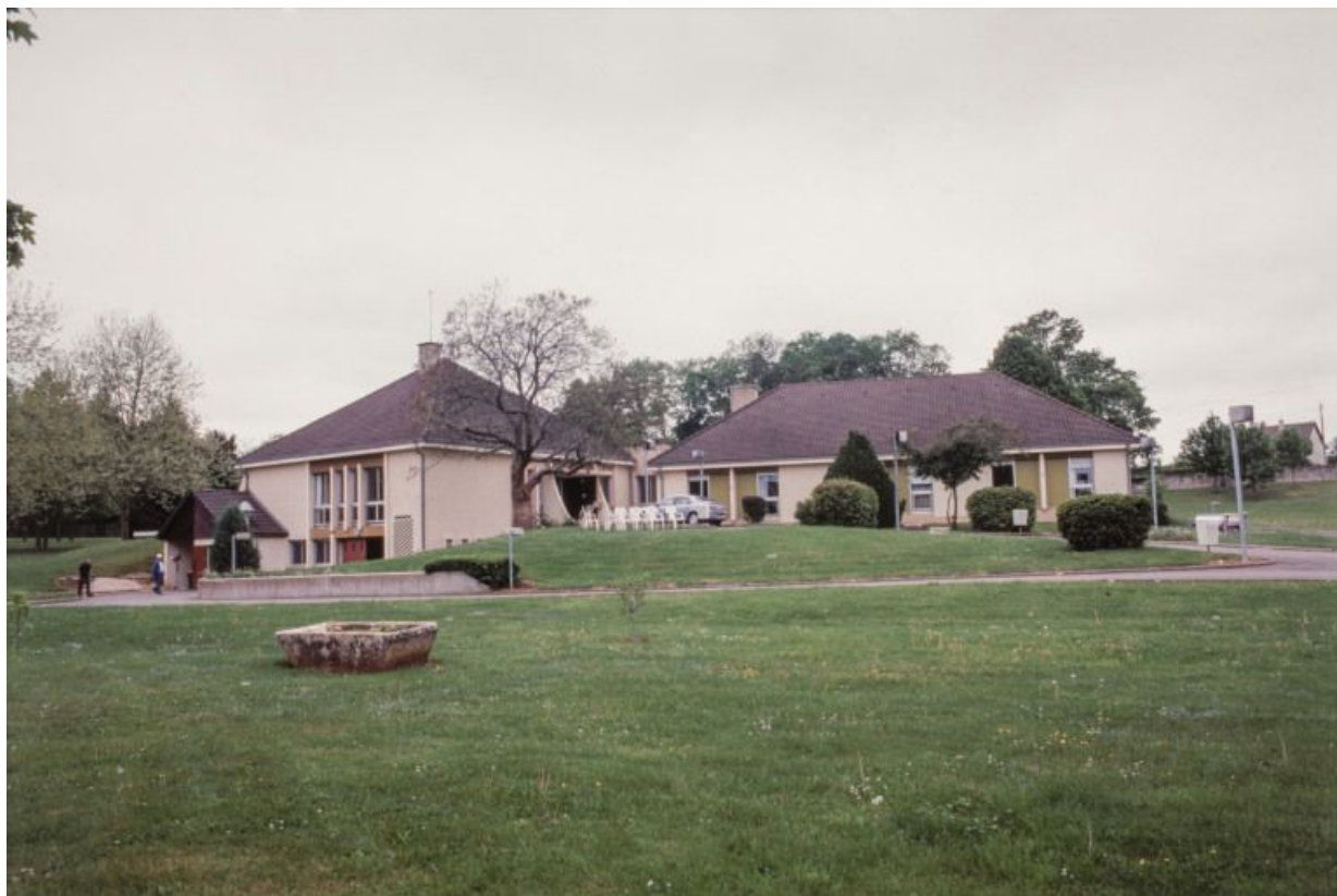
Vue d'ensemble des bâtiments.
