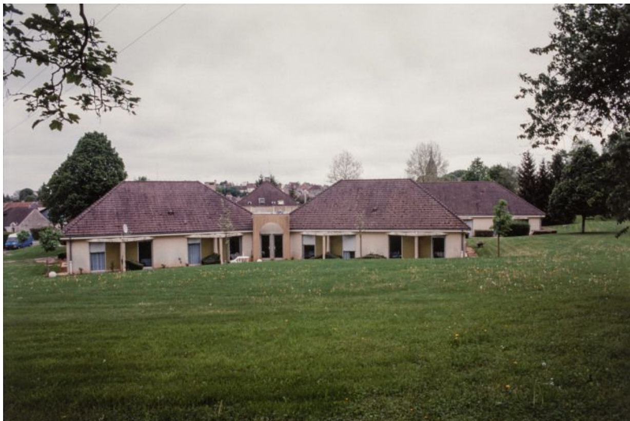
Vue d'ensemble des bâtiments.
