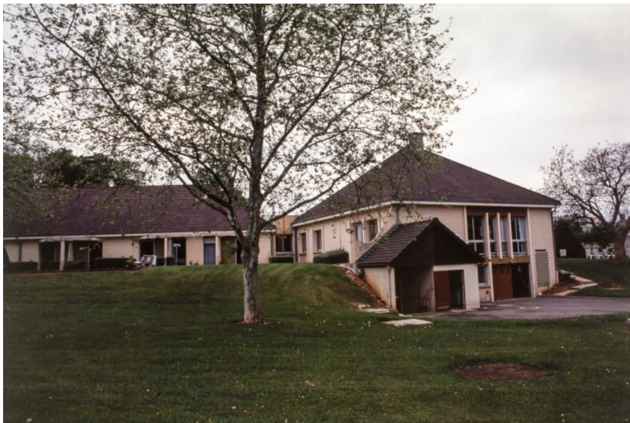
Vue des façades des pavillons.
