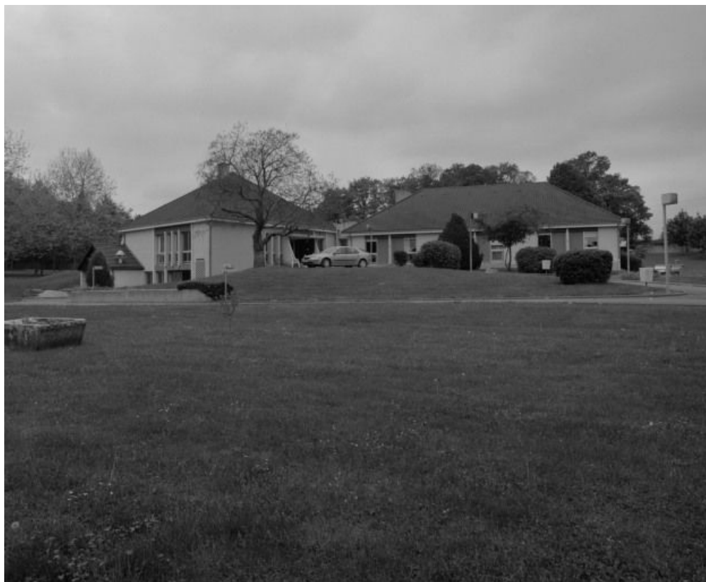
Vue d'ensemble des bâtiments.
