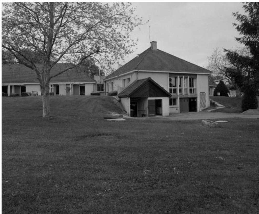
Vue des façades des pavillons.
