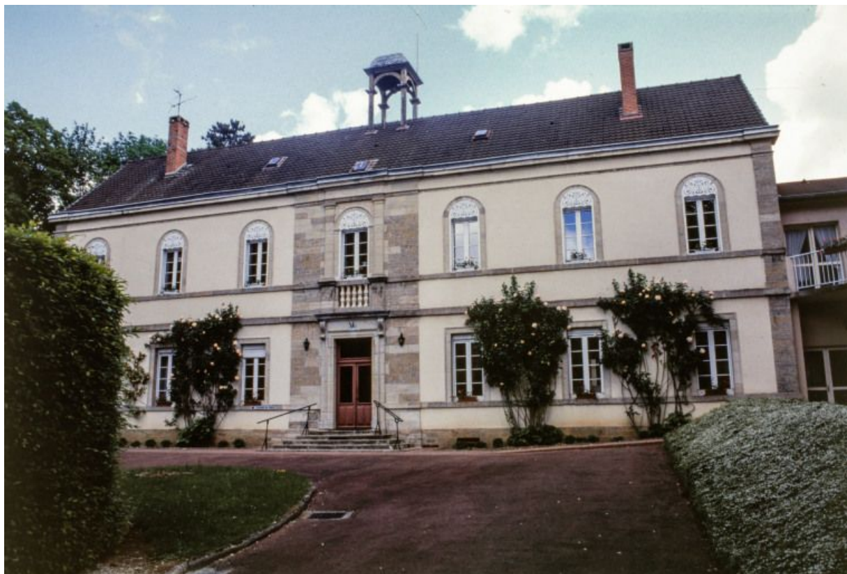
Partie centrale de la façade sur jardin. 21, Pouilly-en-Auxois général de Gaulle
