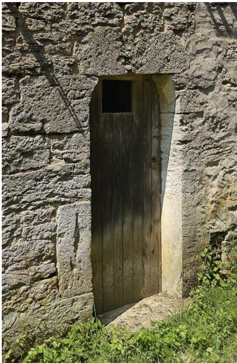
Logis de l'ancienne Maison-Dieu, détail de la porte à linteau sur coussinets. 21, Saffres C.R. 17, lieudit : Maison-Dieu
