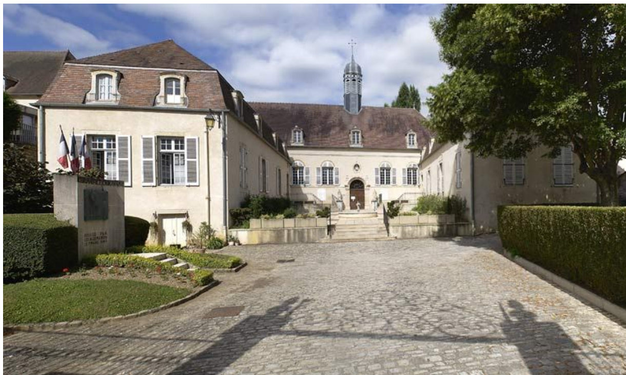
Façade principale depuis le portail.
