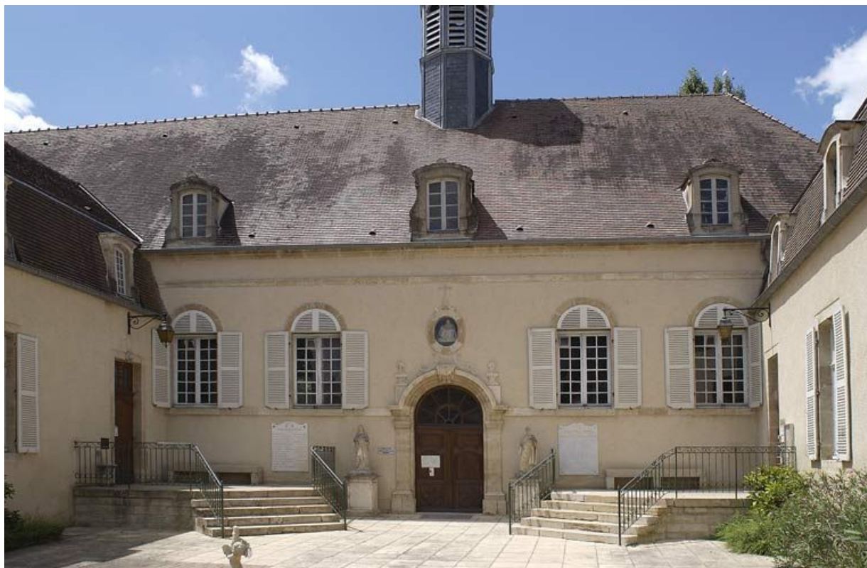
Corps central de la façade principale.
