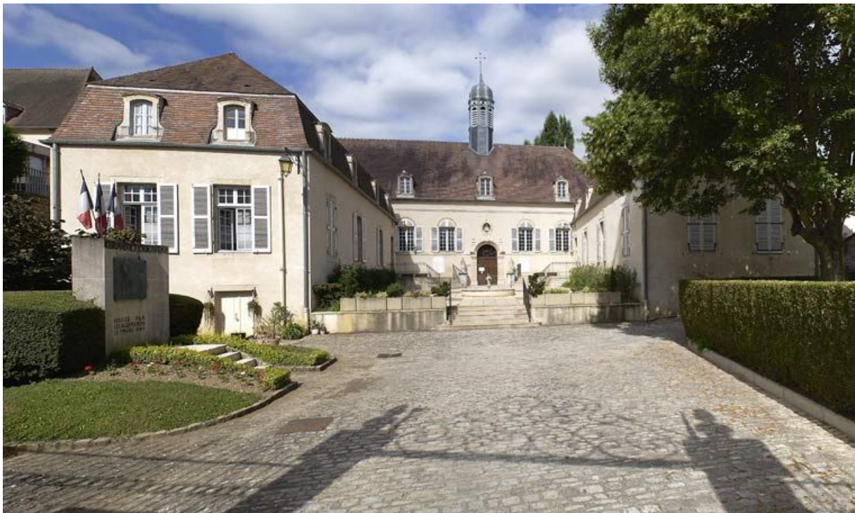
Façade principale depuis le portail.
