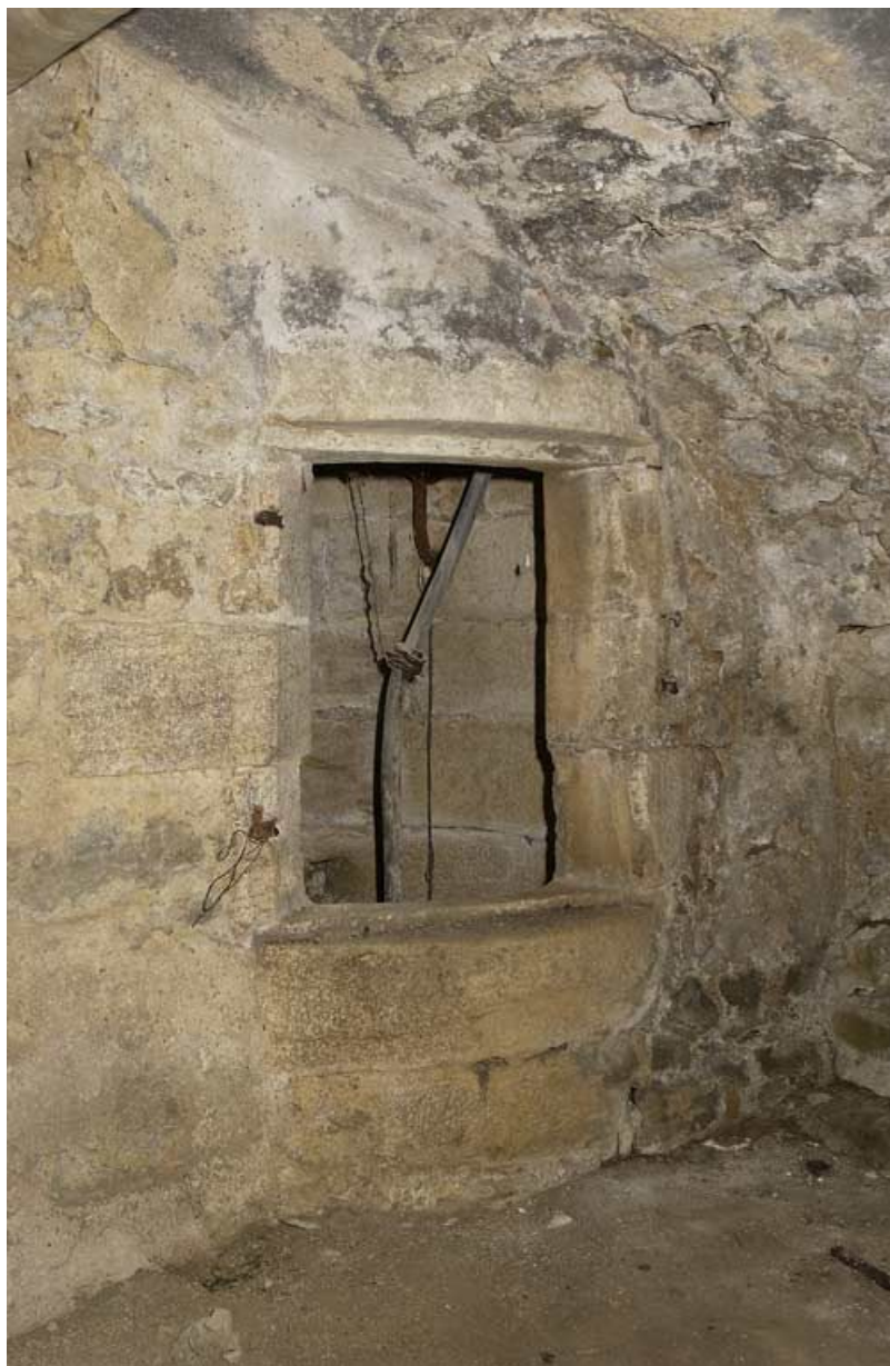
Puits dans les caves de l'ancien couvent des minimes.
