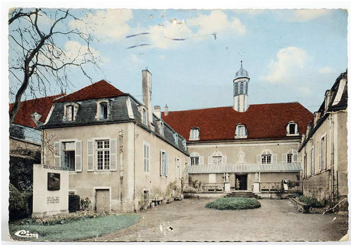
Vue de la façade principale, carte postale vers 1950-1960.
