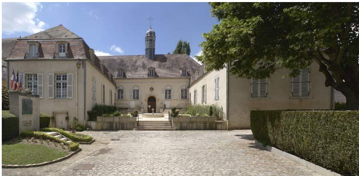
Façade sur cour principale.
