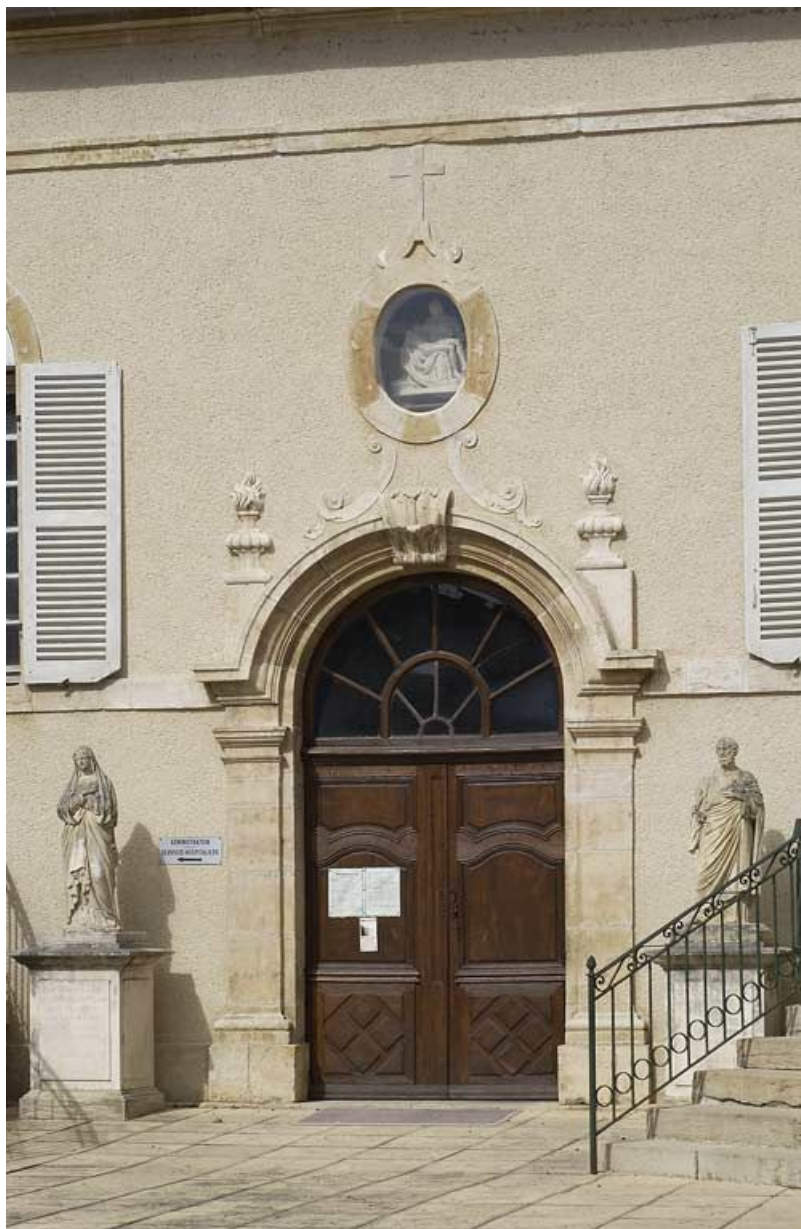
Portail d'entrée de la chapelle.
