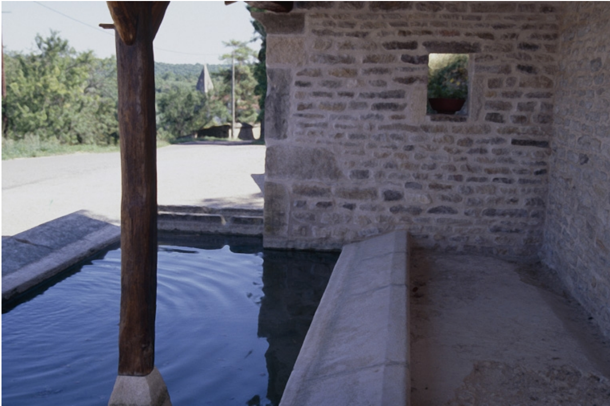
Vue intérieure. 21, Baubigny
