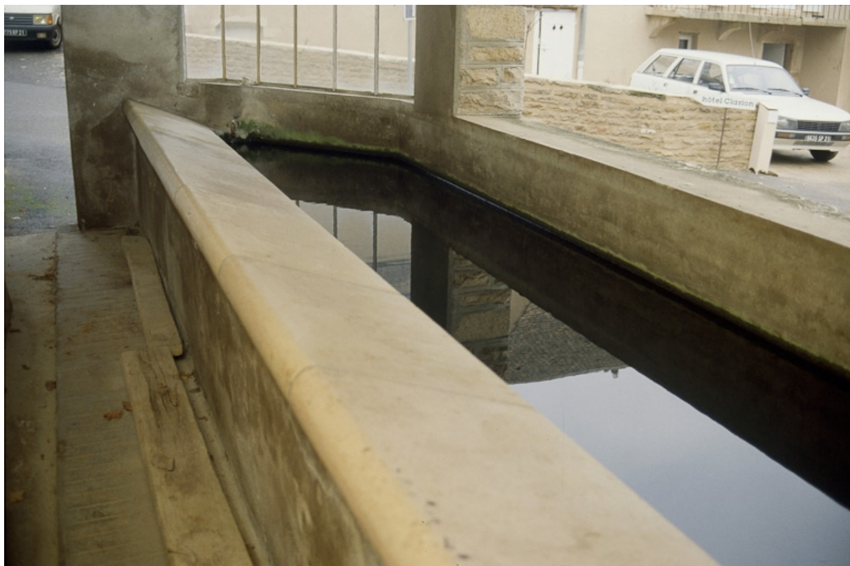
Vue générale intérieure.
