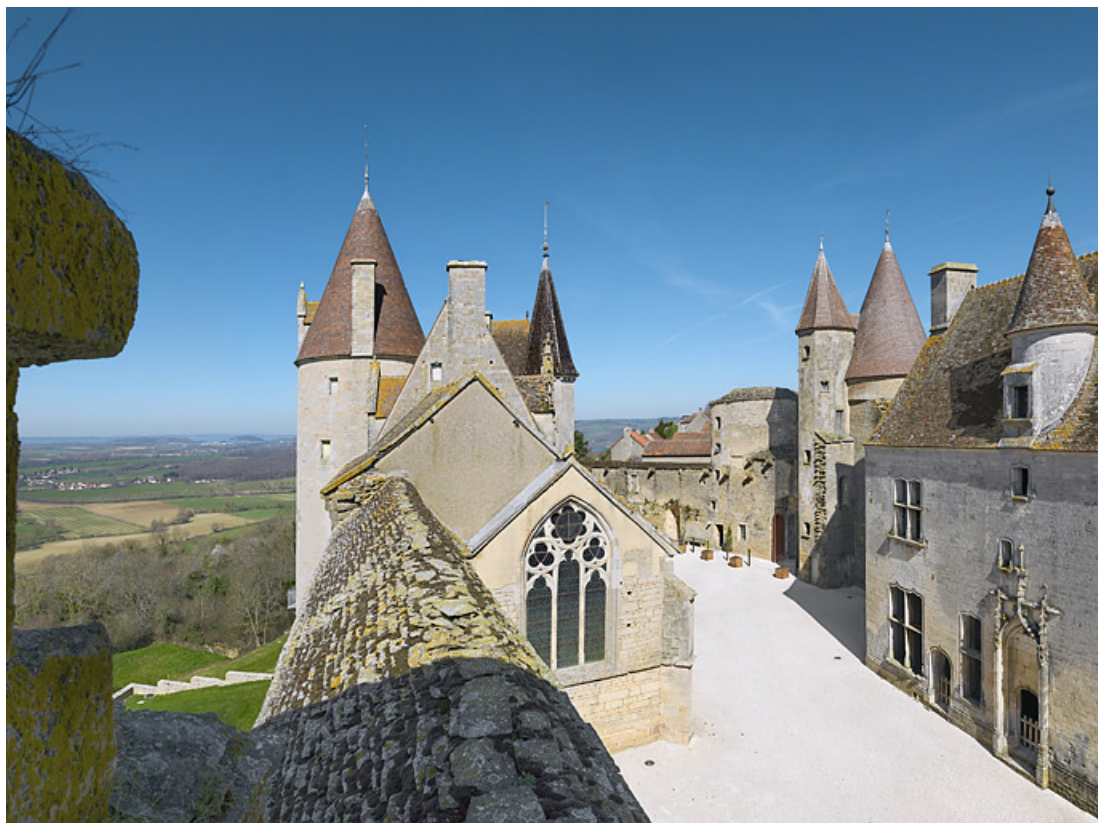
La cour avec la chapelle vues du chemin de ronde. 21, Châteauneuf
