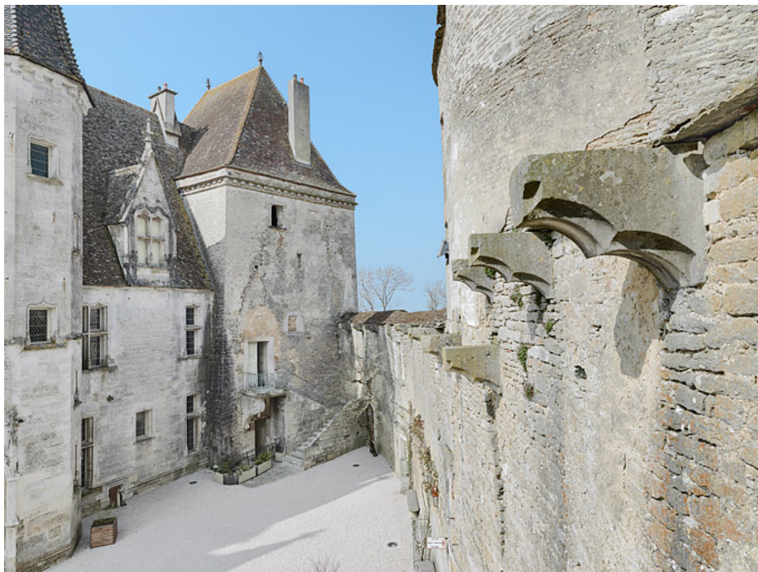
La cour en direction de la tour carrée. 21, Châteauneuf
