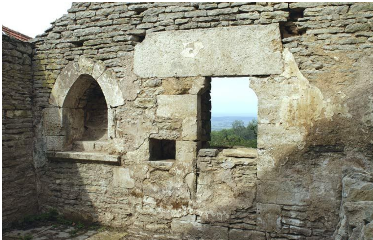
Chapelle, mur ouest, en 2002.
