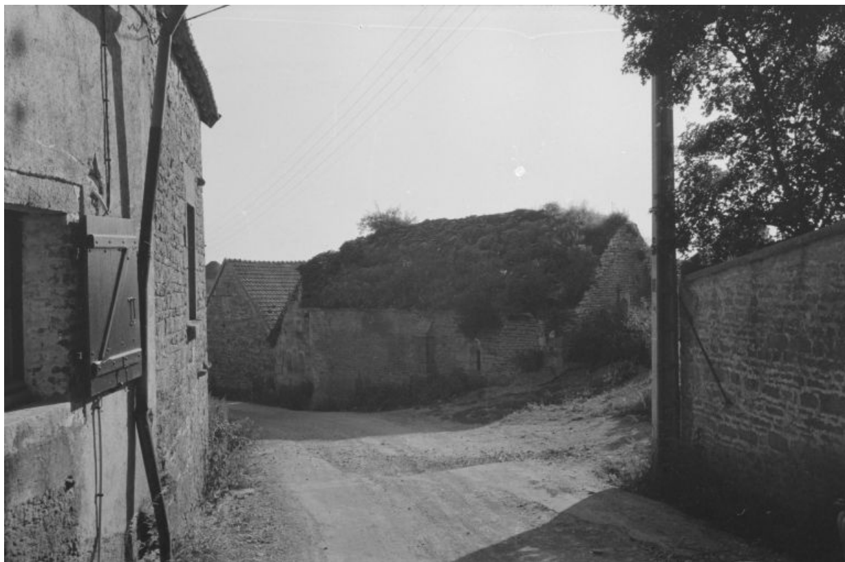
Vue d'ensemble (état en 1968).
