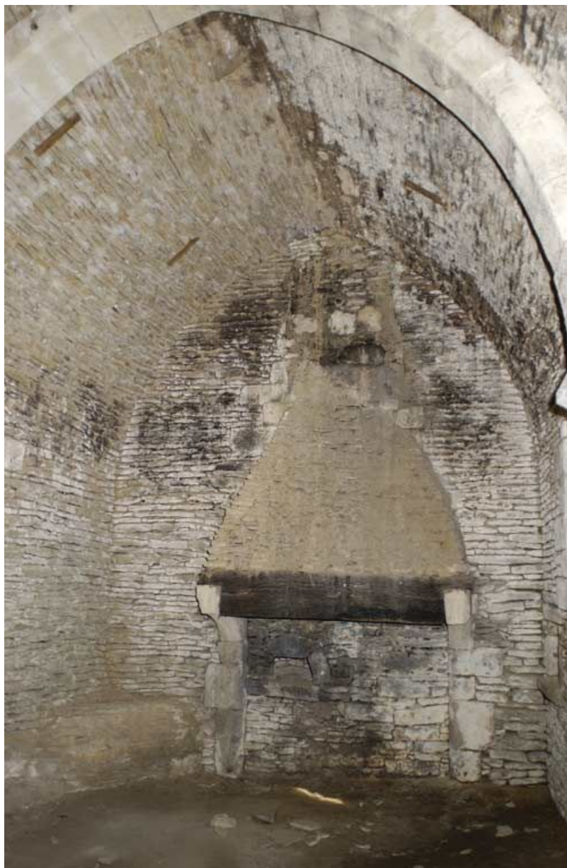
Salle voûtée, vue intérieure côté nord, en 2002. 21, Mont-Saint-Jean Bergeries
