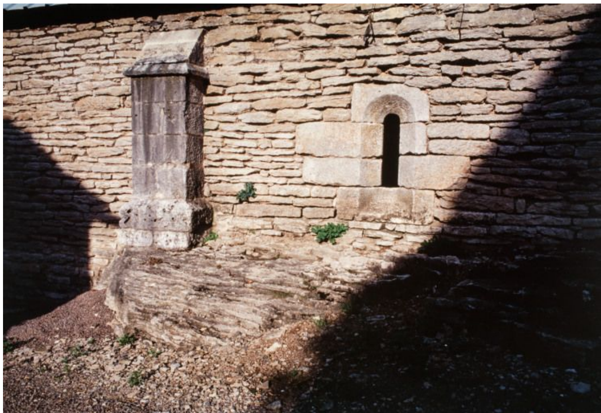
Contrefort et baie de l'élévation est de la salle voûtée.
