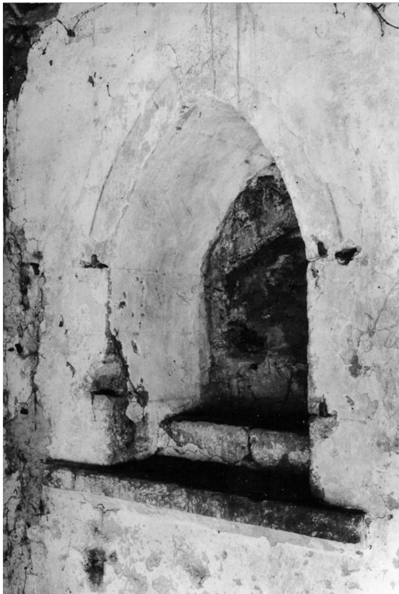
Chapelle, niche du mur ouest, en 1975.
