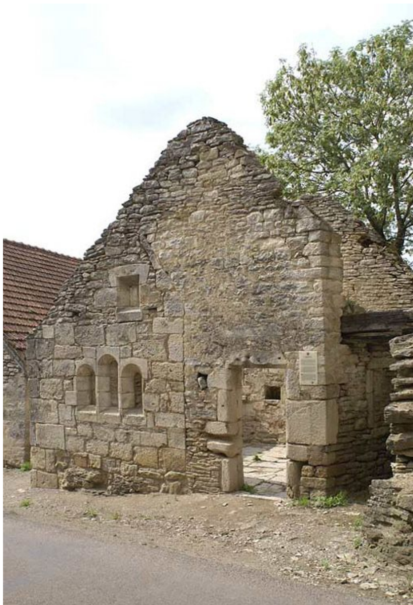
Chapelle, élévation est, en 2002. 21, Mont-Saint-Jean Bergeries
