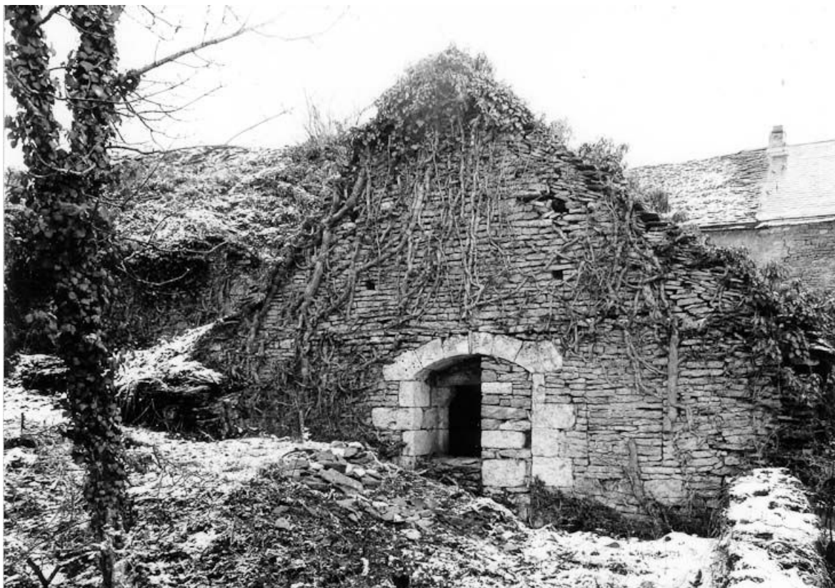
Chapelle, vue depuis le sud-ouest, en 1975. 21, Mont-Saint-Jean Bergeries
