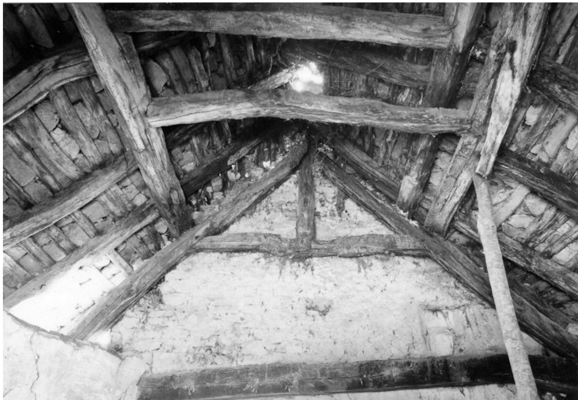
Charpente de la chapelle en 1975.
