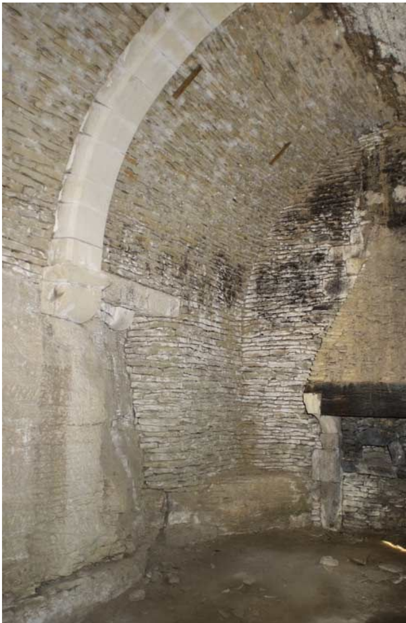
Salle voûtée, mur ouest, en 2002.
