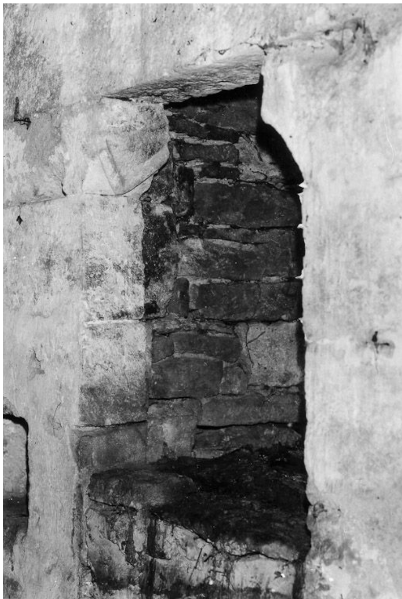
Chapelle, porte du mur ouest, en 1975. 21, Mont-Saint-Jean Bergeries
