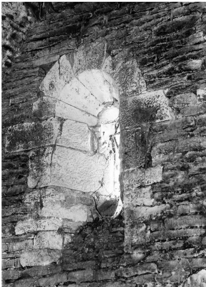
Salle voûtée, baie du mur sud, en 1975. 21, Mont-Saint-Jean Bergeries
