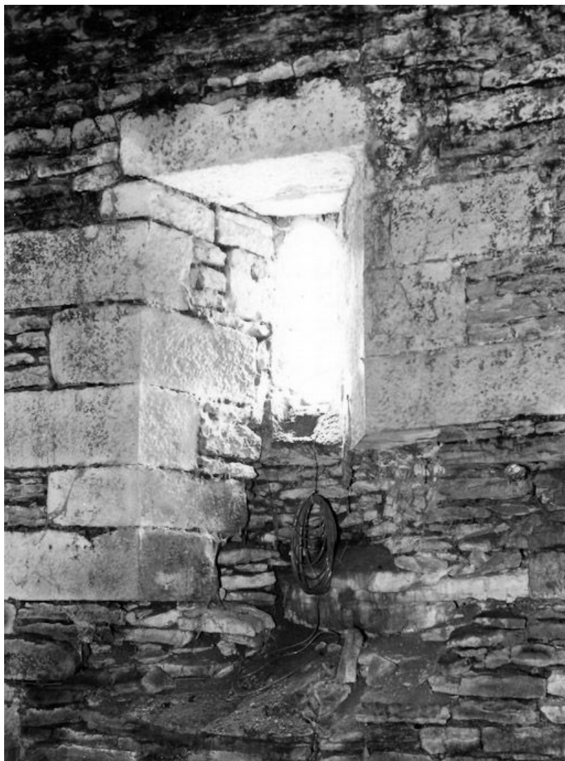
Salle voûtée, baie du mur est, en 1975. 21, Mont-Saint-Jean Bergeries
