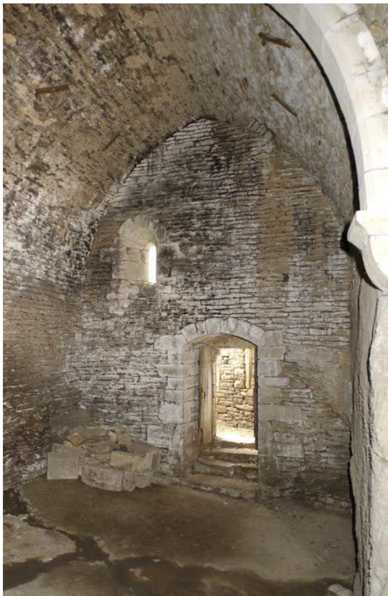
Salle voûtée, mur sud, 2002. 21, Mont-Saint-Jean Bergeries
