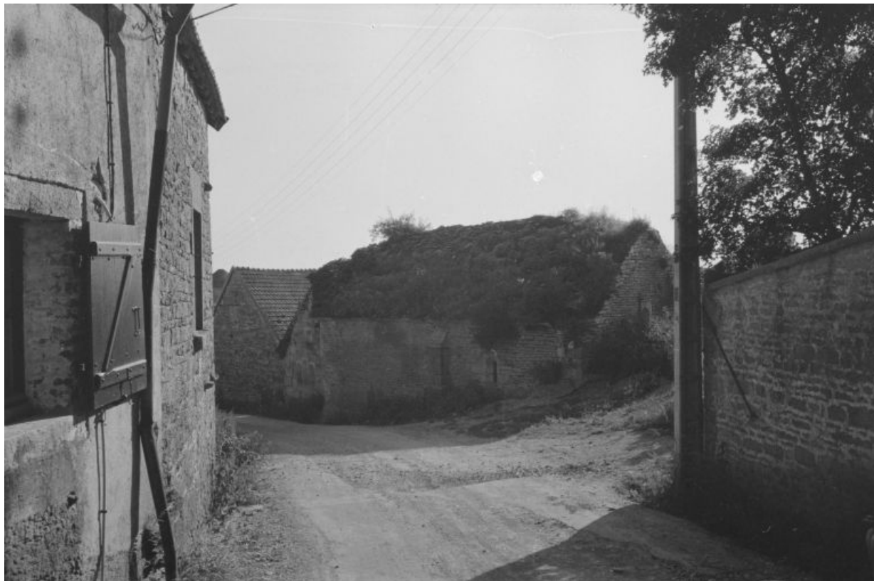
Vue d'ensemble (état en 1968).
