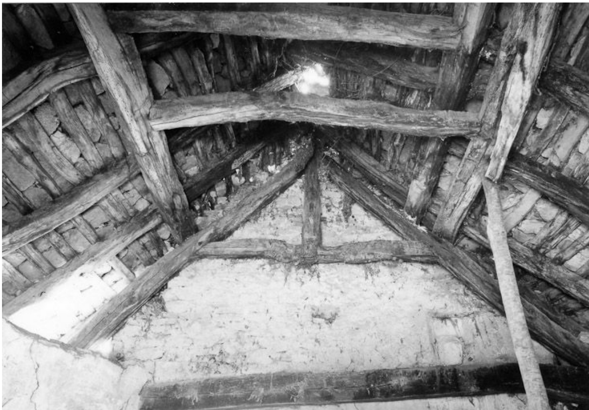
Charpente de la chapelle en 1975.
