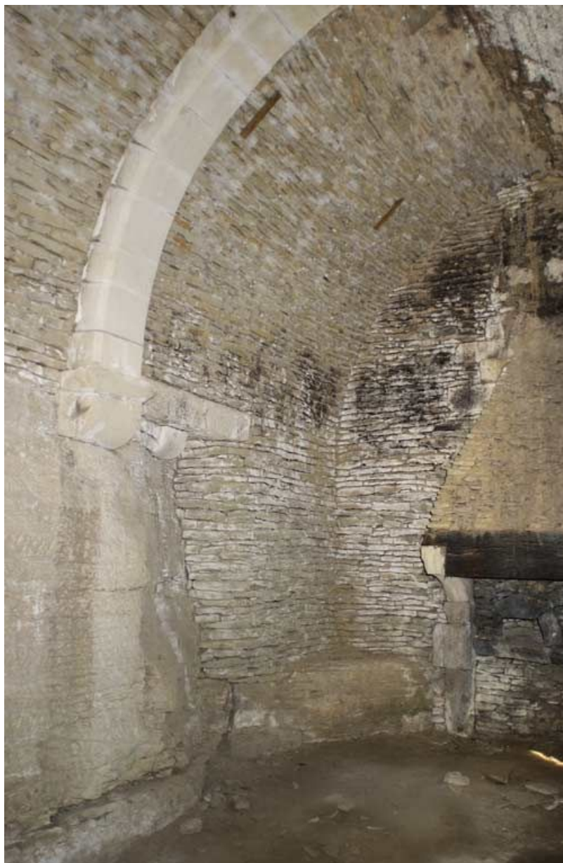
Salle voûtée, mur ouest, en 2002.
