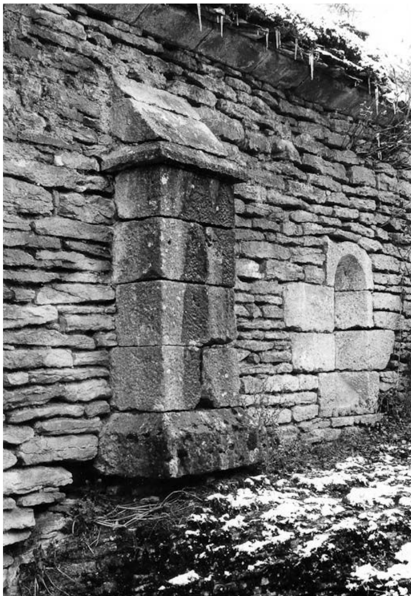
Salle voûtée, contrefort du mur est, en 1975.
