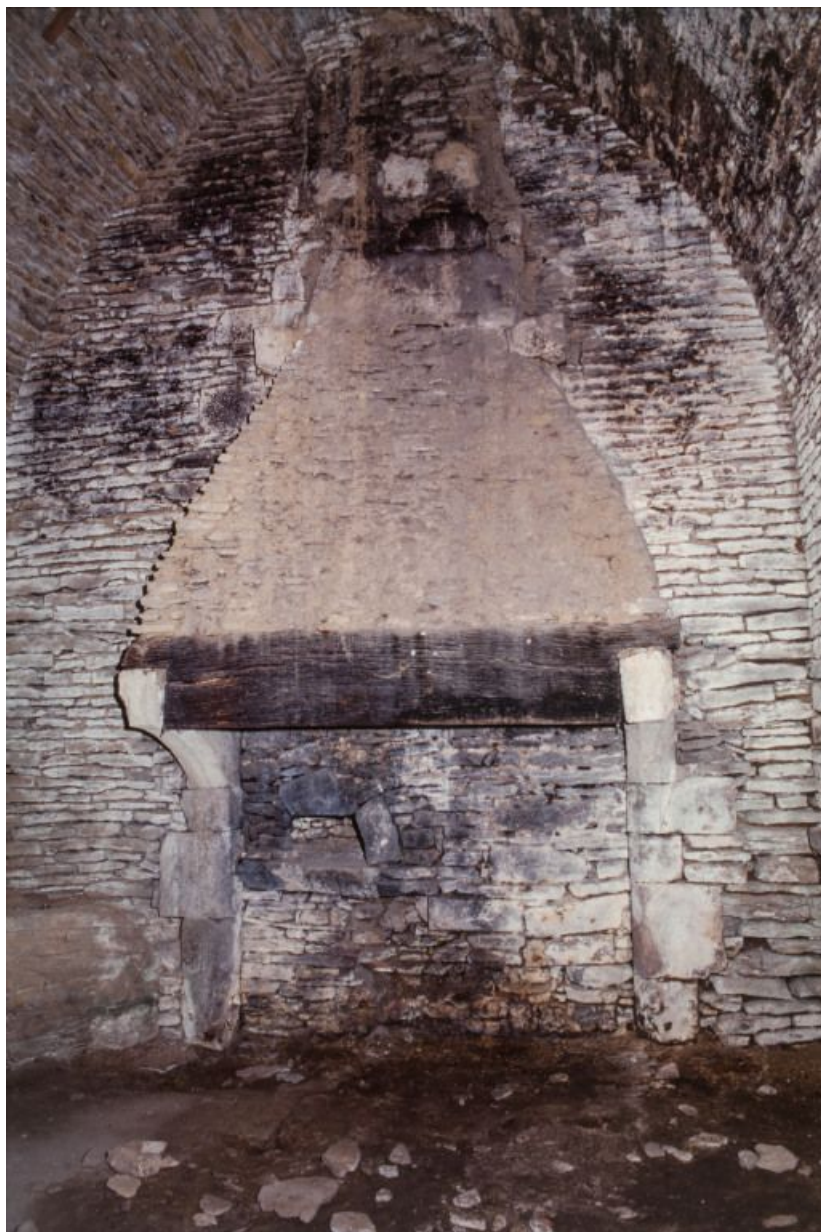
Grande salle : vue intérieure.
