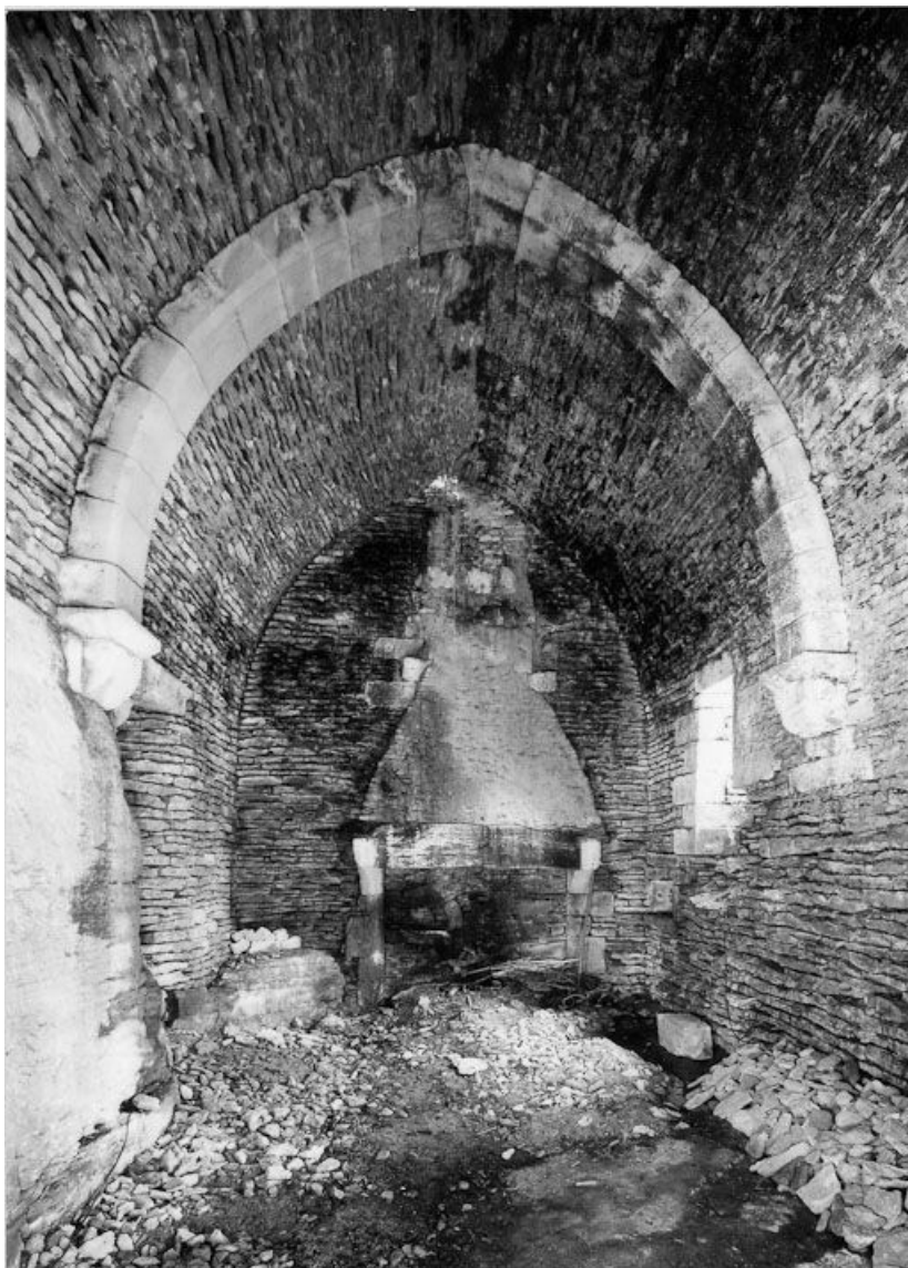
Salle voûtée, vue intérieure depuis l'entrée, en 1975. 21, Mont-Saint-Jean Bergeries
