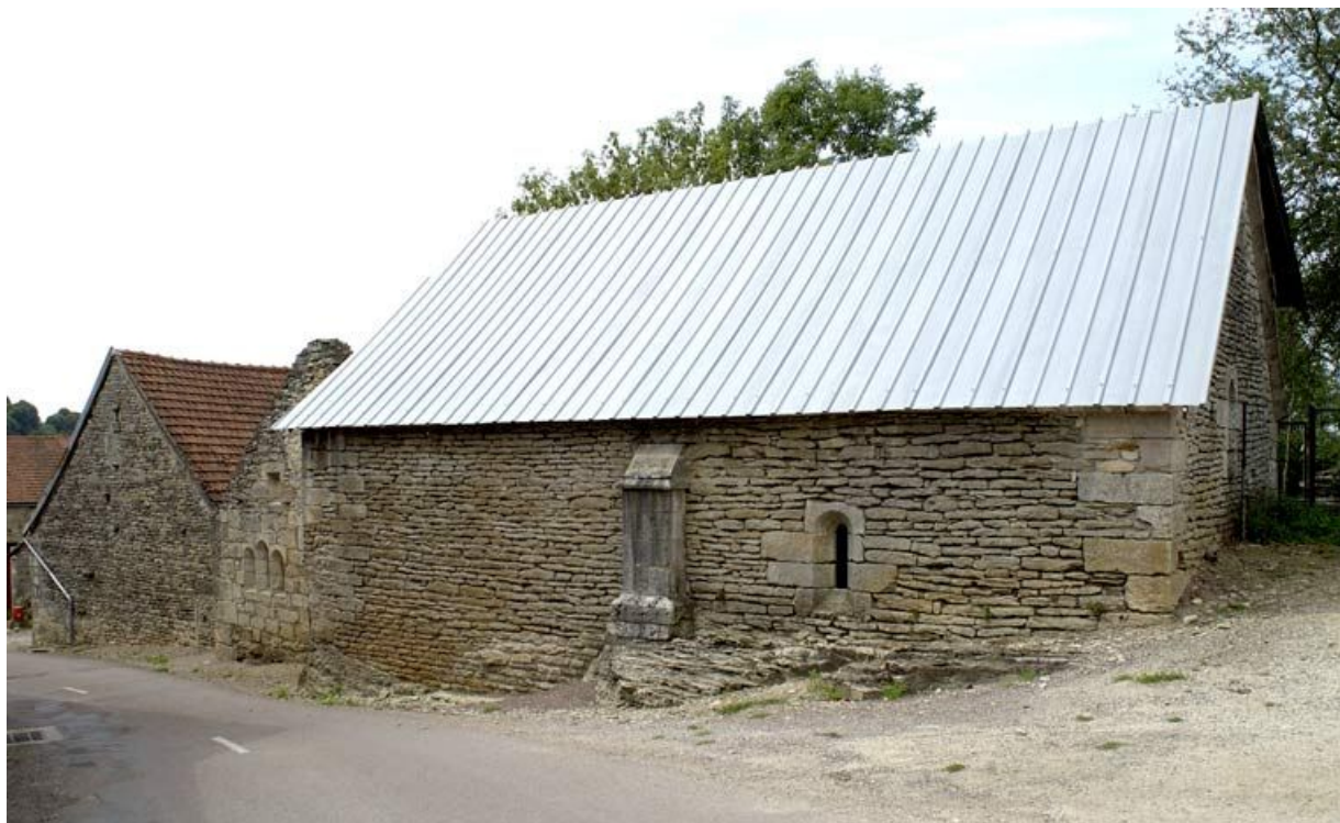
Vue d'ensemble depuis le nord-est en 2002.
