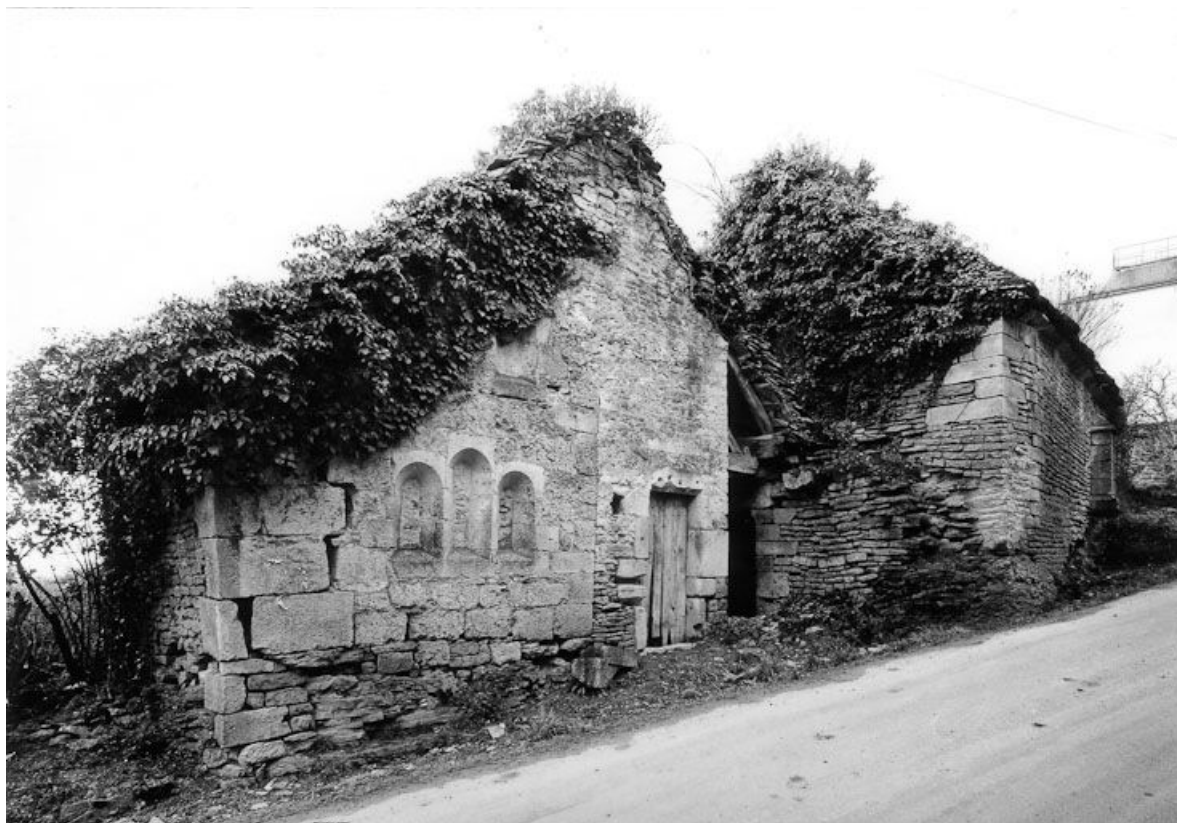
Vue d'ensemble depuis le bas de la rue en 1975.
