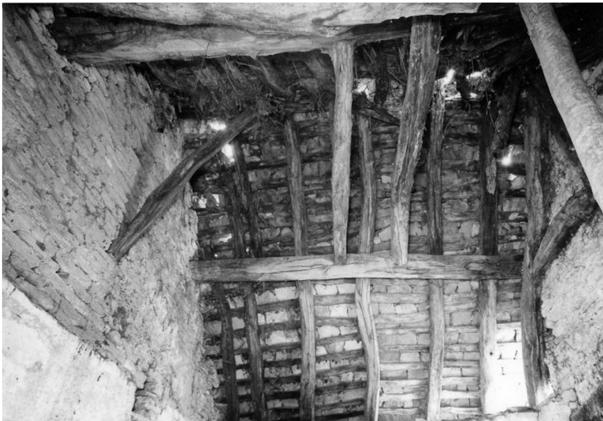
Charpente de la chapelle, versant nord, en 1975. 21, Mont-Saint-Jean Bergeries
