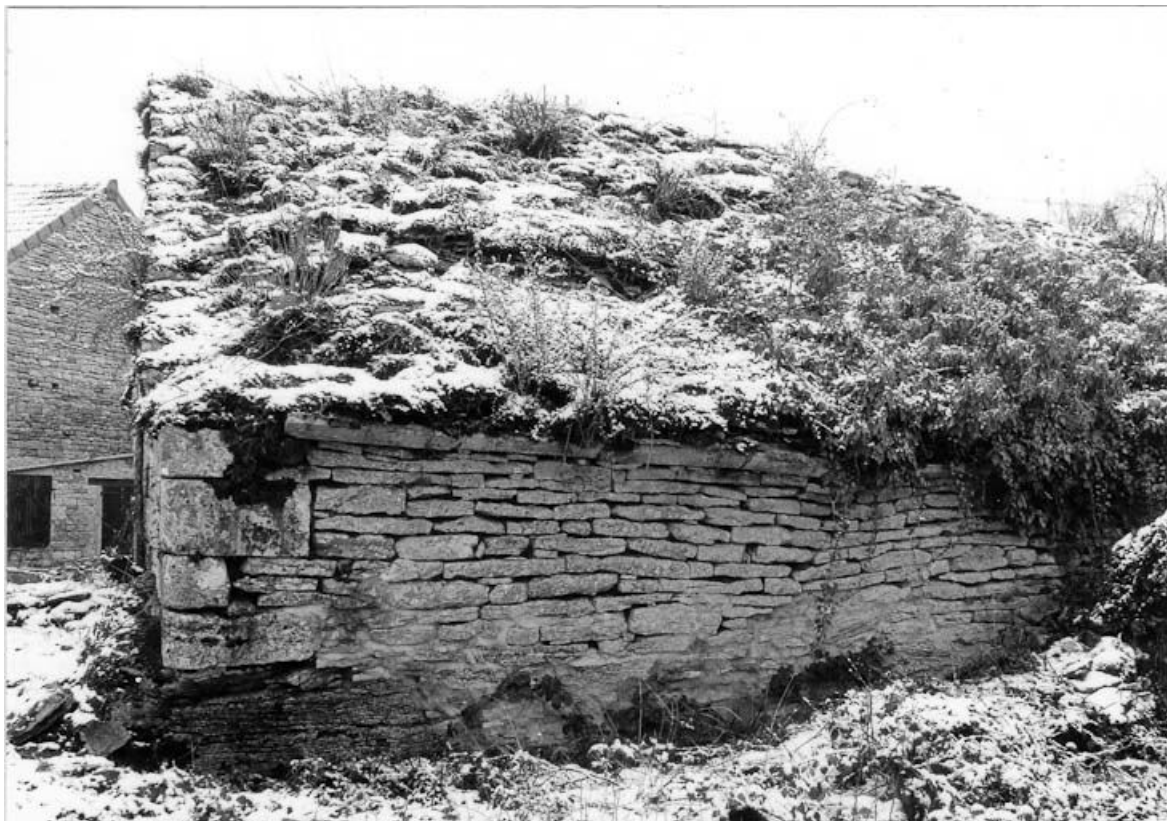
Salle voûtée, mur ouest, en 1975. 21, Mont-Saint-Jean Bergeries
