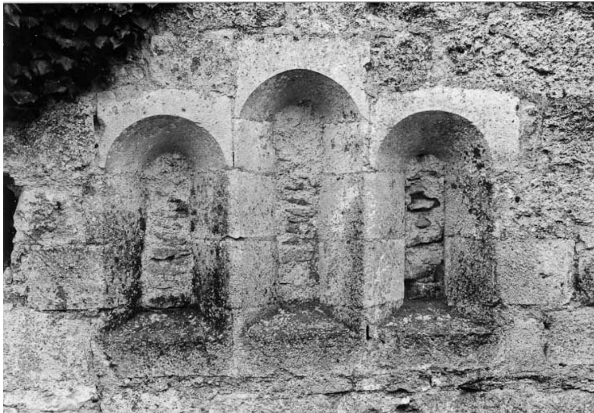
Chapelle, baies du mur est, en 1975. 21, Mont-Saint-Jean Bergeries
