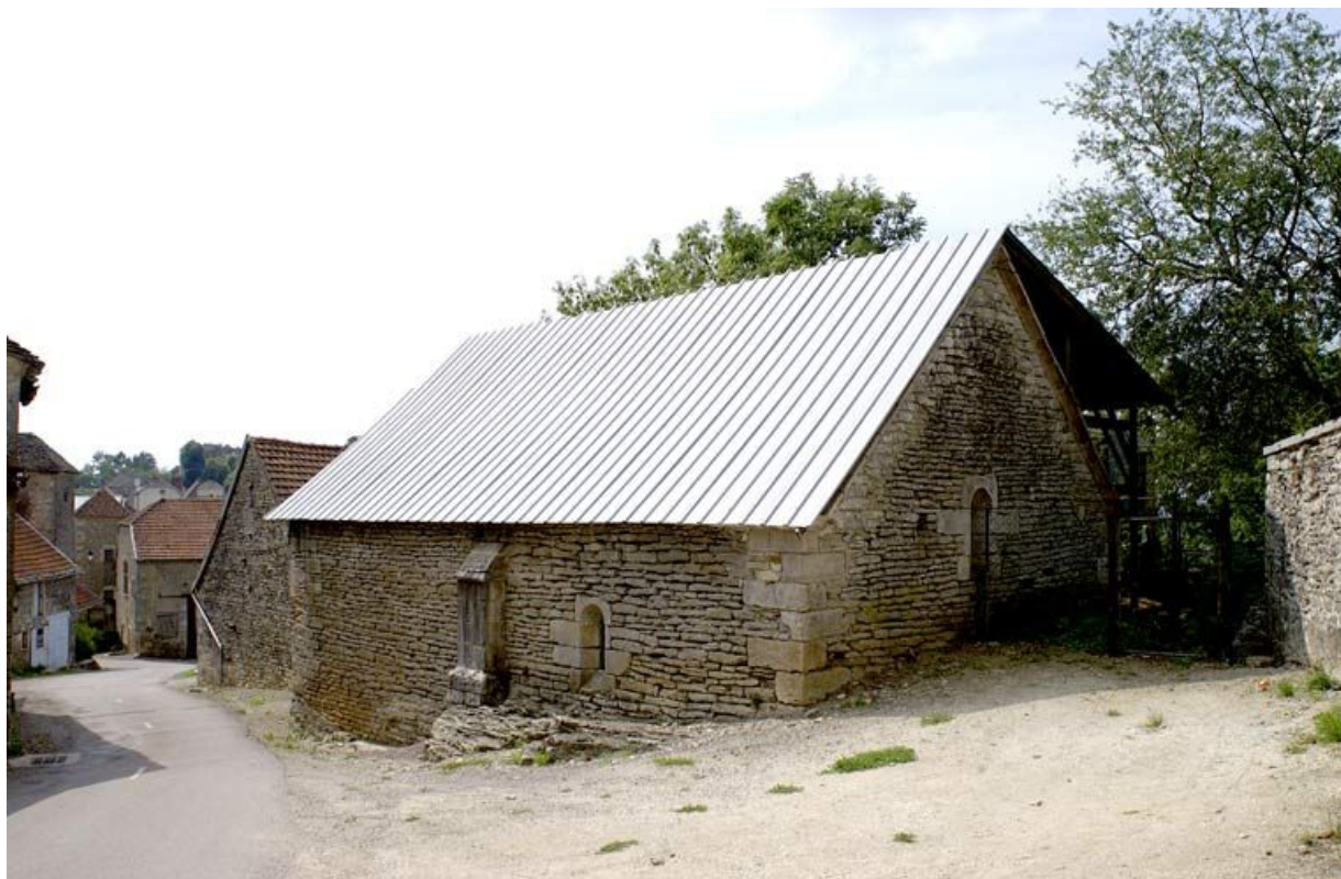
Salle voûtée, élévations est et nord en 2002. 21, Mont-Saint-Jean Bergeries
