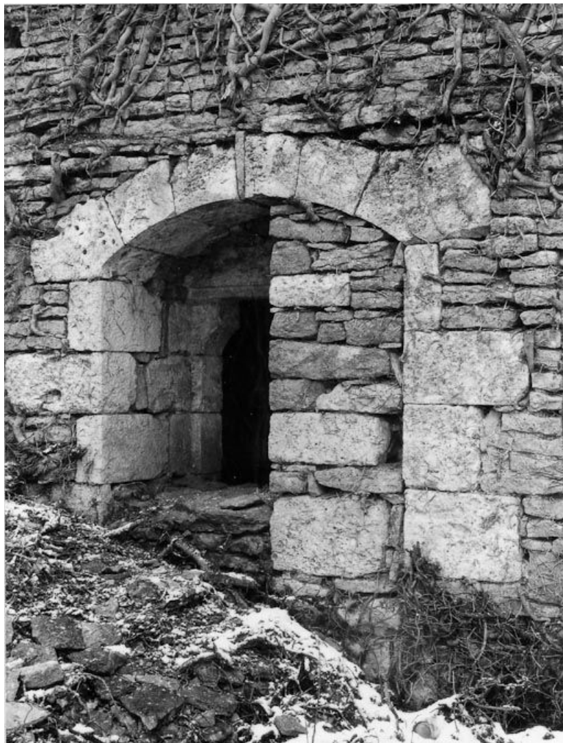
Chapelle, porte du mur ouest, en 1975. 21, Mont-Saint-Jean Bergeries
