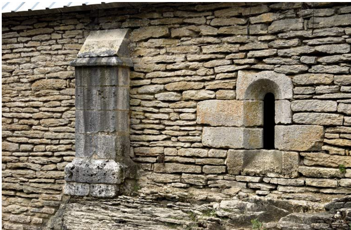
Salle voûtée, contrefort et baie de l'élévation est en 2002. 21, Mont-Saint-Jean Bergeries
