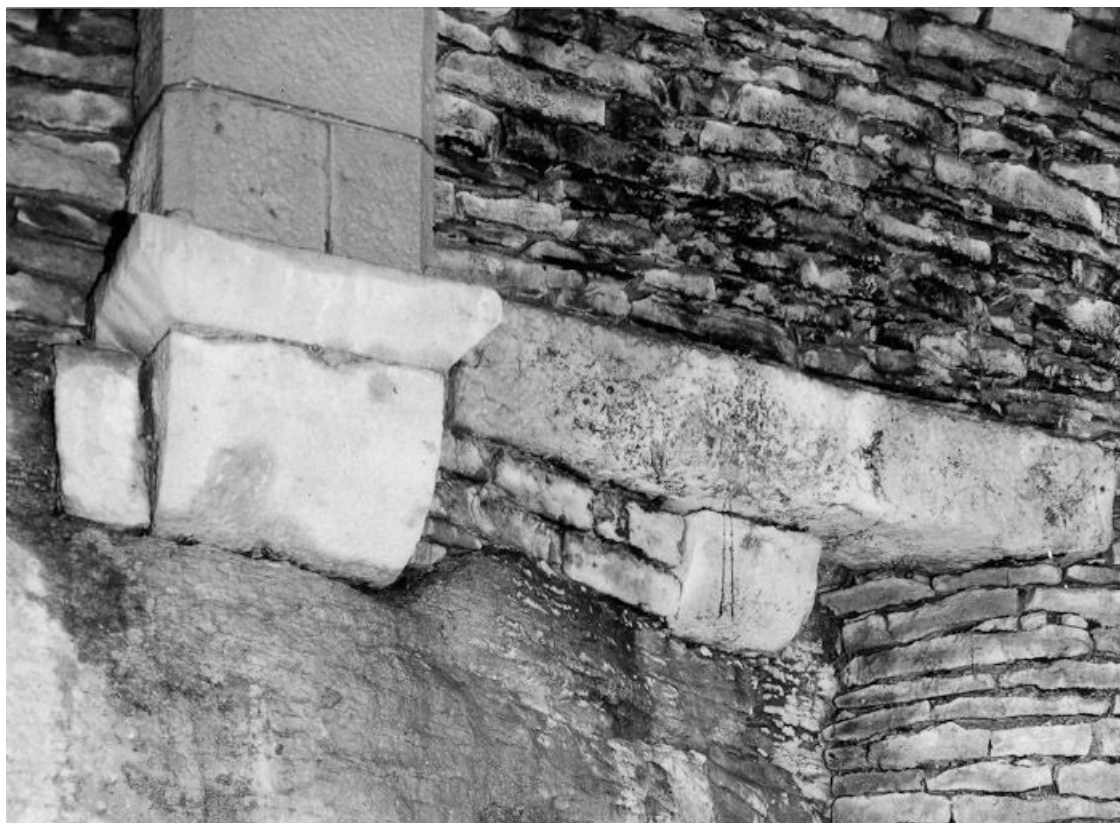
Salle voûtée, retombée de l'arc doubleau à l'ouest, en 1975. 21, Mont-Saint-Jean Bergeries
