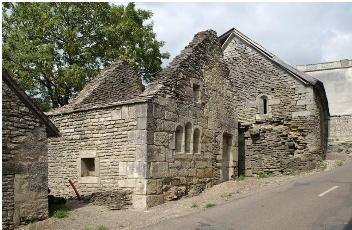
Vue d'ensemble depuis le sud-est en 2002.
