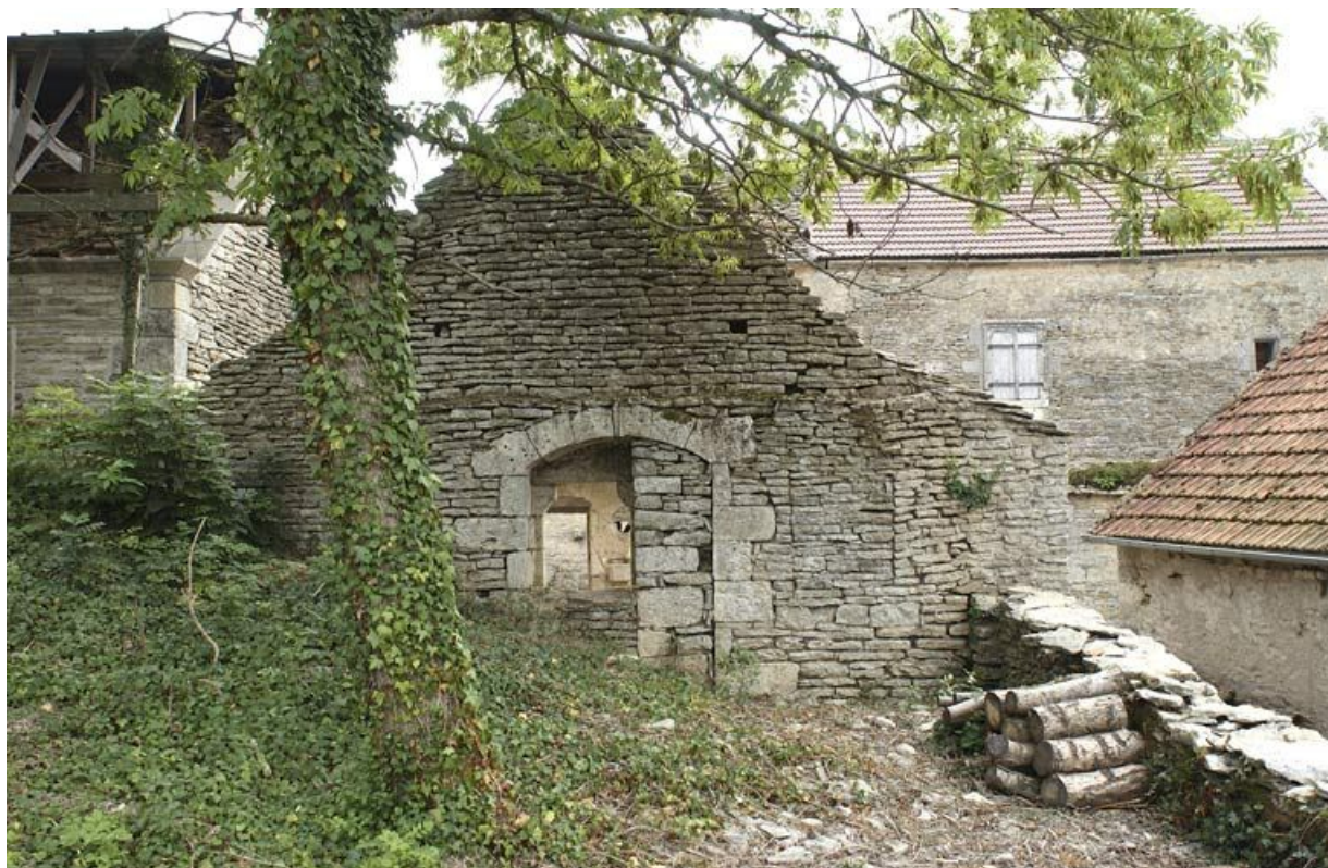
Chapelle, élévation ouest, en 2002.
