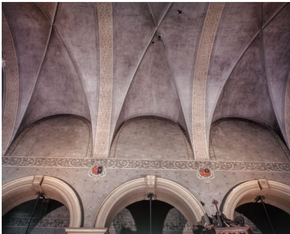
Nef, vaisseau central, détail des grandes arcades et de la voûte.
