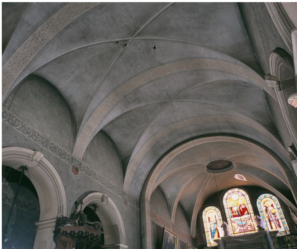
Voûtes du vaisseau central de la nef et du choeur.
