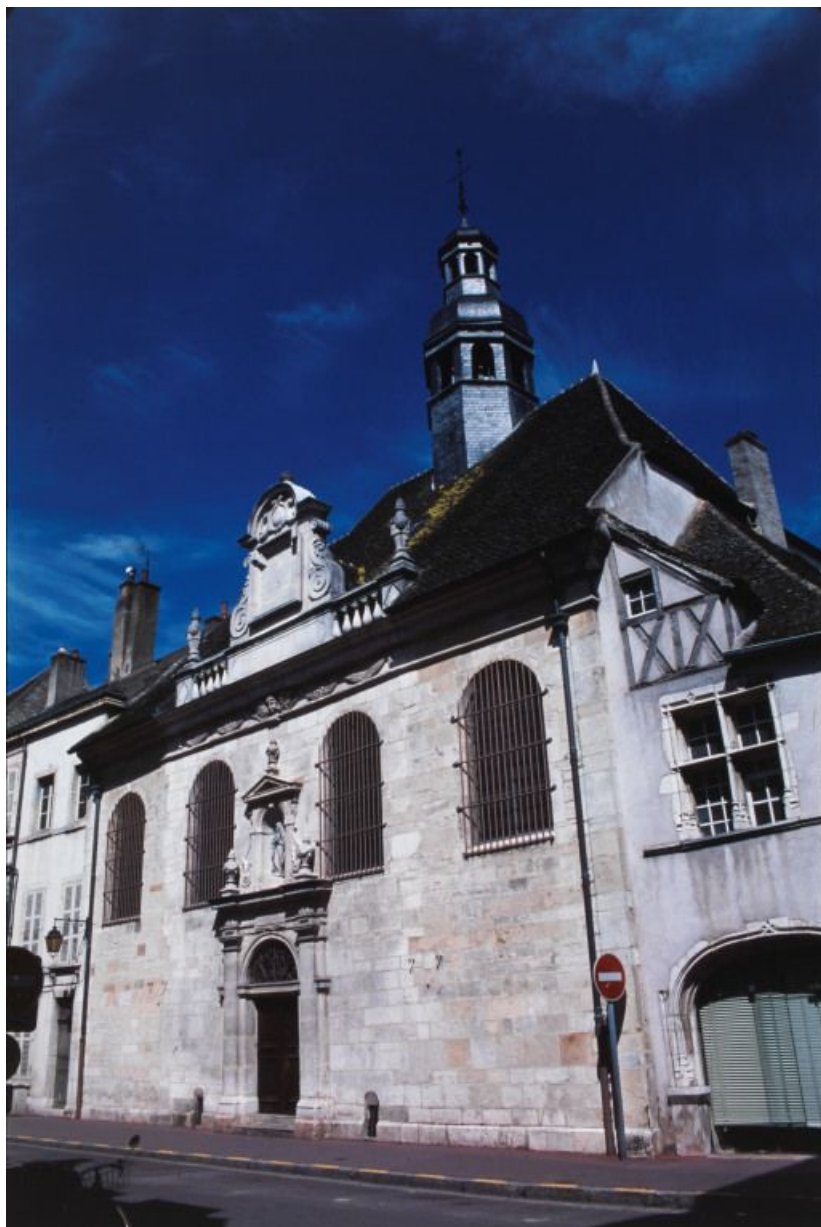
Vue d'ensemble depuis la rue de Lorraine. 21, Beaune Lorraine
