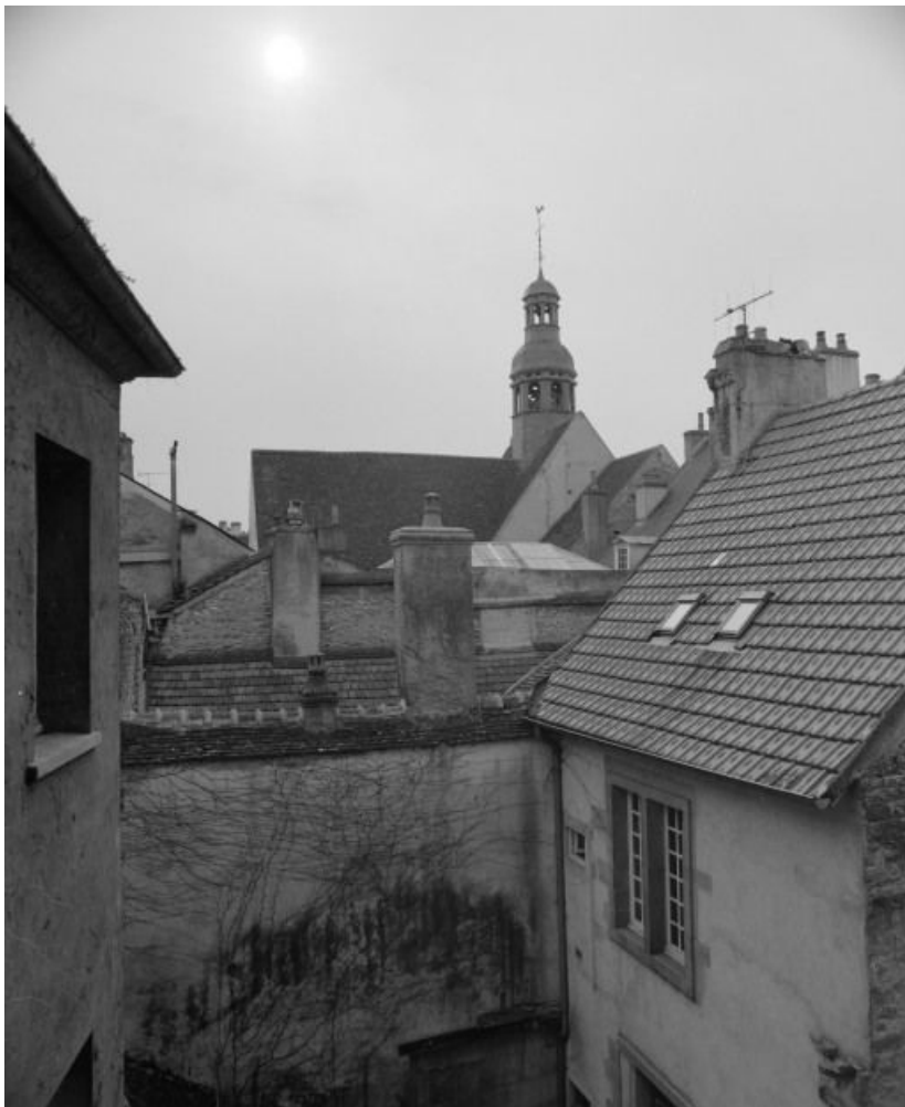
Côté nord des toitures.
