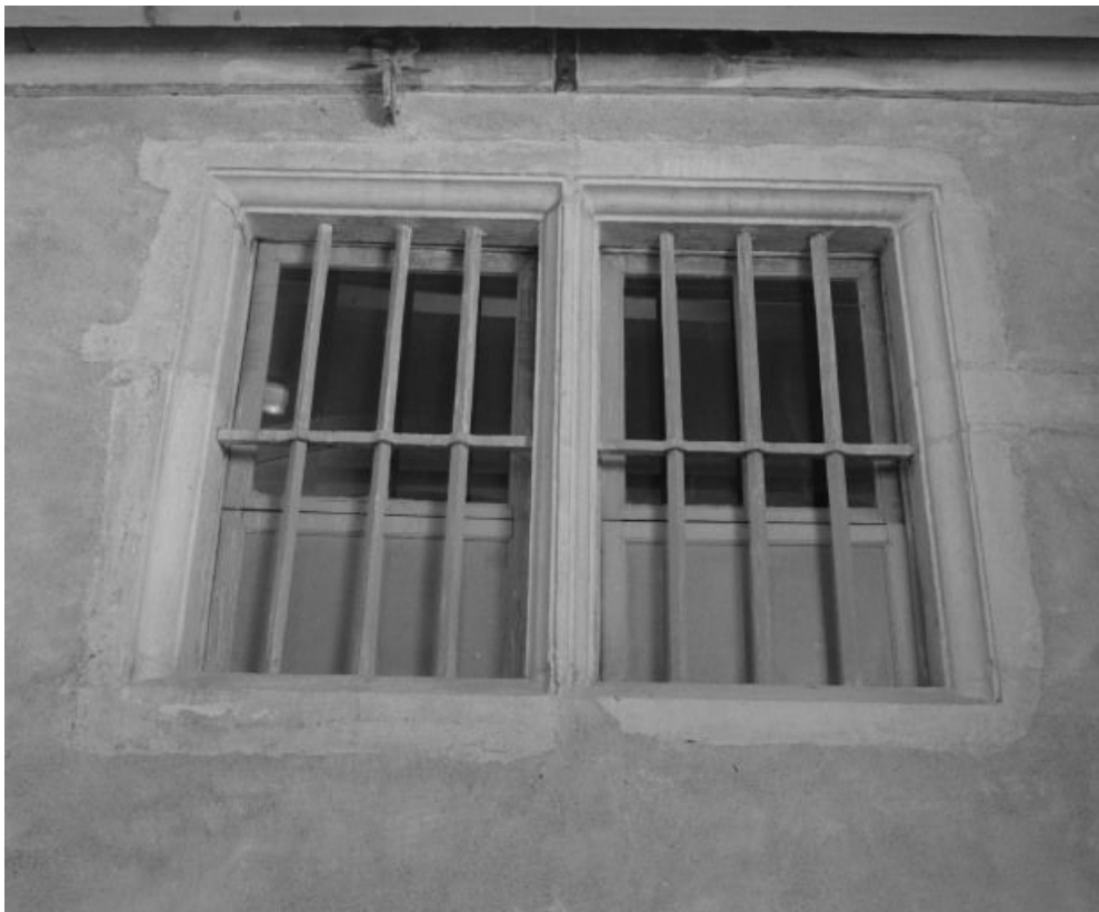
Fenêtre de la petite sacristie, vue prise côté cour.
