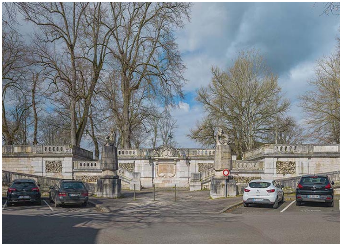
Vue d'ensemble, de face, depuis la place Marey.
