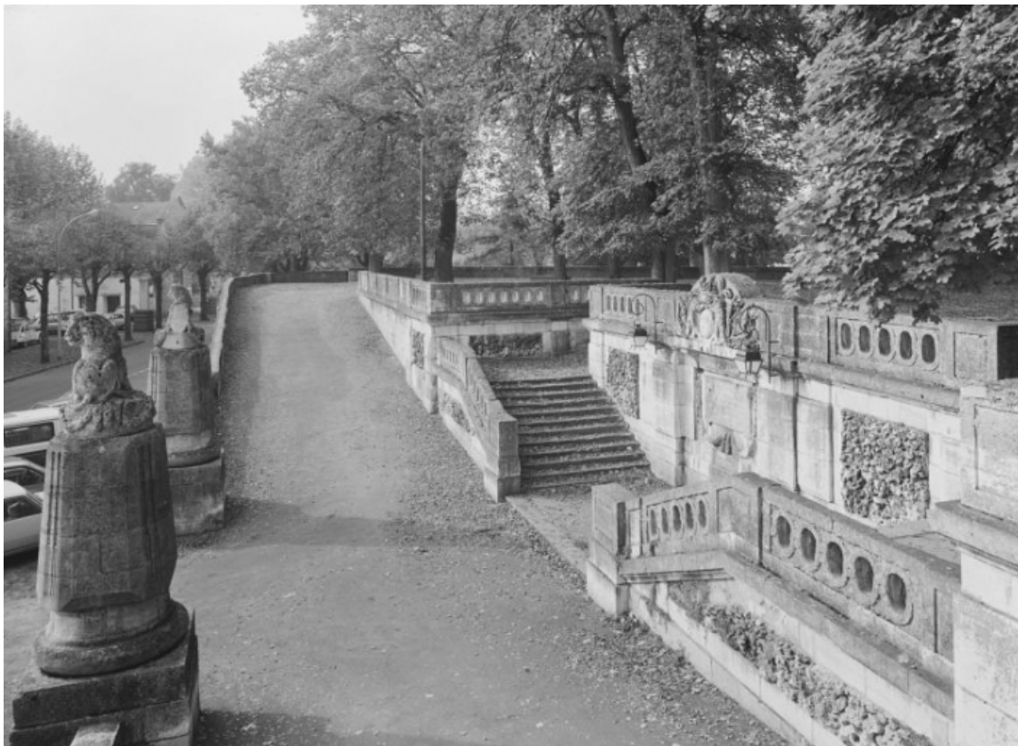
Vue d'ensemble, de côté, depuis la rampe d'accès (1988).
