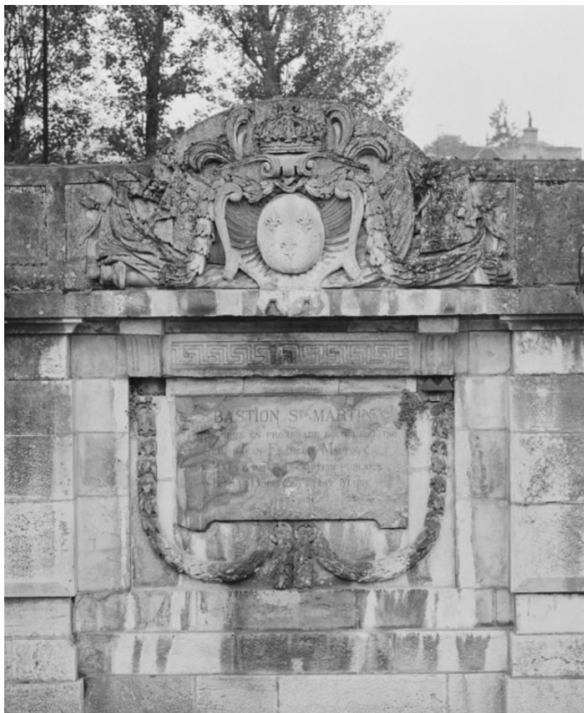
Vue de détail du décor de l'escalier, avec l'inscription commémorative de la restauration de 1891 (1988). 21, Beaune place Marey
