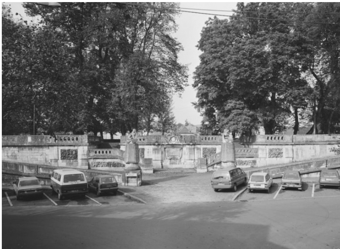
Vue d'ensemble, de face, depuis la place Marey (1988).
