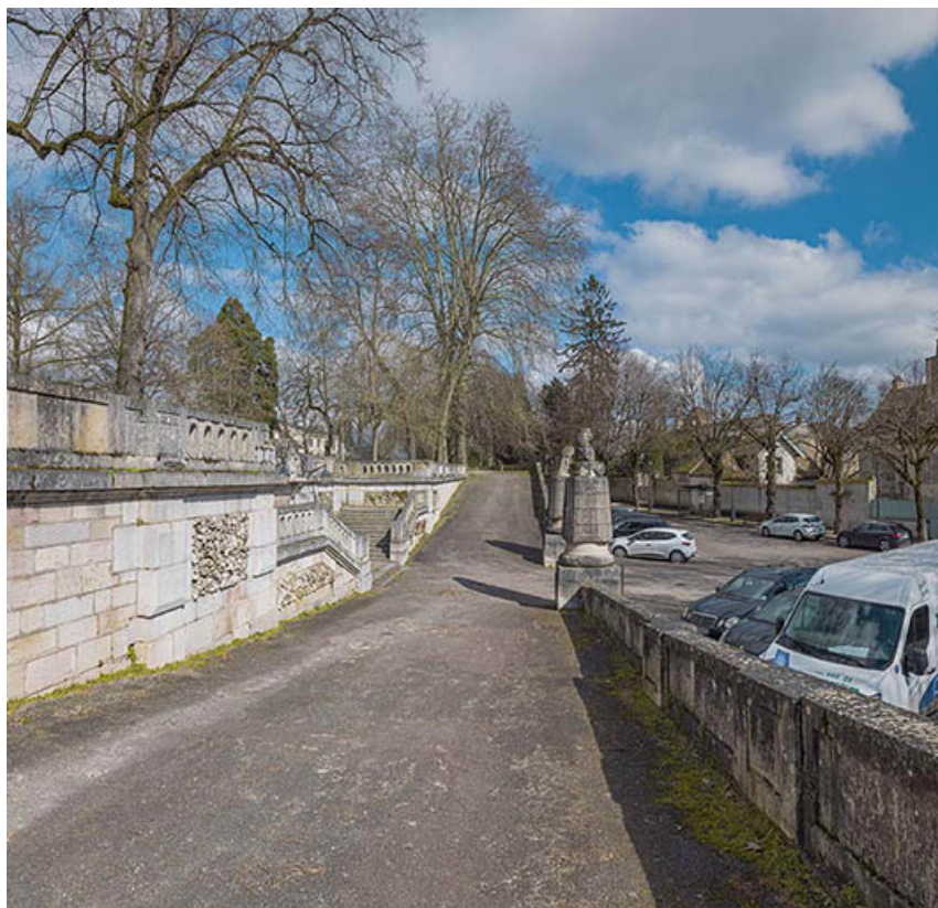
Vue d'une rampe d'accès.
