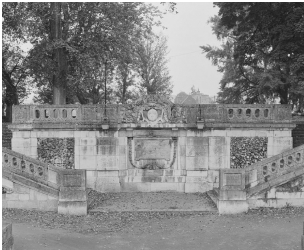
Vue de détail de l'escalier, de face (1988).
