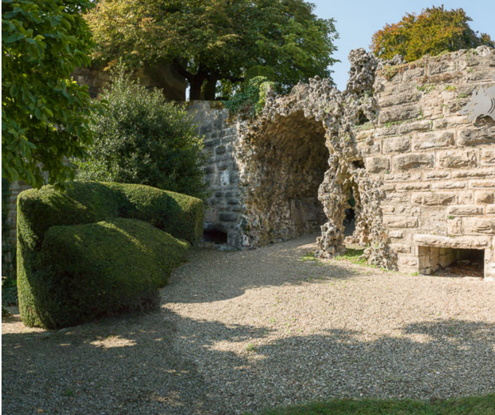
Passage aménagé dans l'ancienne courtine.
