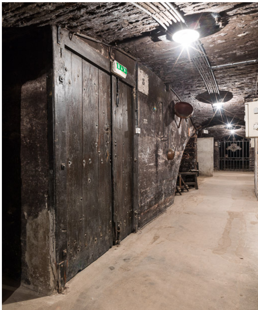
Porte d'accès vers les anciens chais.
