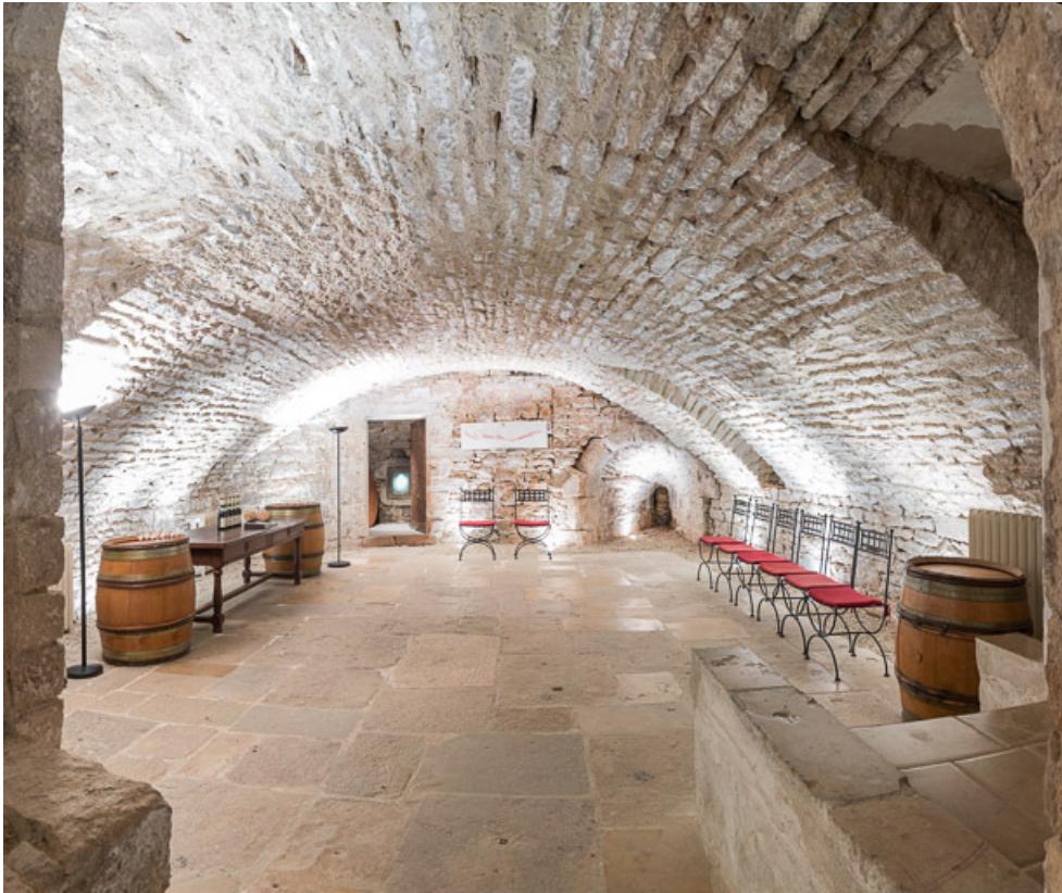
Caveau de dégustation aménagé dans la casemate supérieure de la tour sud-ouest. 21, Beaune rue du Château
