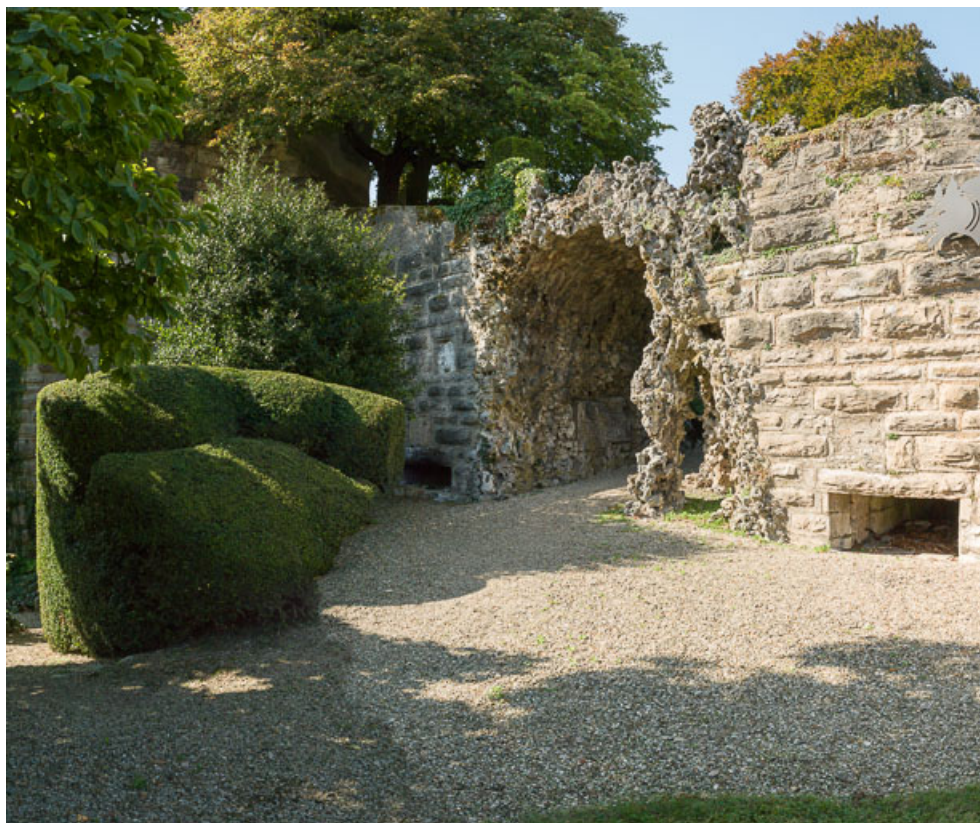
Passage aménagé dans l'ancienne courtine.
