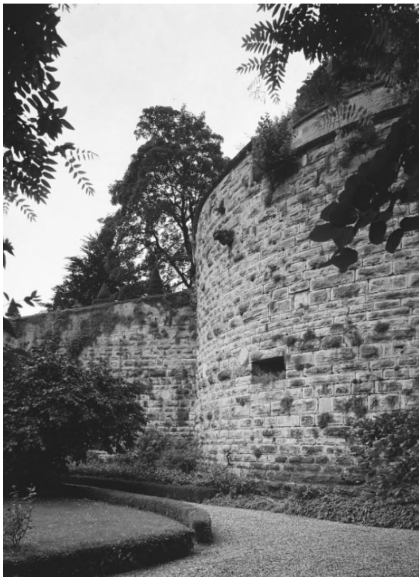
Courtine sud et tour sud-est depuis le fossé (1988).
