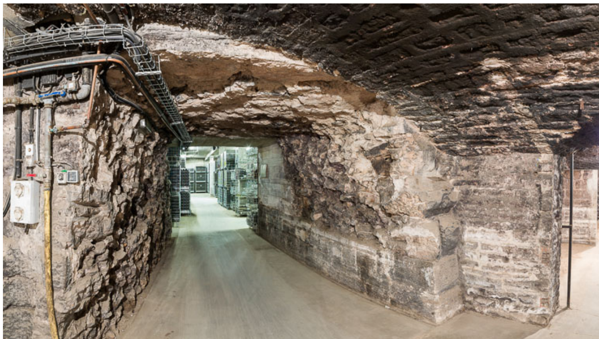
Caves sous la tour nord-est : le passage creusé dans l'ancien rempart.
