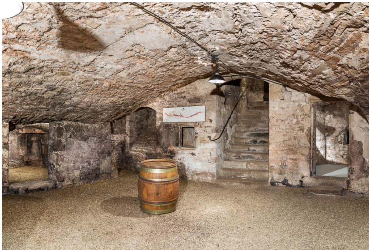
Casemate inférieure de la tour sud-ouest.
