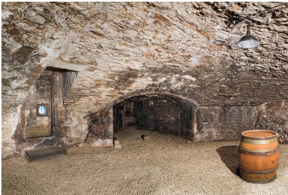
Casemate inférieure de la tour sud-ouest.
