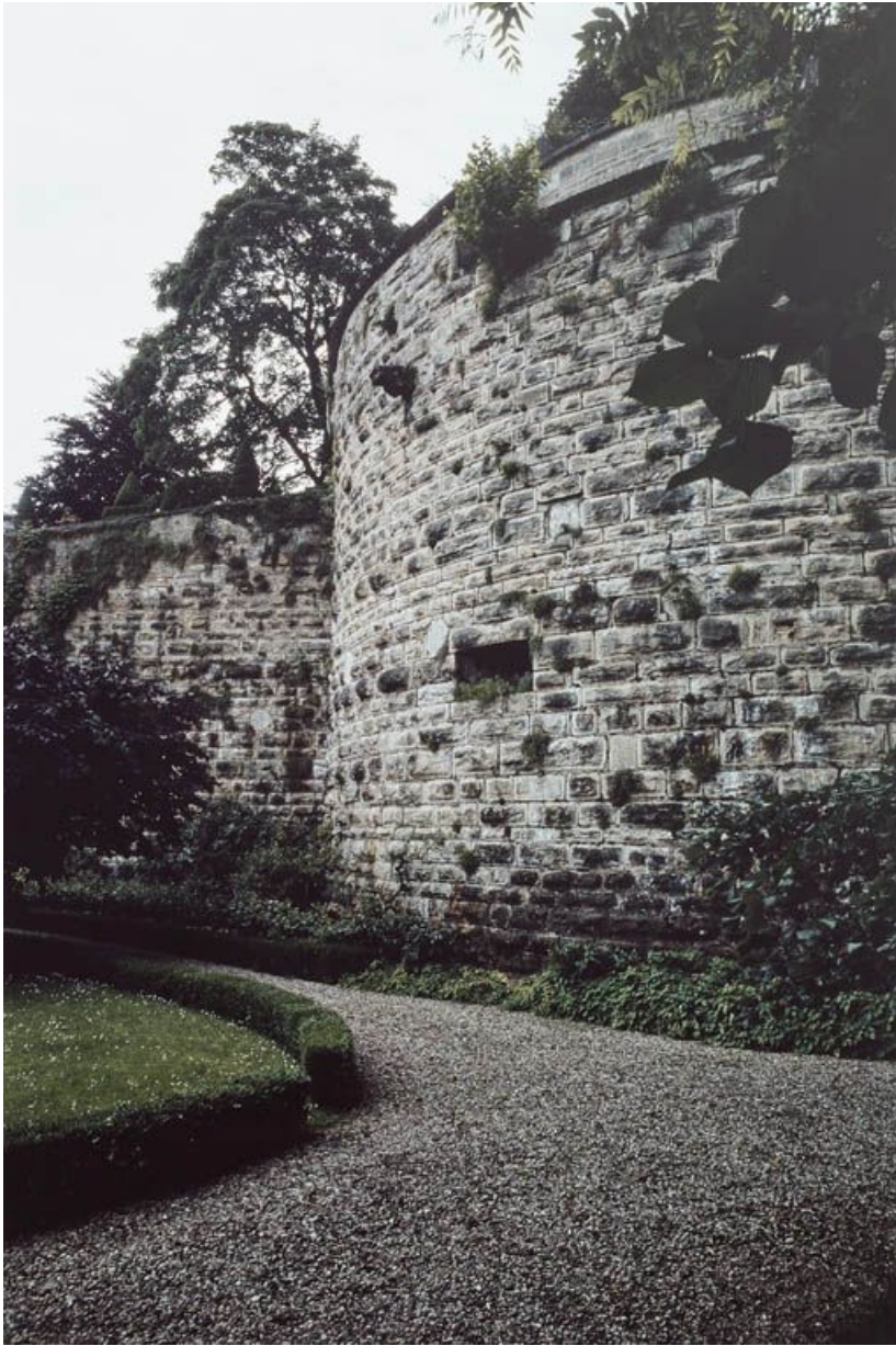
Courtine sud et tour sud-est depuis le fossé.
