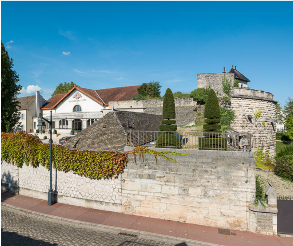
vestiges des remparts et rue du Château.
