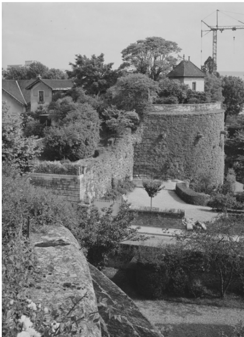
Tour nord-est et courtine est : vue d'ensemble prise depuis la plateforme de la tour sud-est (1988). 21, Beaune rue du Château
