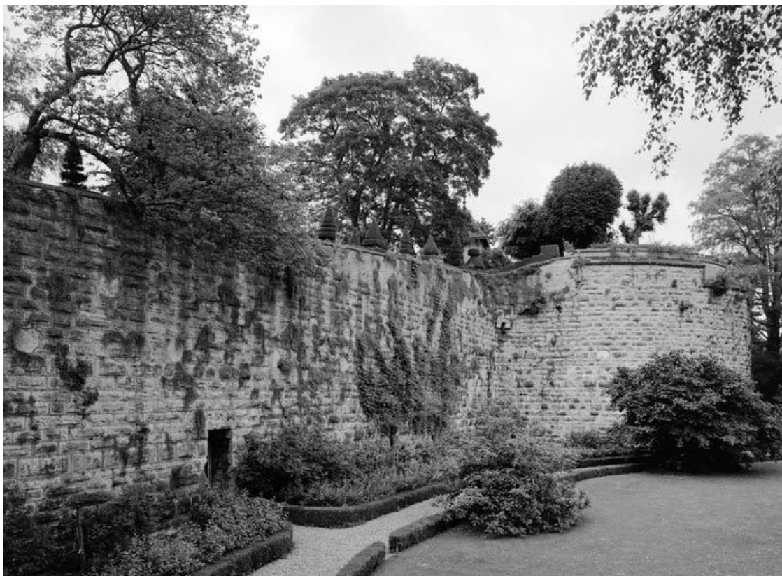
Escarpe de la courtine sud : vue d'ensemble prise du sud-ouest.
