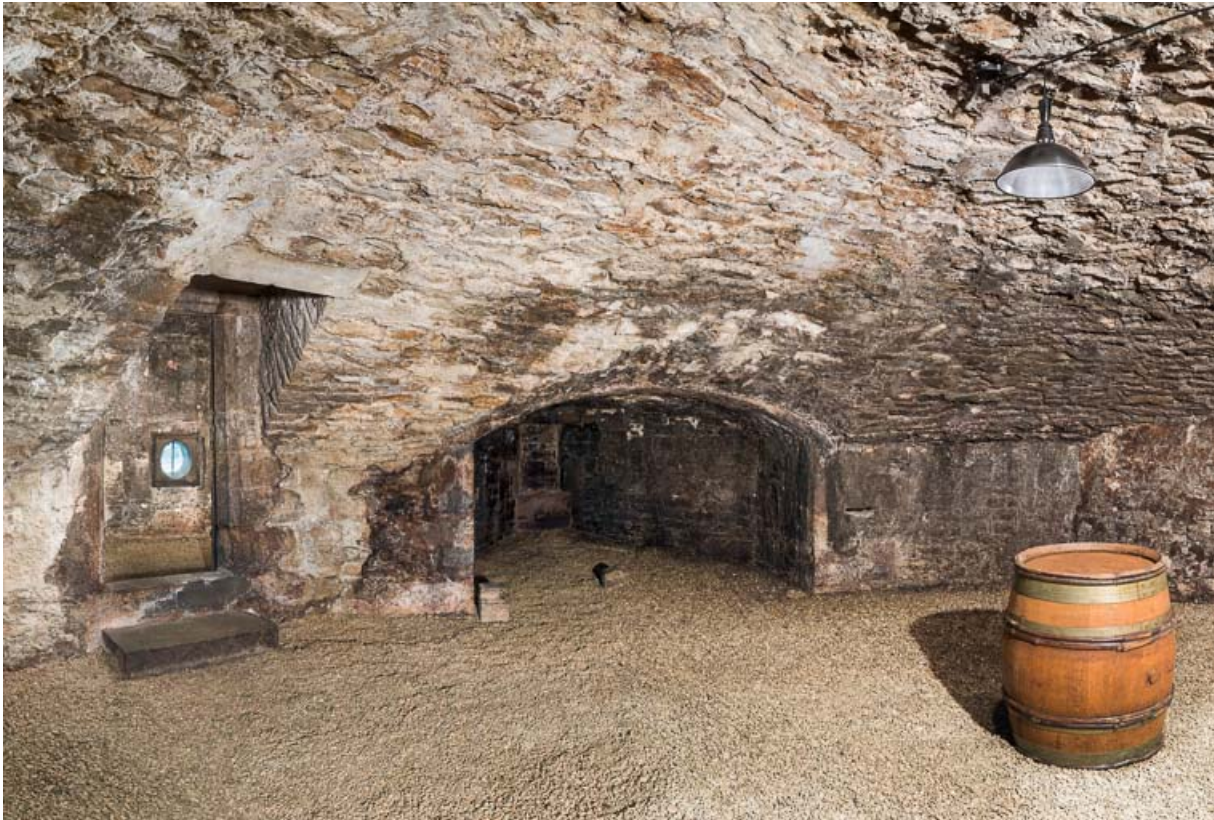
Casemate inférieure de la tour sud-ouest.
