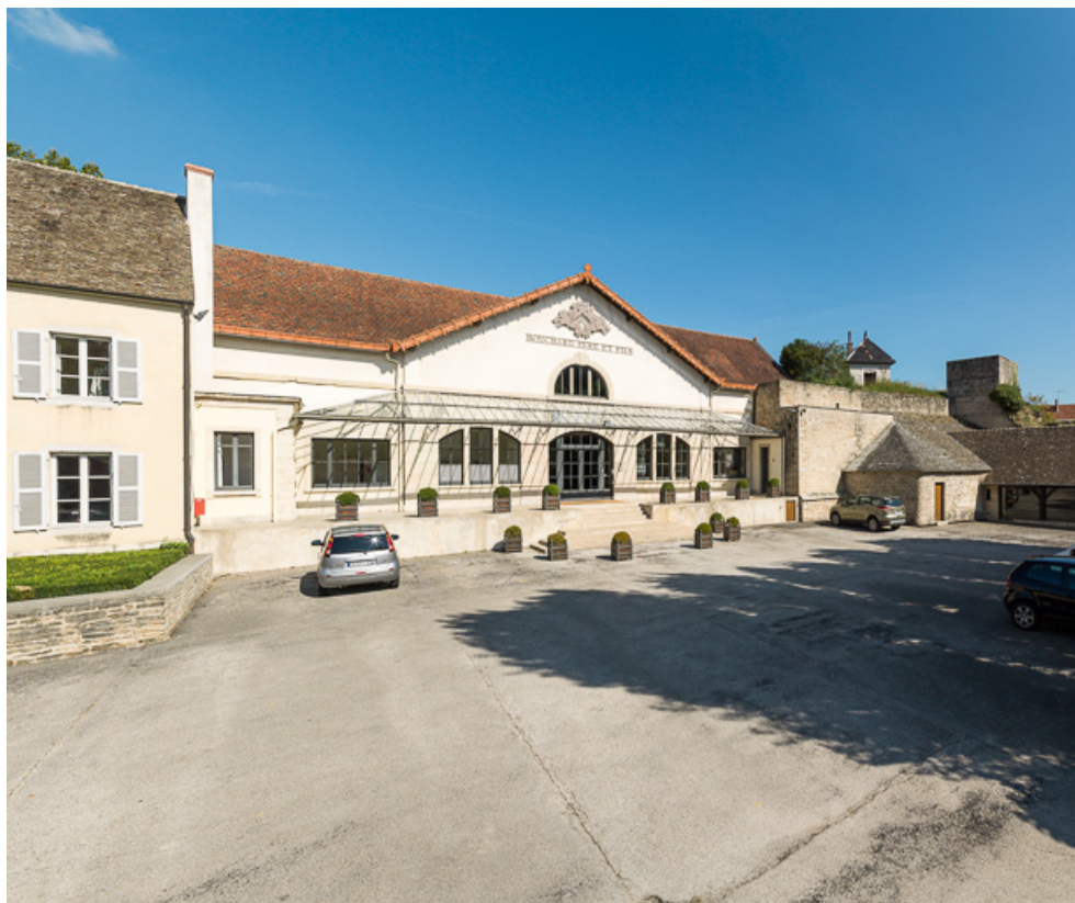
Façade antérieure des anciens chais, aujourd'hui bureaux, installés sur l'ancienne esplanade du château. 21, Beaune rue du Château
