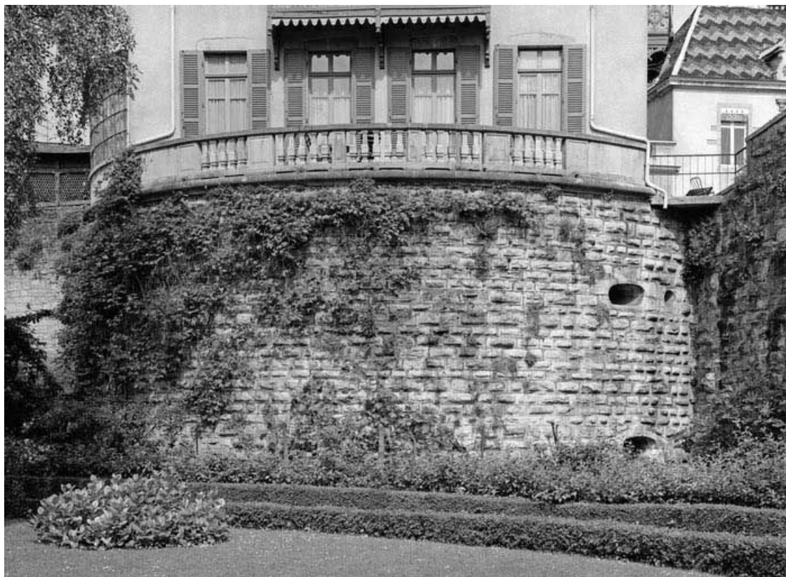
Tour sud-ouest depuis le fossé.
