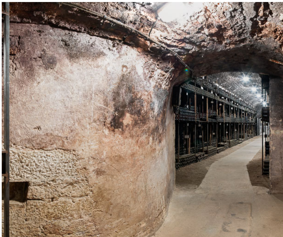
Cave de vieillissement, le long de l'ancien rempart (1er sous-sol) : au premier plan, fondations de la tour nord-ouest.. 21, Beaune rue du Château
