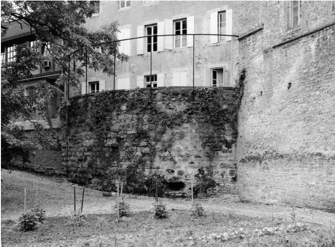
Vestiges de la tour nord-ouest depuis le fossé.
