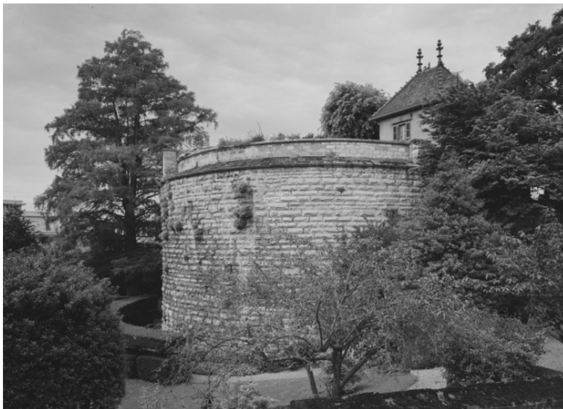
Tour sud-est depuis la rue du Château (1988).
