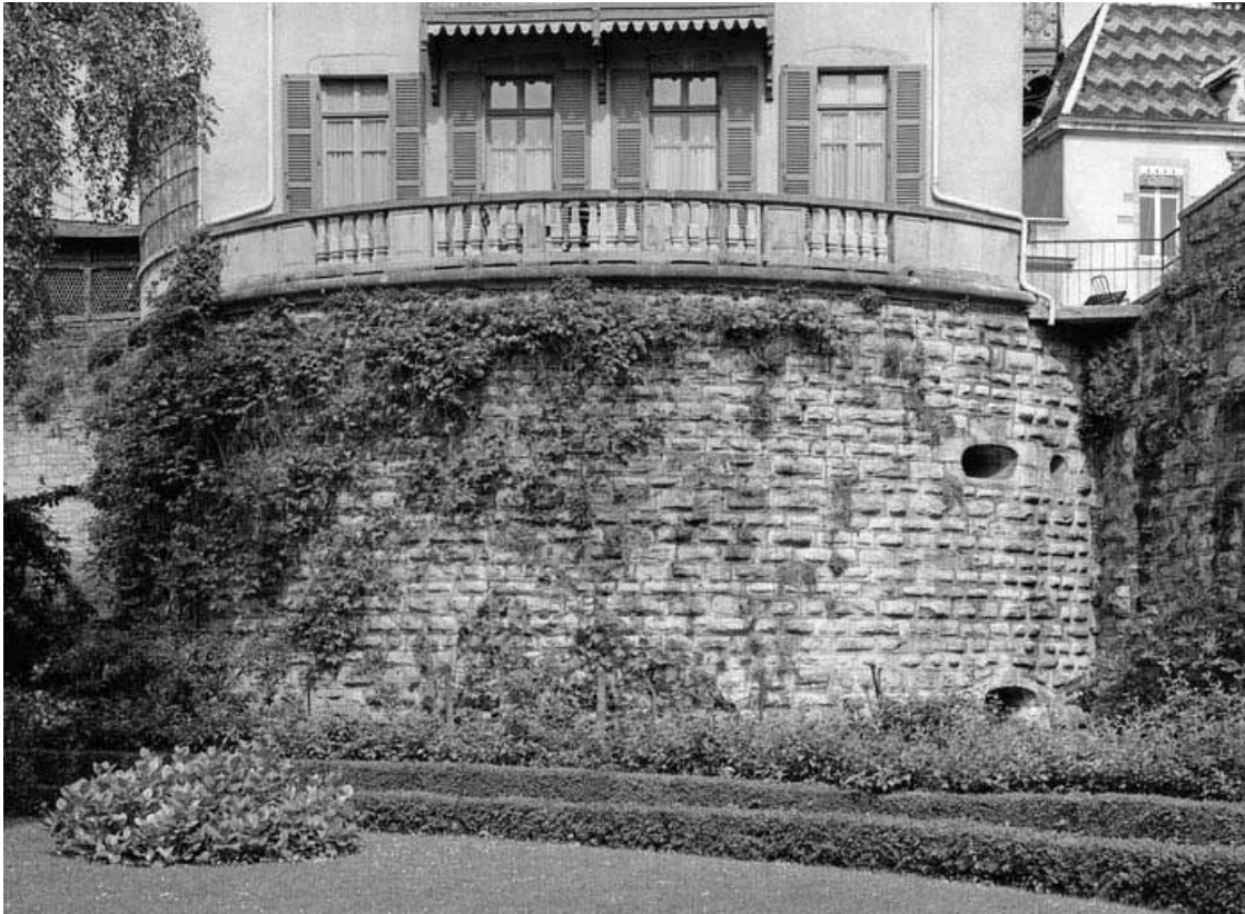
Tour sud-ouest depuis le fossé.
