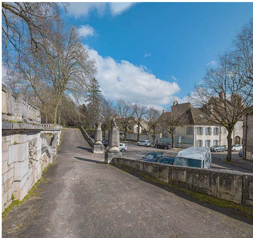
Vue d'ensemble, depuis la rampe d'accès (square des Lions). 21, Beaune
