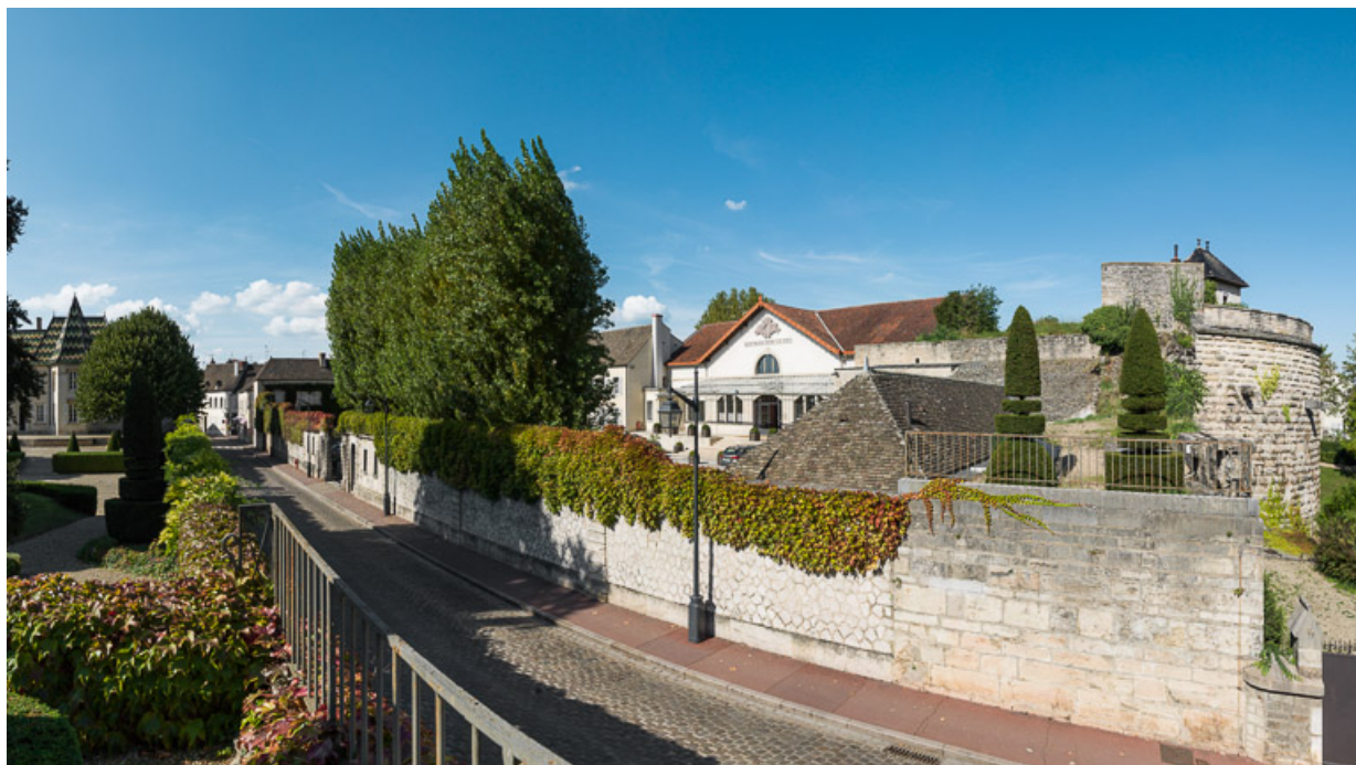
Rue du Château depuis le belvédère.
