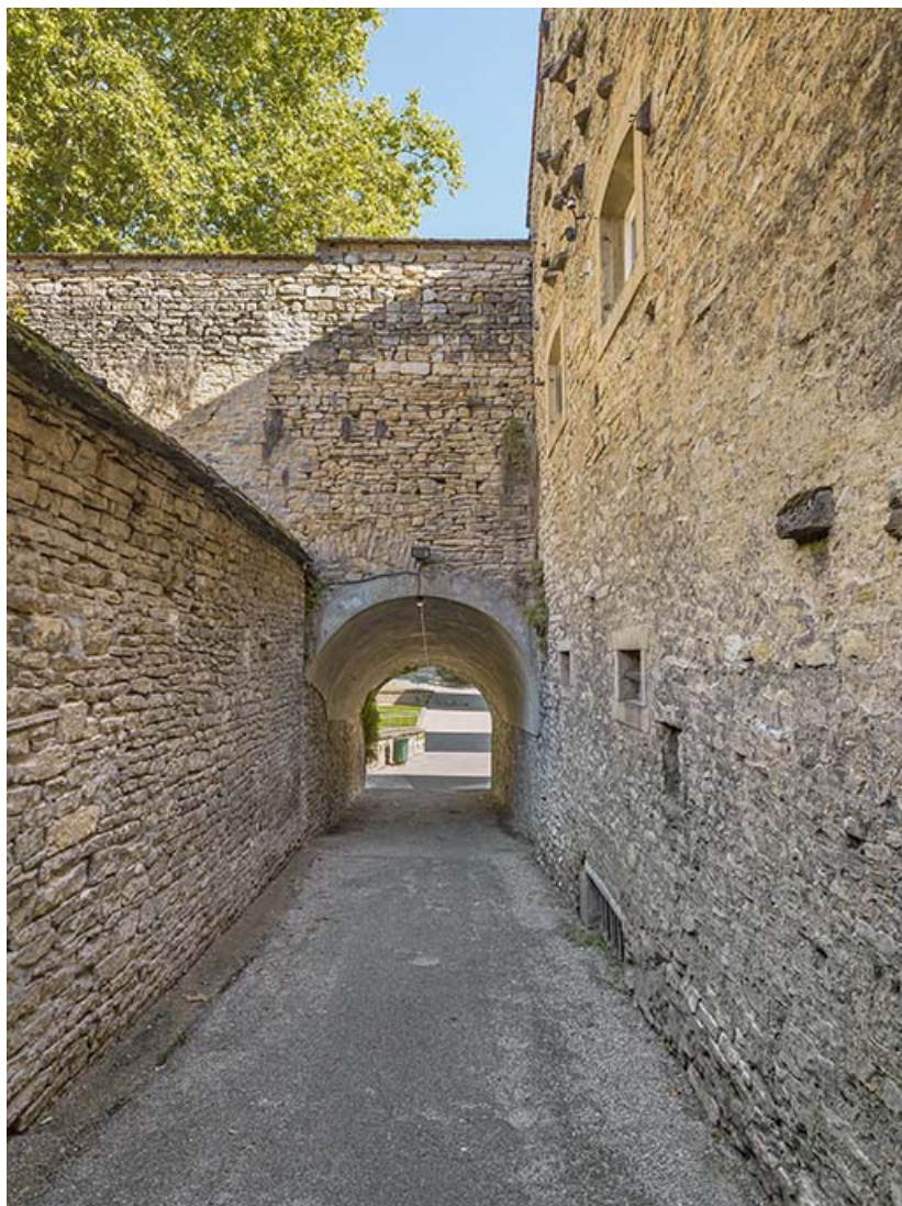
Passage voûté au rempart de la Comédie : côté ville. 21, Beaune
