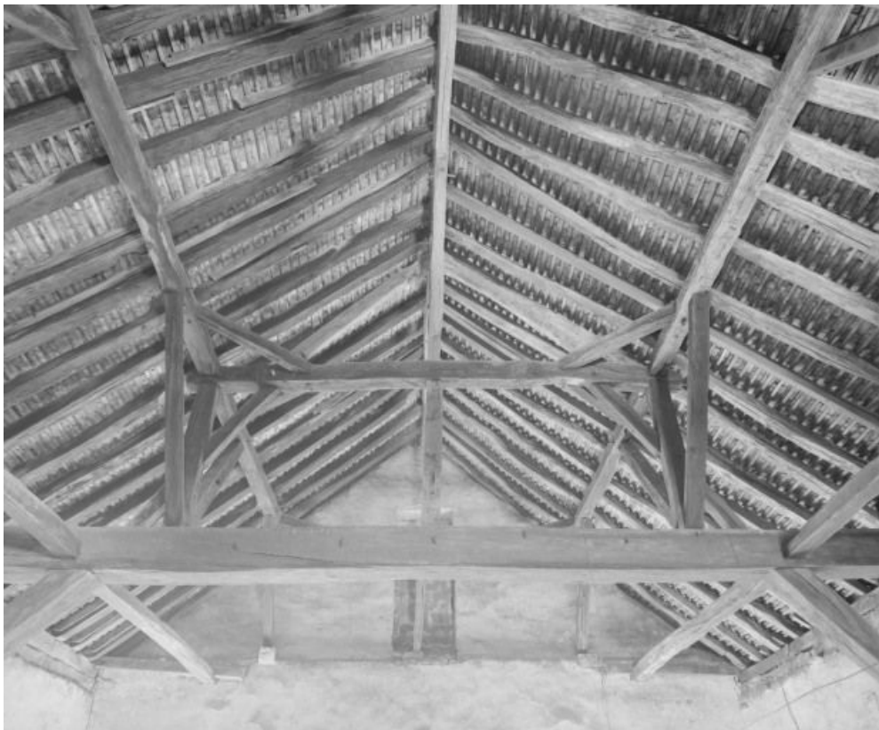
Niveau supérieur : vue de la charpente.
