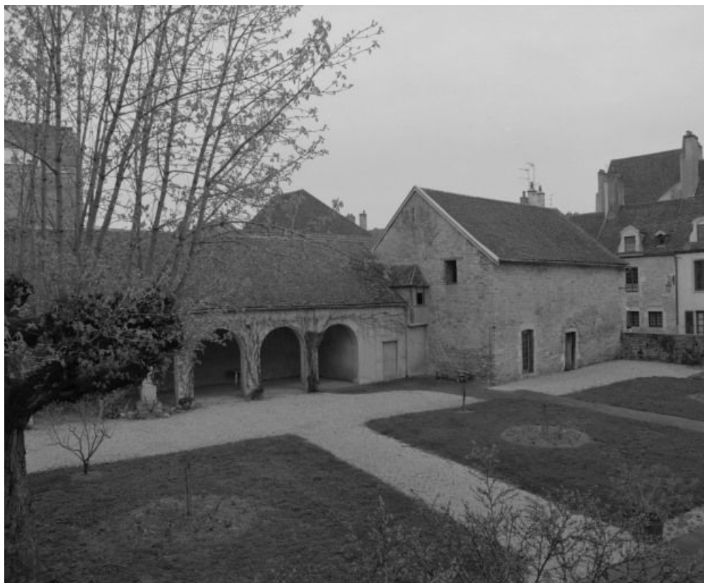
Vue d'ensemble, de trois-quarts, depuis la cour.
