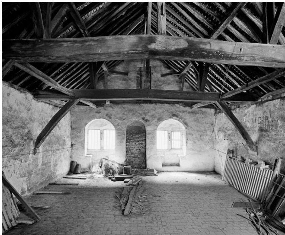
Niveau supérieur : vue d'ensemble prise depuis le pignon sur cour.
