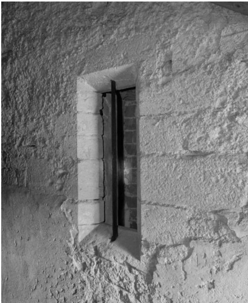
Niveau supérieur : fenêtre à droite de la porte du pignon sur cour. 21, Beaune, 3 rue Rousseau Deslandes
