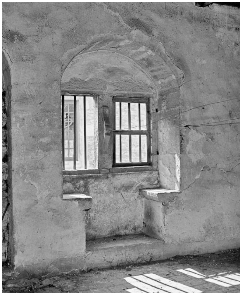
Niveau supérieur : embrasure à coussièges des fenêtres du pignon sur rue. 21, Beaune, 3 rue Rousseau Deslandes
