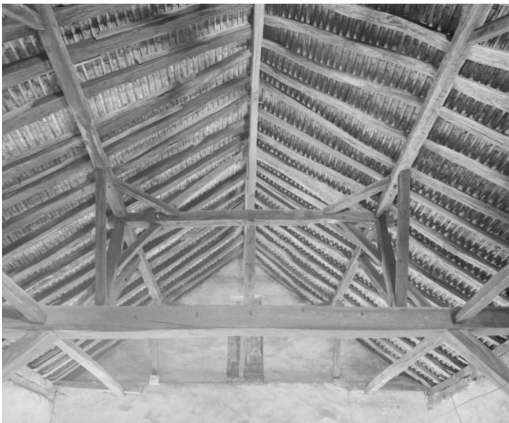
Niveau supérieur : vue de la charpente.
