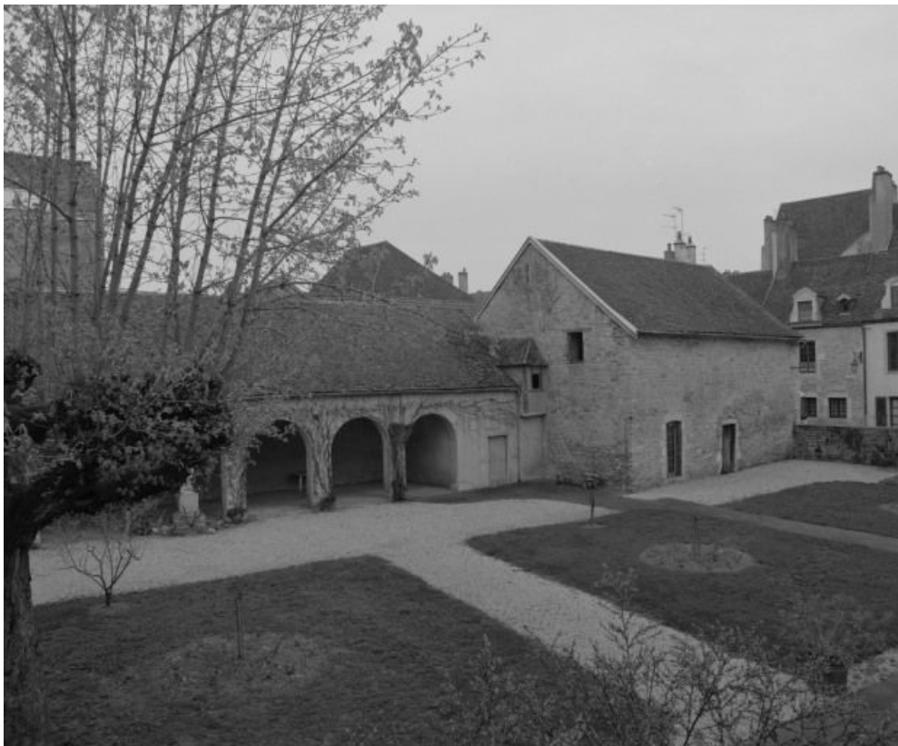
Vue d'ensemble, de trois-quarts, depuis la cour.
