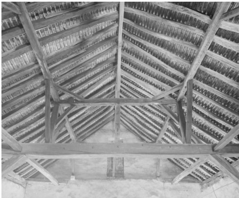
Niveau supérieur : vue de la charpente.
