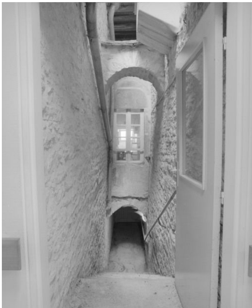
Vue de la venelle, prise de l'étage.
