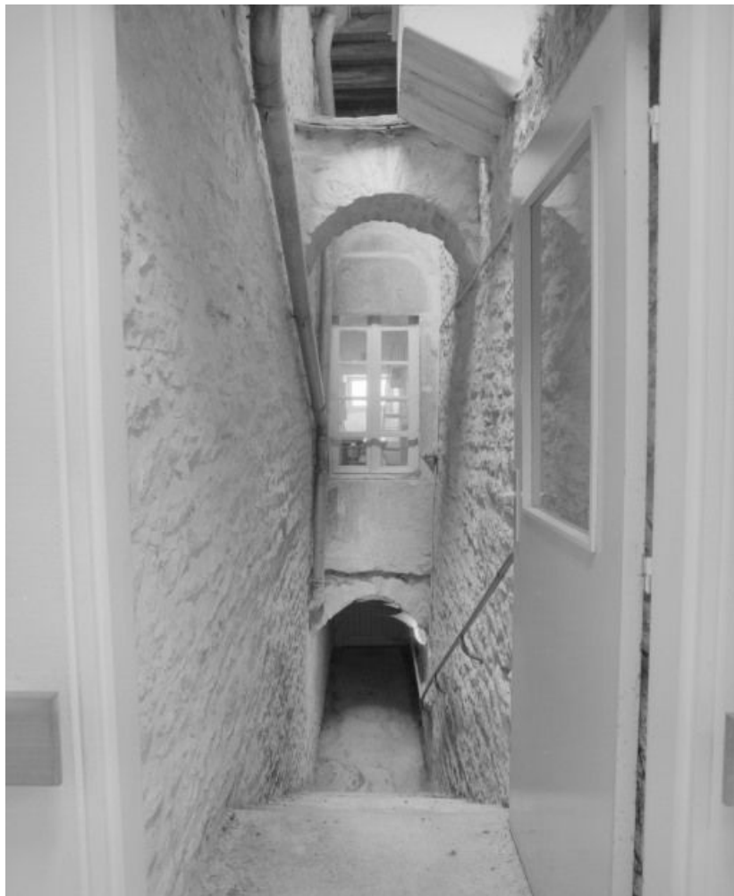
Vue de la venelle, prise de l'étage.
