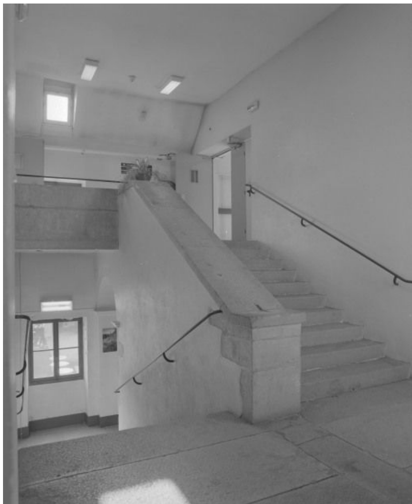
Escalier : vue prise du 2e étage.
