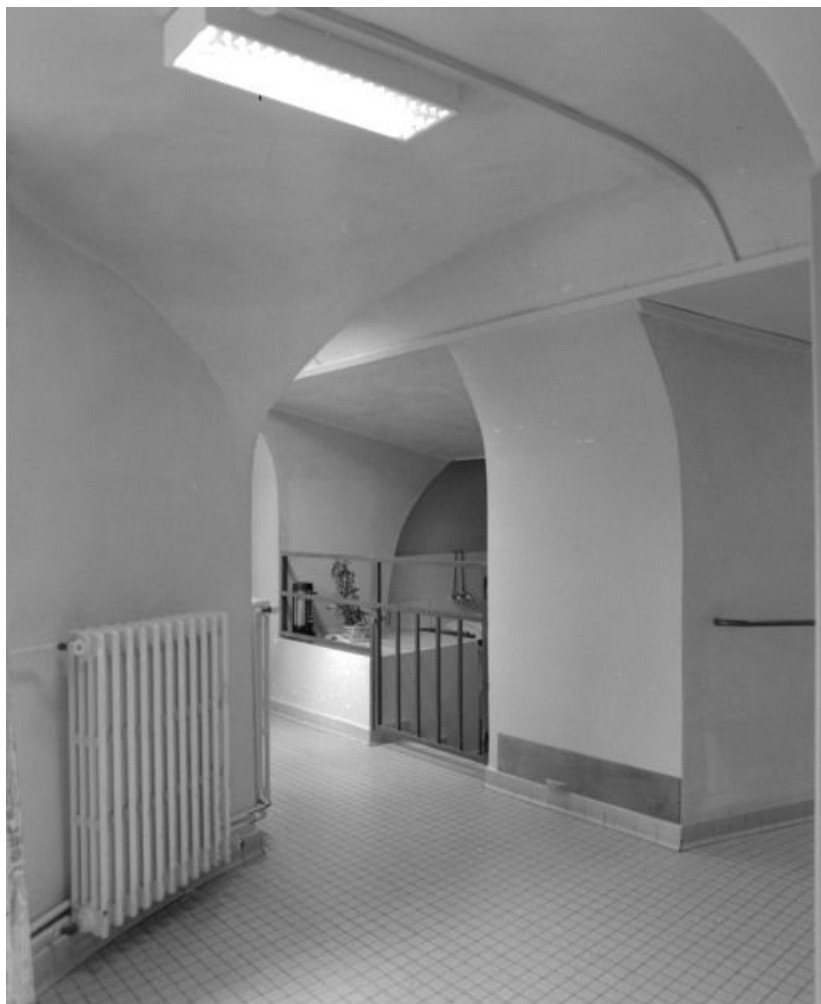
Sous-sol : couloir et cuisine actuelle.
