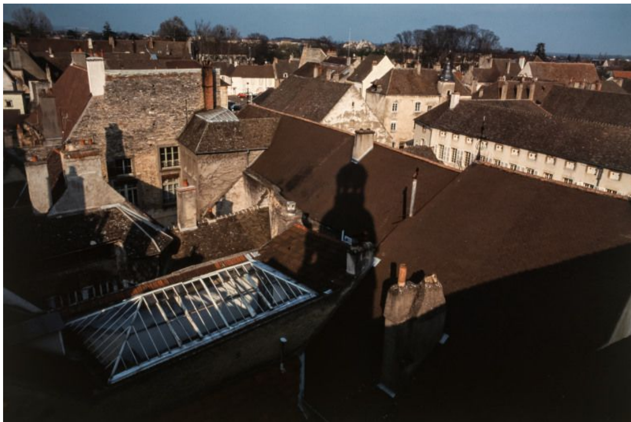
Toitures des différents corps composant le bâtiment de la Communauté des soeurs et des orphelins, vue prise du clocher de l'église.
