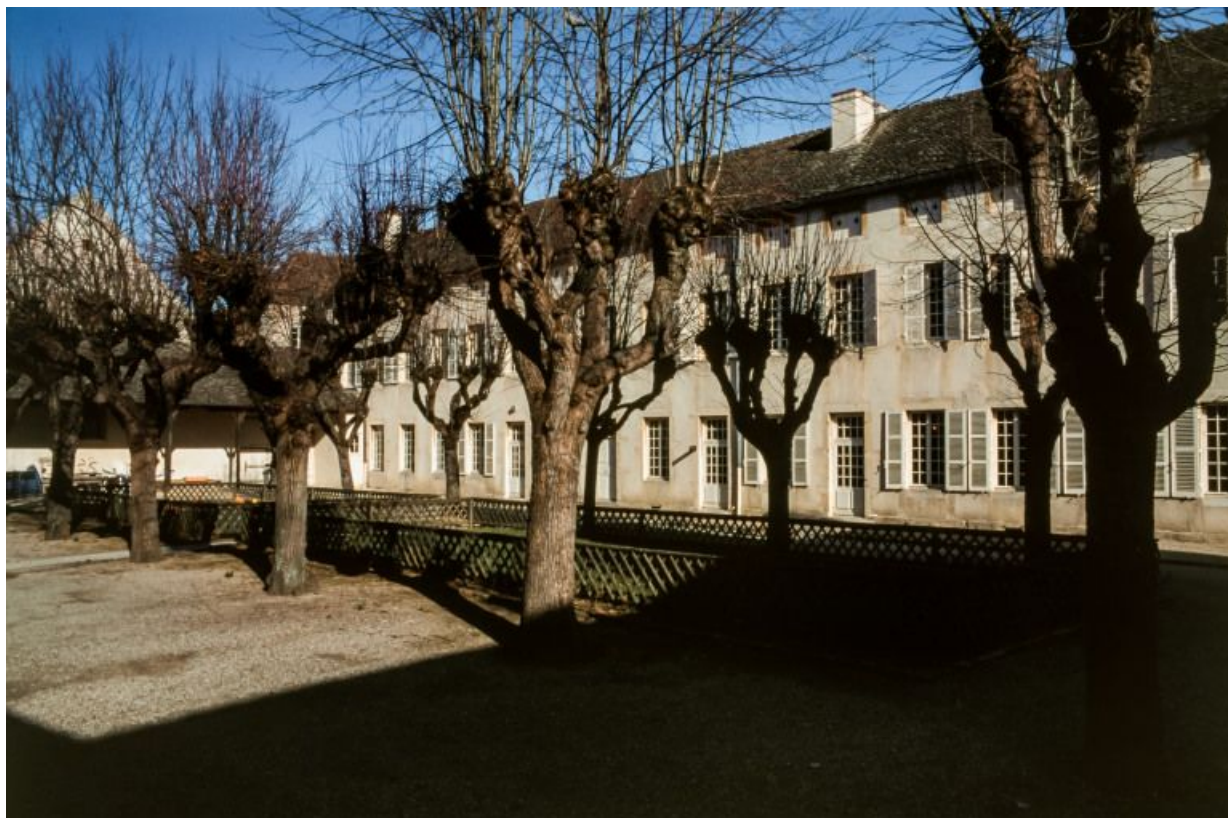
Bâtiment situé à l'est de la cour principale (services Sainte-Anne et Saint-Antoine)
