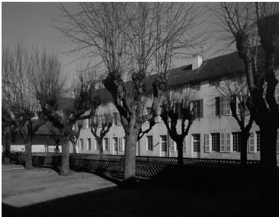
Bâtiment situé à l'est de la cour principale (services Sainte-Anne et Saint-Antoine)
