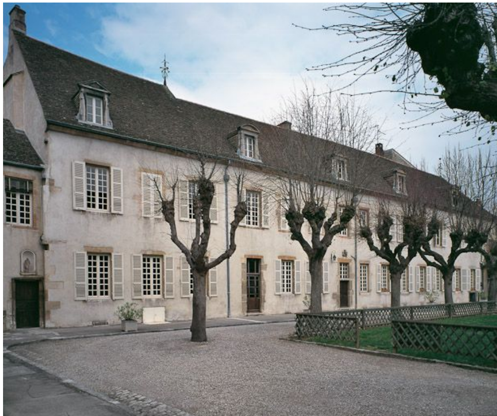
Bâtiment de la Communauté des sœurs et des orphelines, élévation est, sur cour. 21, Beaune, 3 rue Rousseau Deslandes
