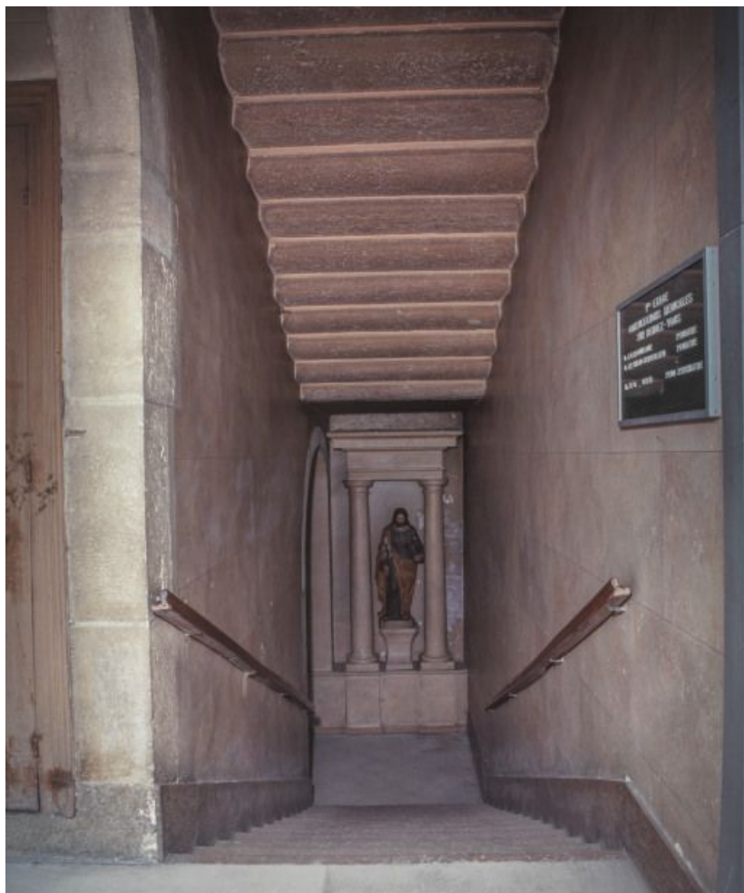
Bâtiment de la Communauté des soeurs et des orphelines, 2e volée de l'escalier principal, vue prise du 2e palier. 21, Beaune, 3 rue Rousseau Deslandes
