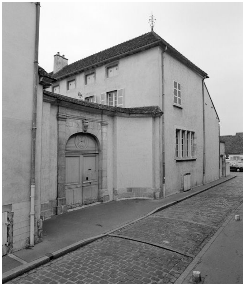
Portail principal et mur de croupe sud du bâtiment des services Sainte-Anne et Saint-Antoine. 21, Beaune, 3 rue Rousseau Deslandes
