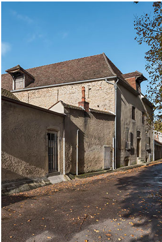
Vue d'ensemble côté rempart de la Comédie, depuis le sud-est.
