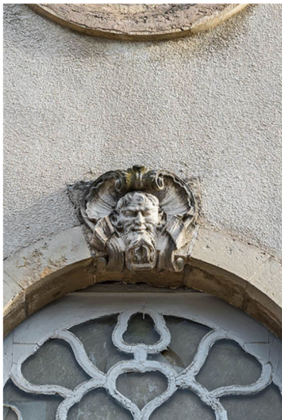
Façade antérieure, travée centrale : claf sculptée de la fenêtre.
