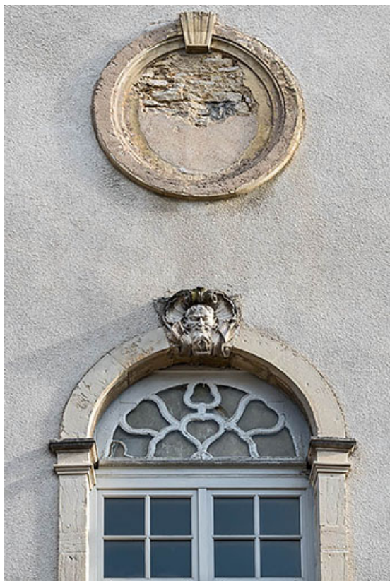
Façade antérieure, travée centrale : baies supérieures.
