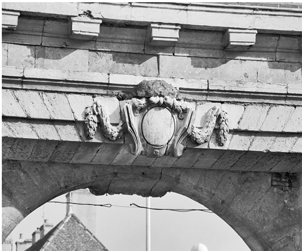
Élévation de la porte Saint-Nicolas, côté ville, détail de l'agrafe 21, Beaune rue de Lorraine
