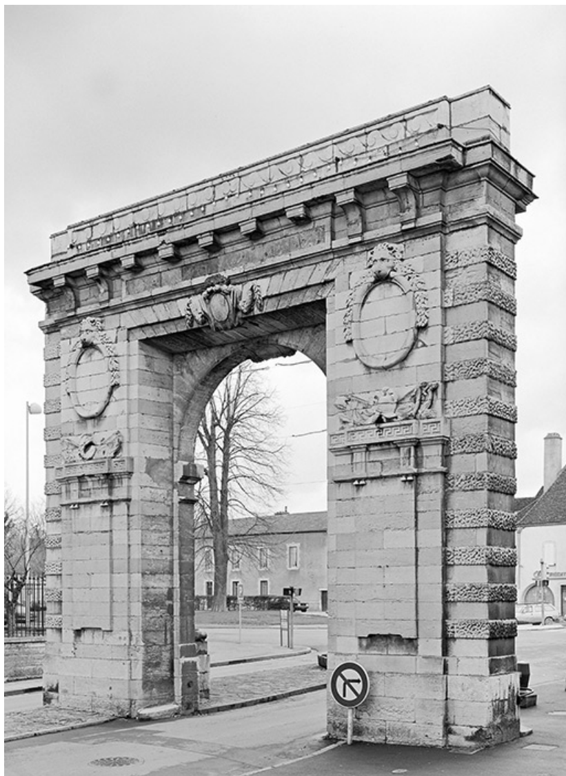
Élévation de la porte Saint-Nicolas, côté ville, trois-quarts droit 21, Beaune rue de Lorraine
