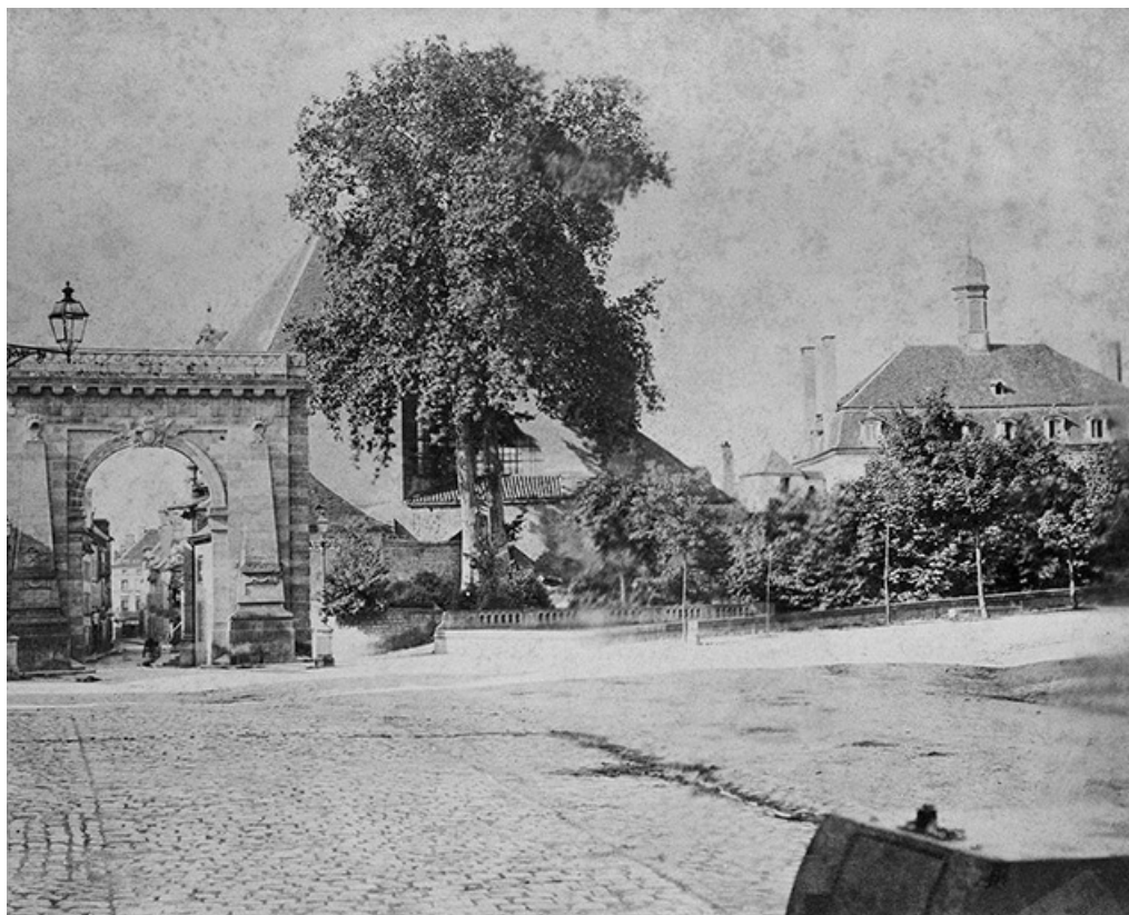
Porte Saint-Nicolas et collège, côté faubourg. S.d [avant la construction de l'école]. 21, Beaune rue de Lorraine
