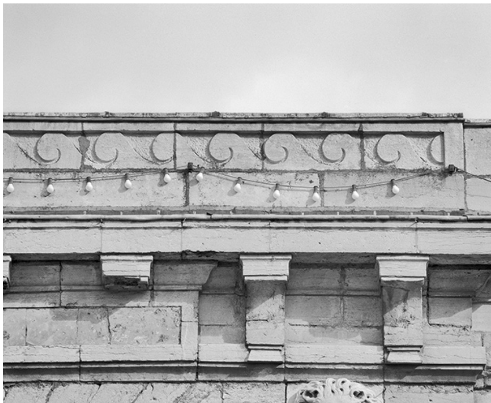
Élévation de la porte Saint-Nicolas, côté ville, détail de la frise de flots 21, Beaune rue de Lorraine
