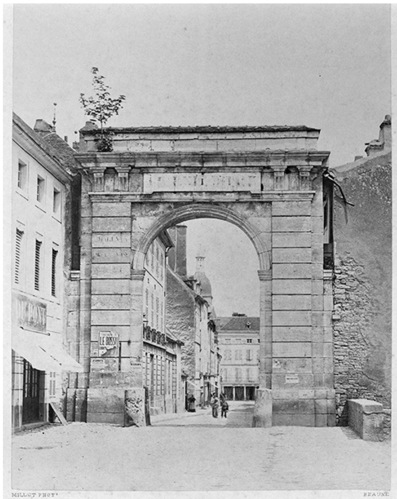
Photographie de la porte côté faubourg. Photographie Millot, avant 1870.
