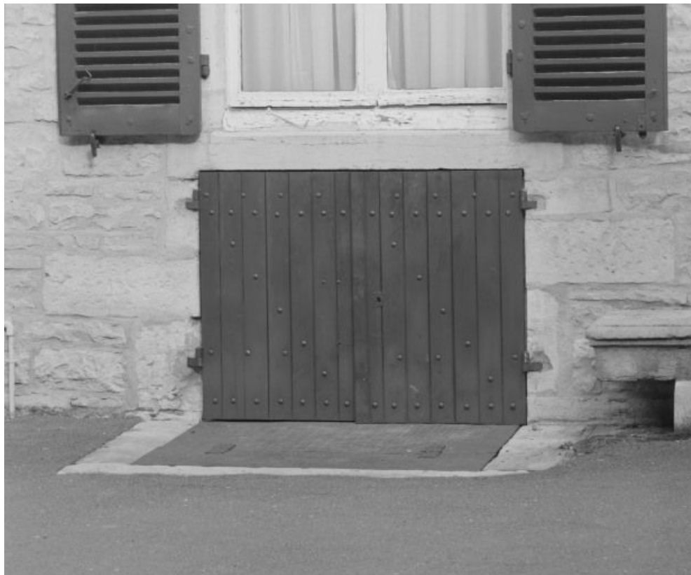
Bâtiment dit de l'administration, détail : porte d'entrée du sous-sol (élévation gauche). 21, Nuits-Saint-Georges Henri-Challand
