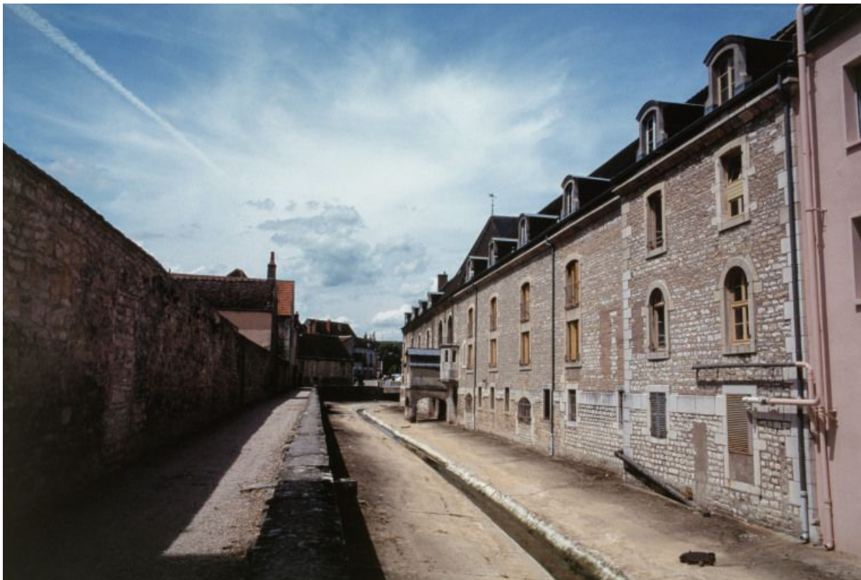
Élévation sur le Meuzin : vue d'ensemble.
