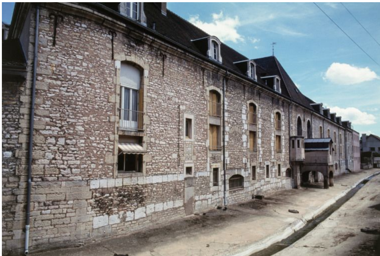
Élévation sur le Meuzin : vue d'ensemble.
