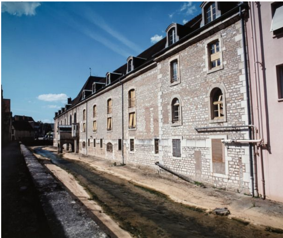
Façade postérieure des salles de malades, sur le Meuzin.
