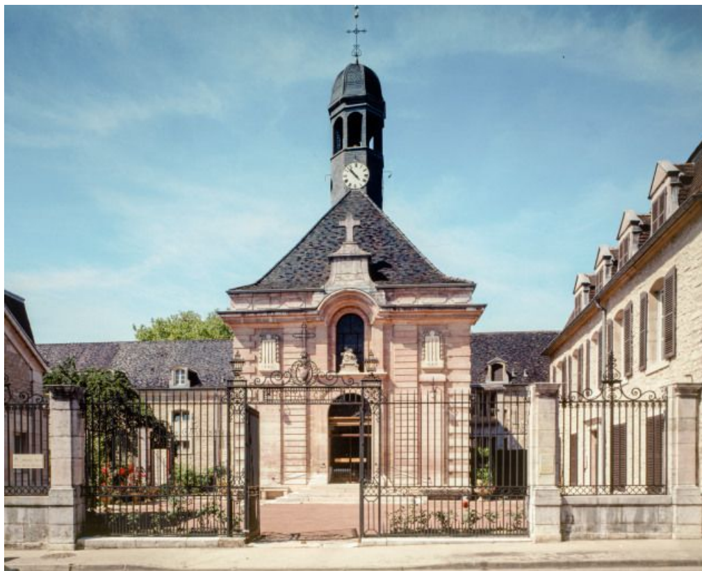
Élévation antérieure de la salle Saint-Laurent, grille d'entrée et bâtiment dit de l'administration. 21, Nuits-Saint-Georges Henri-Challand
