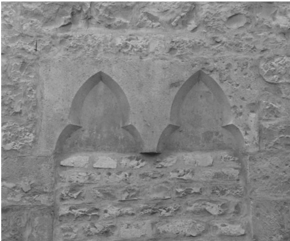
Bâtiment dit de l'administration : vestiges de baies jumelées murées (élévation droite sur la rue). 21, Nuits-Saint-Georges Henri-Challand
