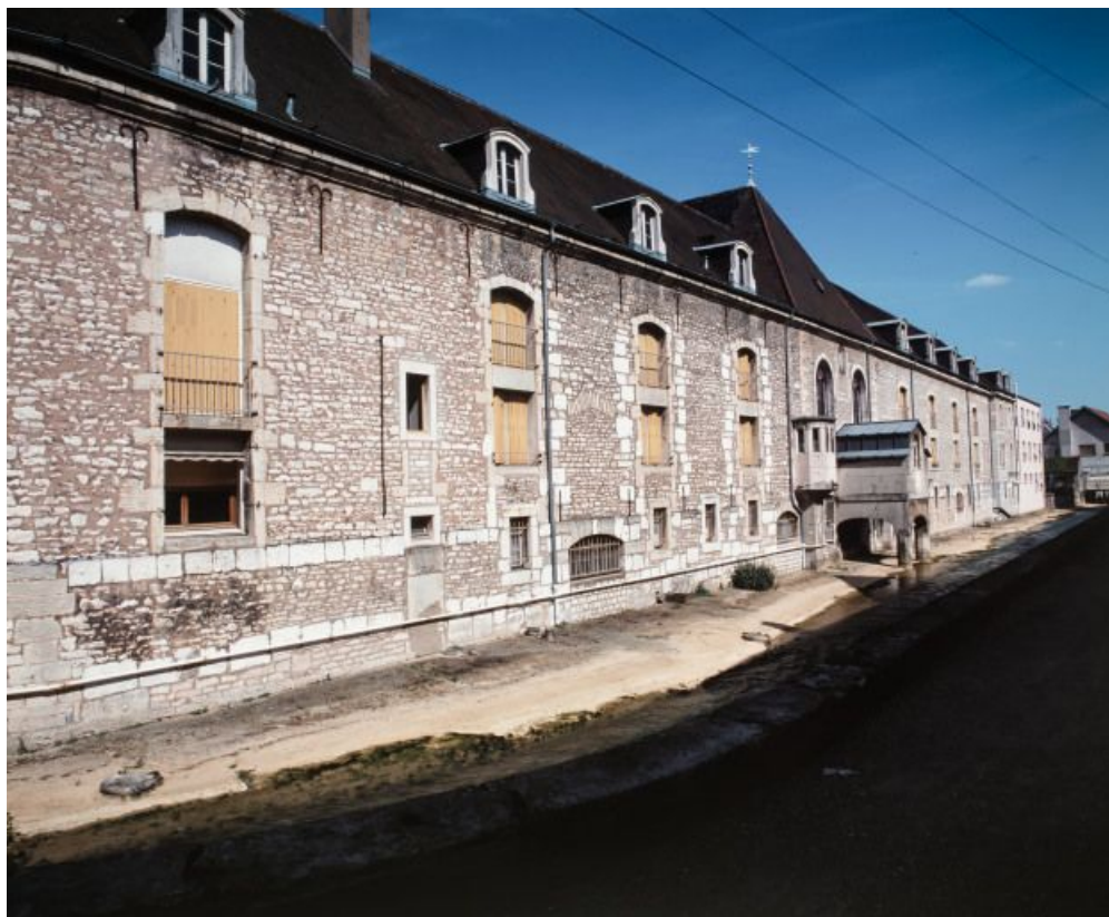
Façade postérieure des salles de malades, sur le Meuzin.
