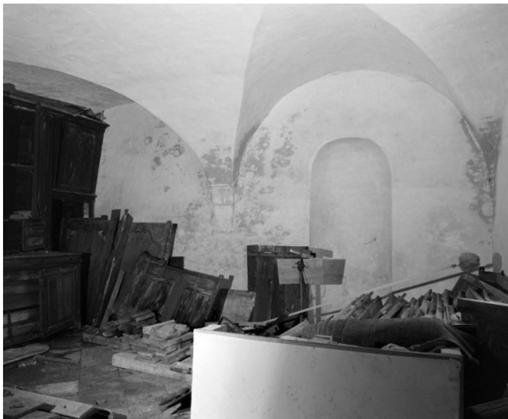
Sacristie : vue d'ensemble prise depuis l'angle sud-est 21, Châtillon-sur-Seine espace Saint-Vorles
