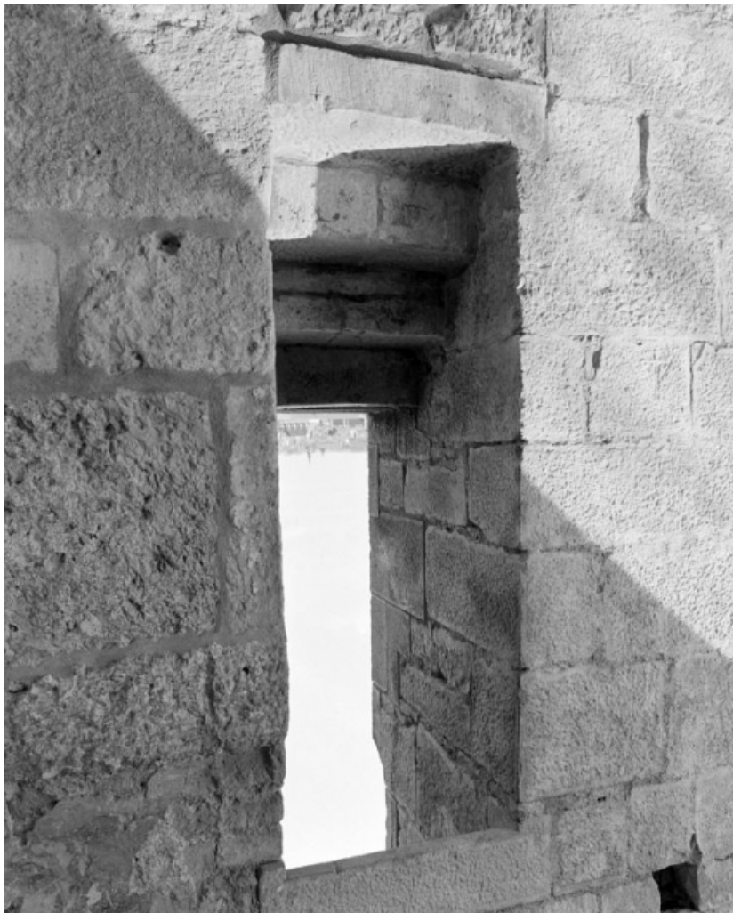
Façade : porche, vestiges d'escalier (mur gauche)
