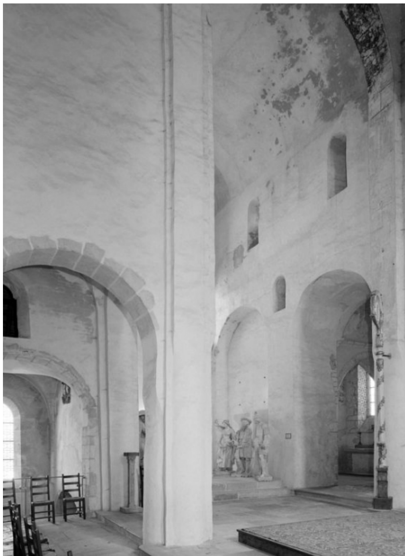
Bras gauche du transept : vue prise de la dernière travée de la nef 21, Châtillon-sur-Seine espace Saint-Vorles
