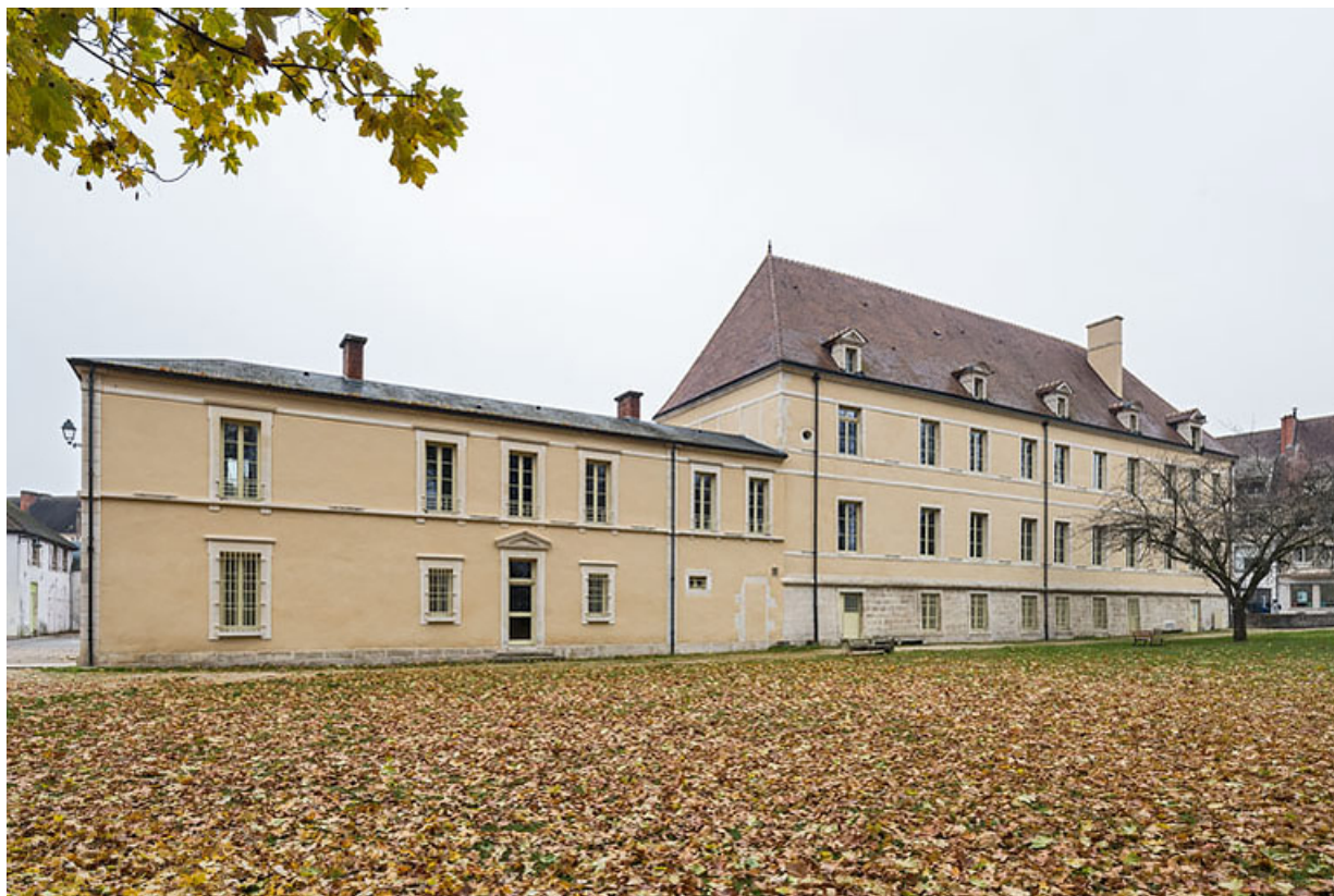
Vue d'ensemble, depuis l'est : extension et aile est.
