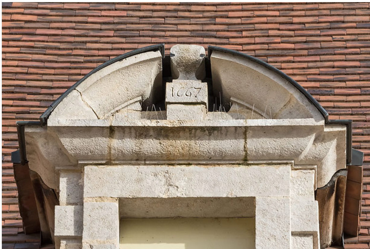
Aile est, façade antérieure : date 1667 sur la lucarne centrale.
