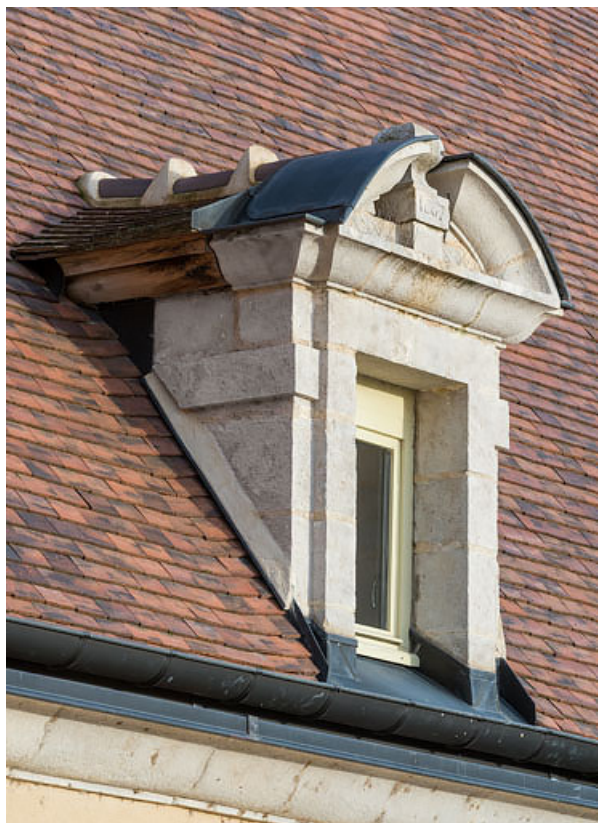
Aile est, façade antérieure : lucarne centrale. 21, Châtillon-sur-Seine place de la Résistance
