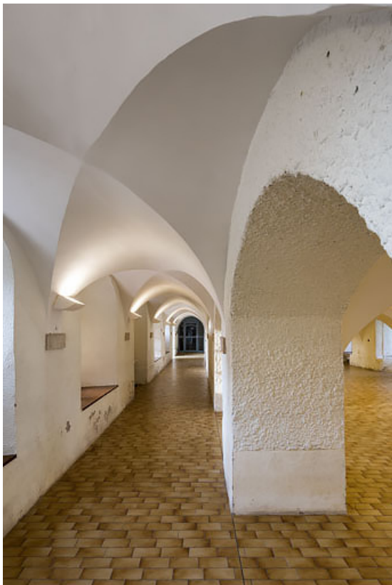
Aile est : couloir voûté desservant le rez-de-chaussée.
