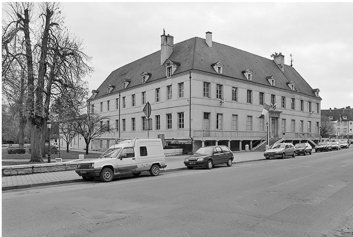
Élévations postérieure et latérale en 1996. 21, Châtillon-sur-Seine place de la Résistance
