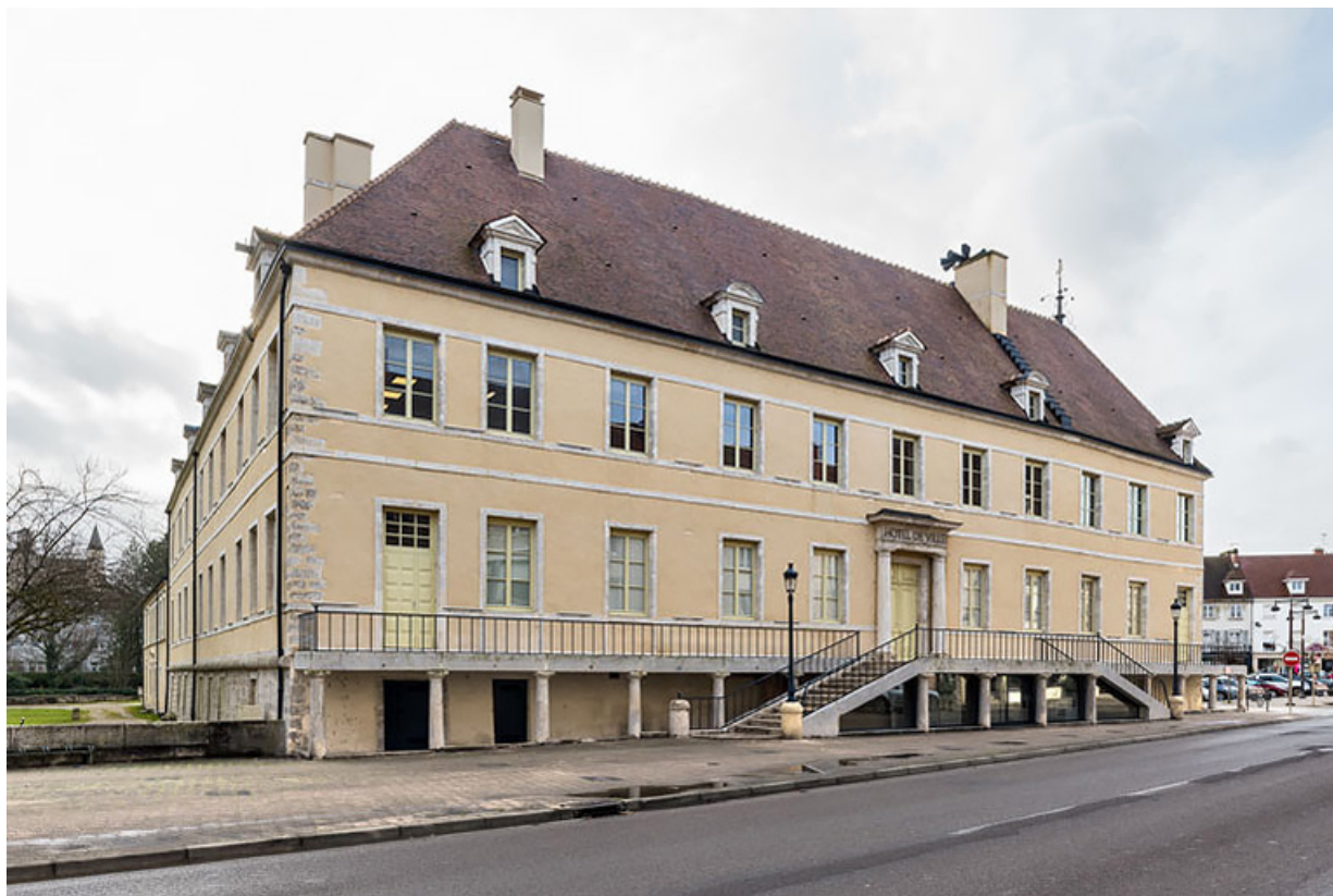
Aile nord : façade antérieure, de trois quarts gauche.
