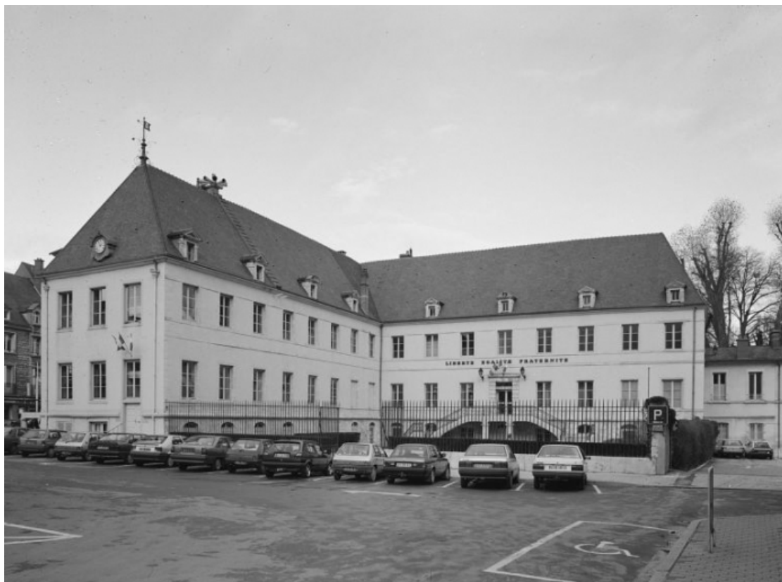
Elévations antérieure et latérale en 1996.
