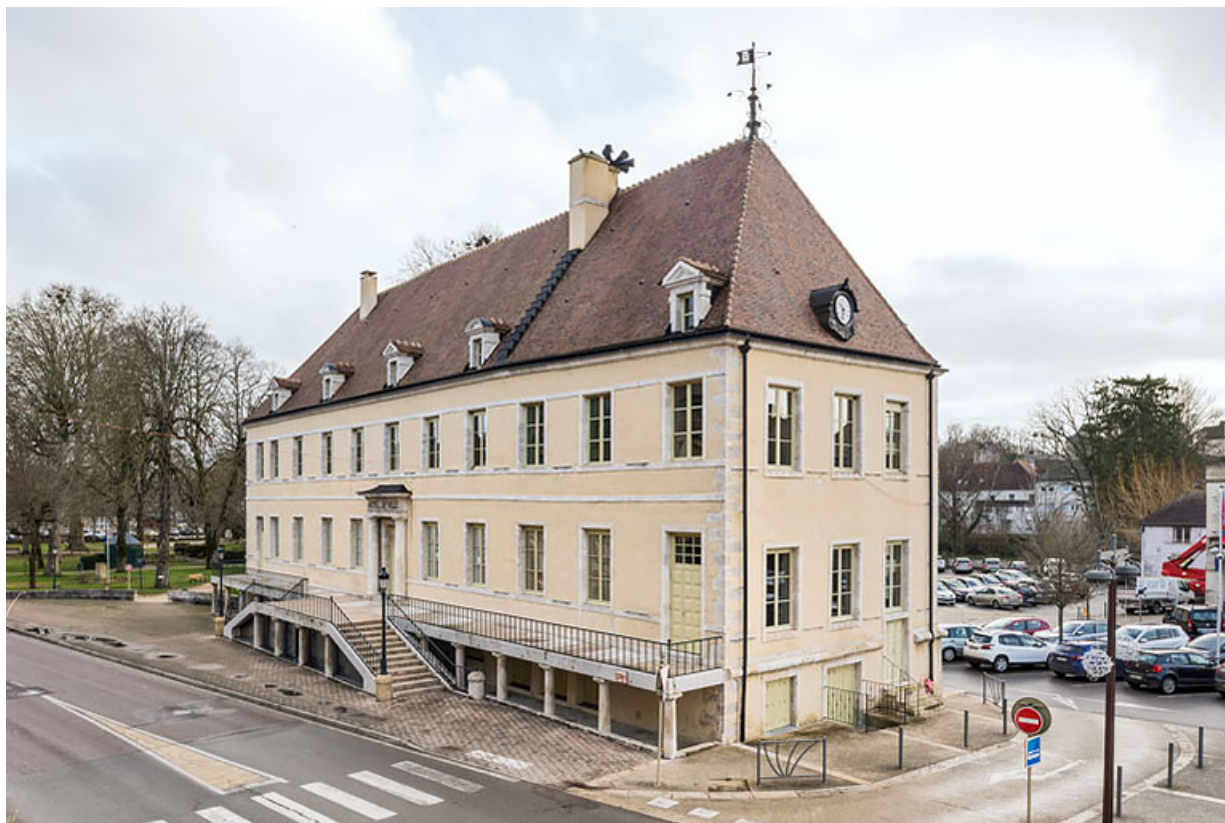
Vue d'ensemble, depuis l'ouest : aile nord. 21, Châtillon-sur-Seine place de la Résistance
