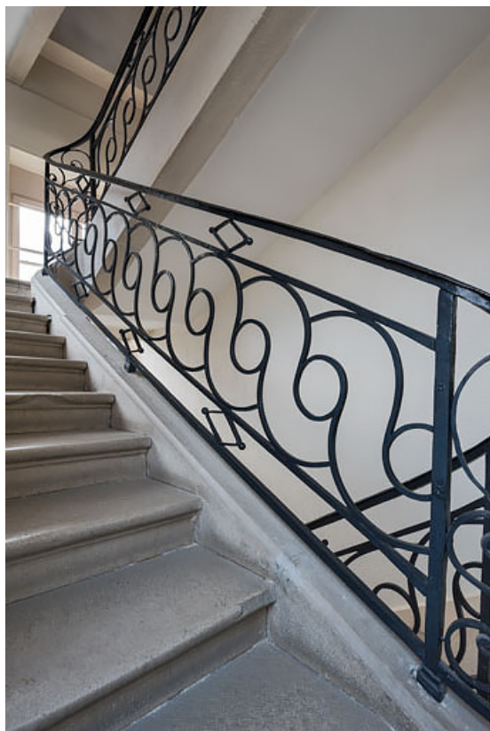
Aile nord : rampe d'appui de l'escalier dans l'angle sud-ouest.
