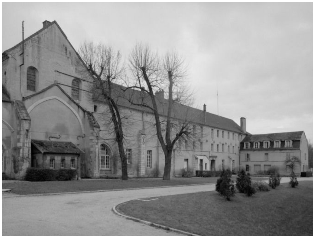
Façade postérieure du bâtiment conventuel et chevet de l'église.
