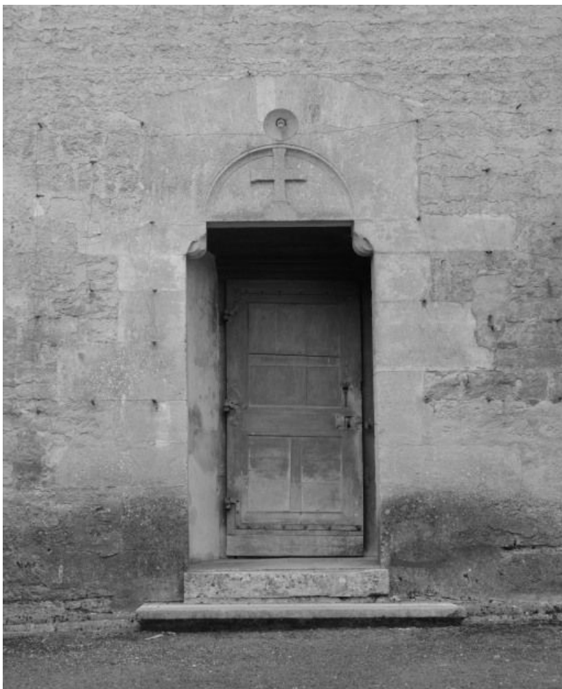
Eglise : élévation gauche, porte de la deuxième travée du bas-côté. 21, Châtillon-sur-Seine, 10 rue de la Libération
