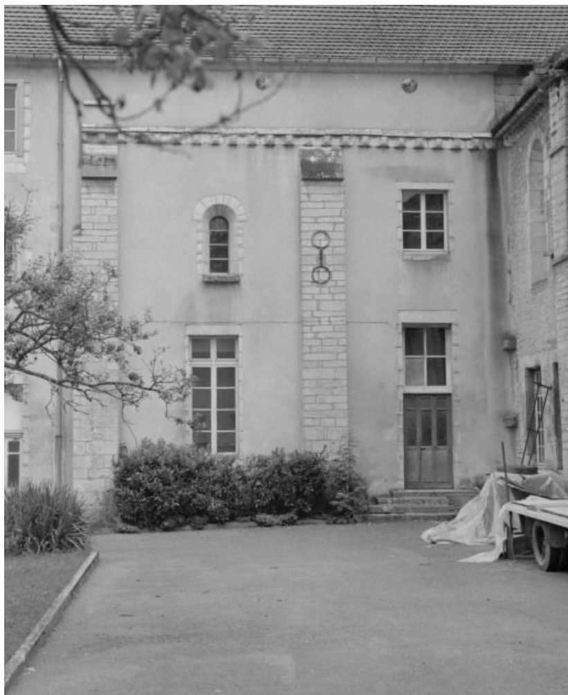
Eglise : bras gauche du transept, élévation antérieure.
