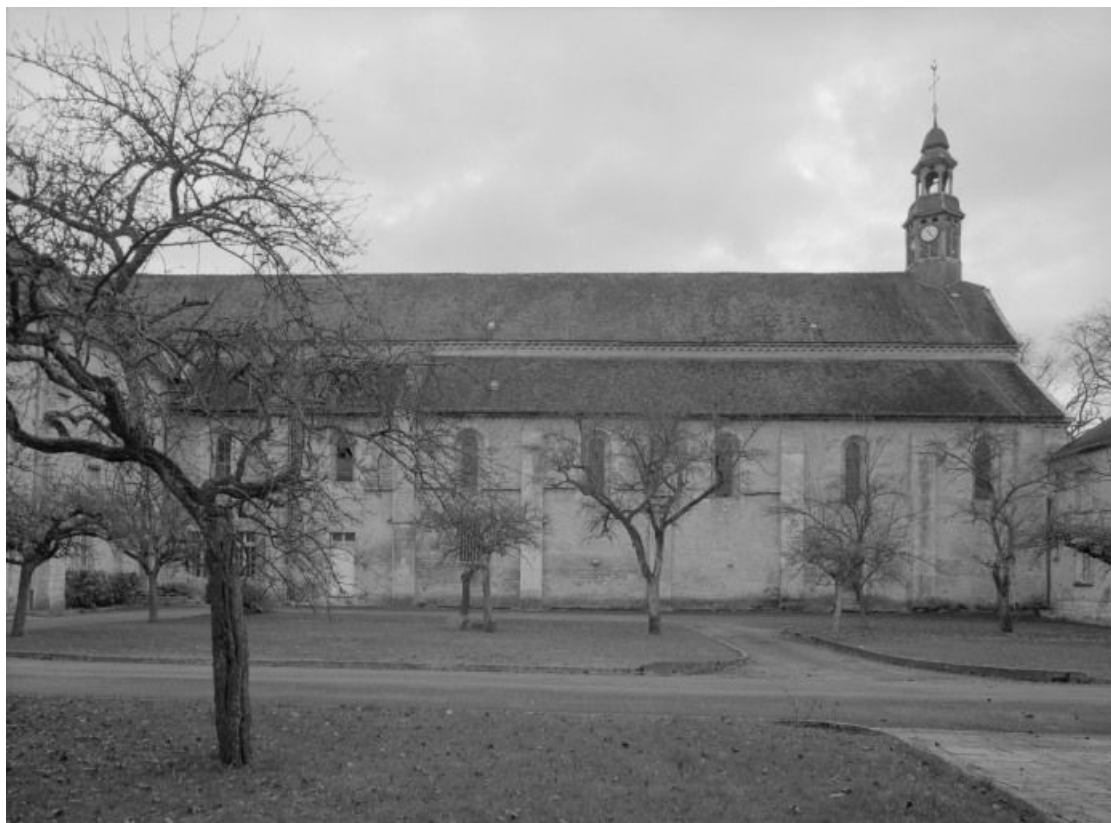
Eglise : élévation gauche.
