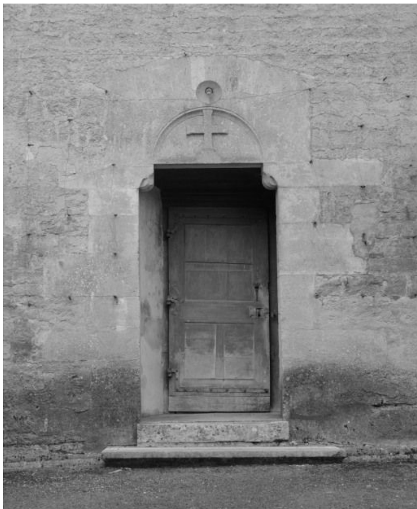
Eglise : élévation gauche, porte de la deuxième travée du bas-côté. 21, Châtillon-sur-Seine, 10 rue de la Libération
