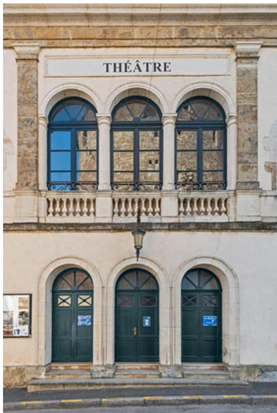
Façade antérieure : travées centrales.
