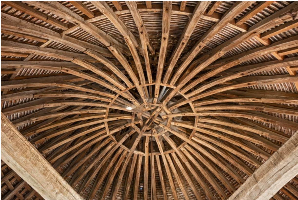
Tour Margot : charpente du 2e étage.
