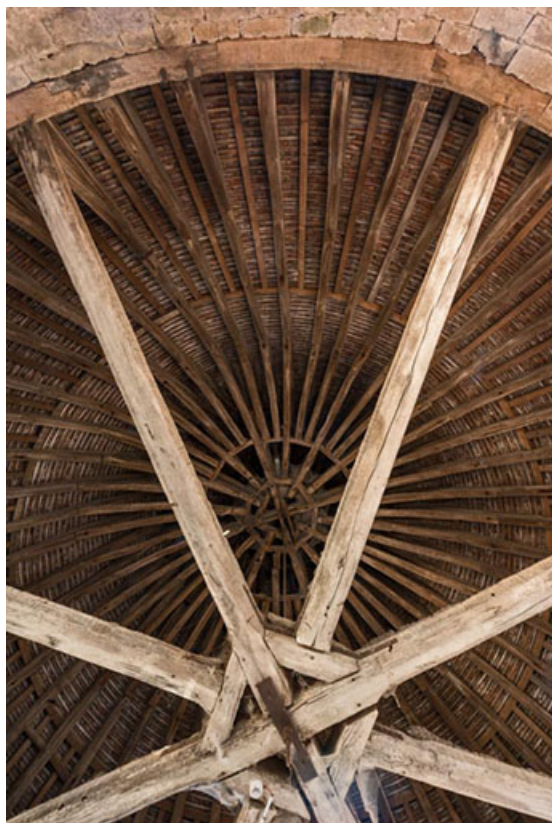
Tour Margot : charpente du 2e étage.
