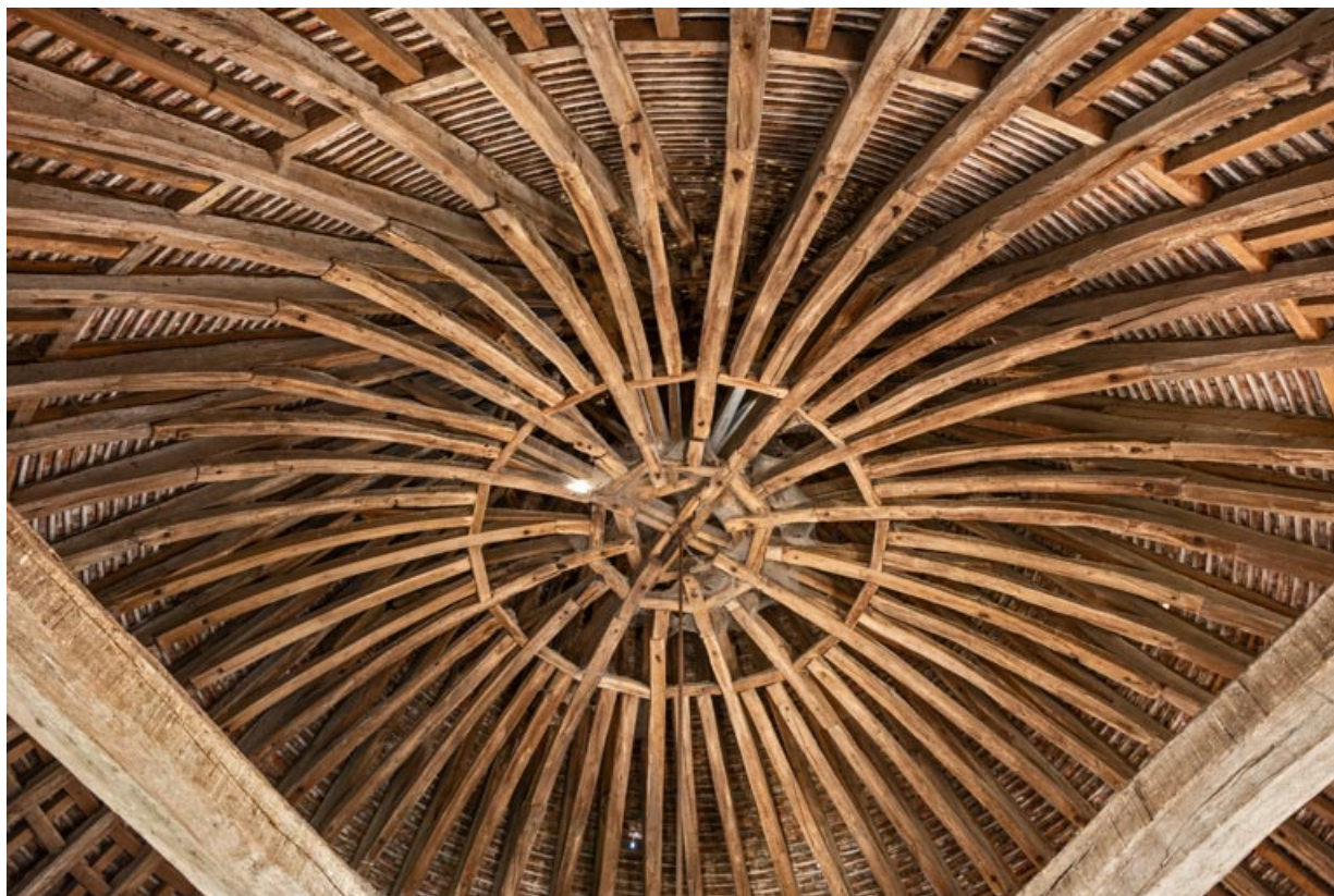
Tour Margot : charpente du 2e étage.
