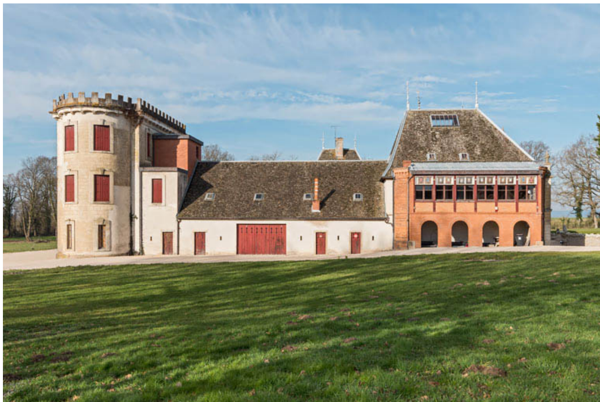
Élévation postérieure (est). De gauche à droite : corps nord (remise, sellerie, salle des fêtes et logement), central (écurie) et sud (chai et théâtre, avec le foyer en avant-plan).
