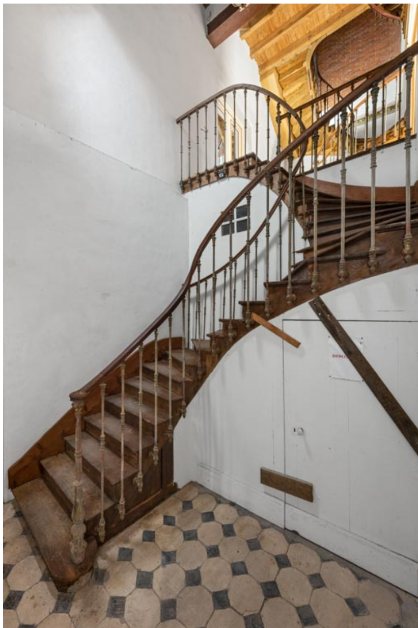
Corps sud : escalier desservant le 1er étage.
