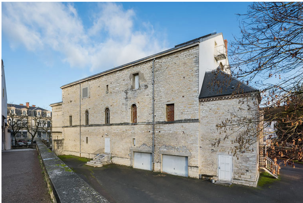
Façade latérale droite, de trois quarts droite. 21, Beaune, 64 rue de Lorraine
