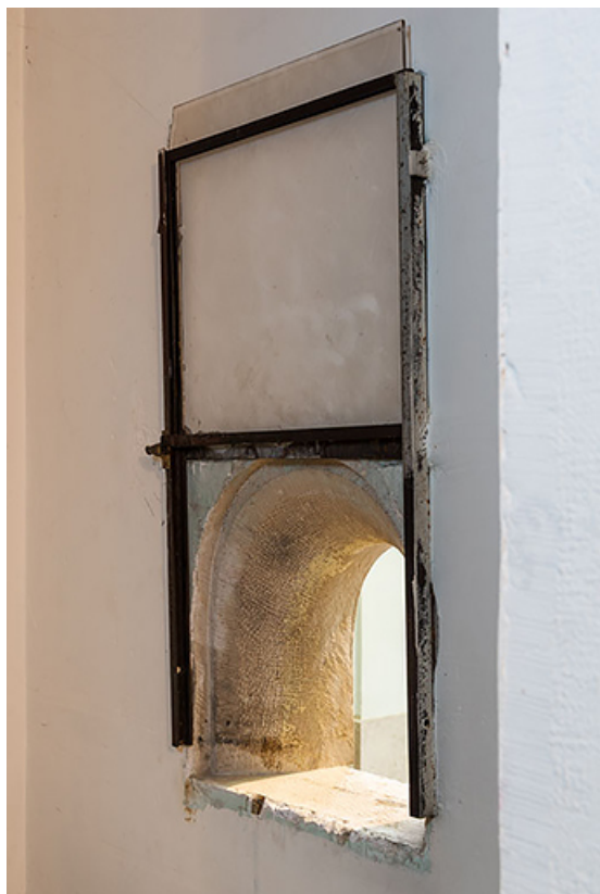
Vestibule : ancien guichet de la partie droite, vu depuis le bureau. 21, Beaune, 64 rue de Lorraine
