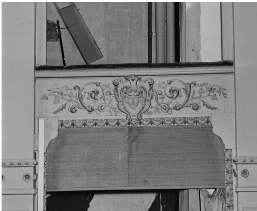
Salle : détail du garde-corps de la 2e loge d'avant-scène, côté jardin, en 1988, avant restauration. 21, Beaune, 64 rue de Lorraine
