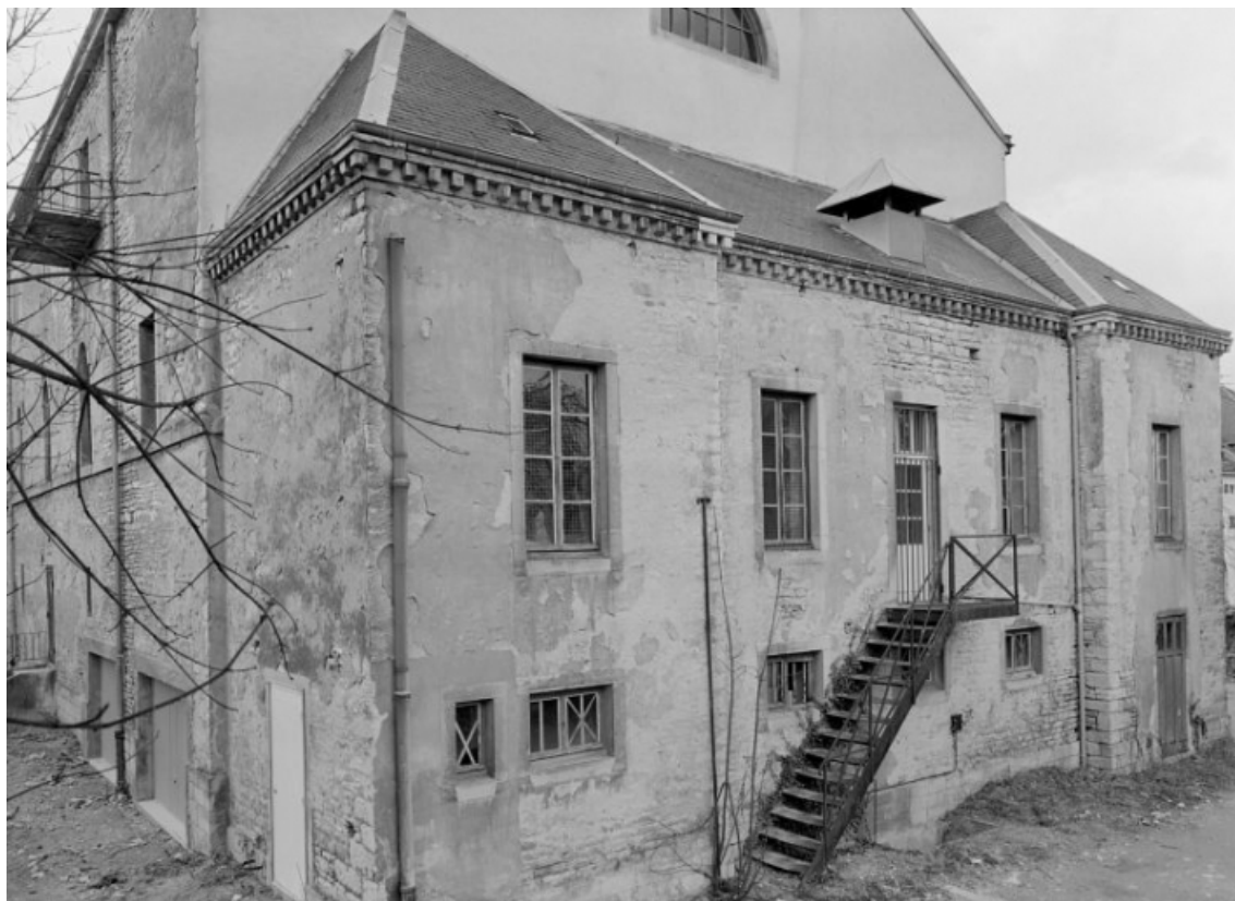
Élévation postérieure, en 1988.
