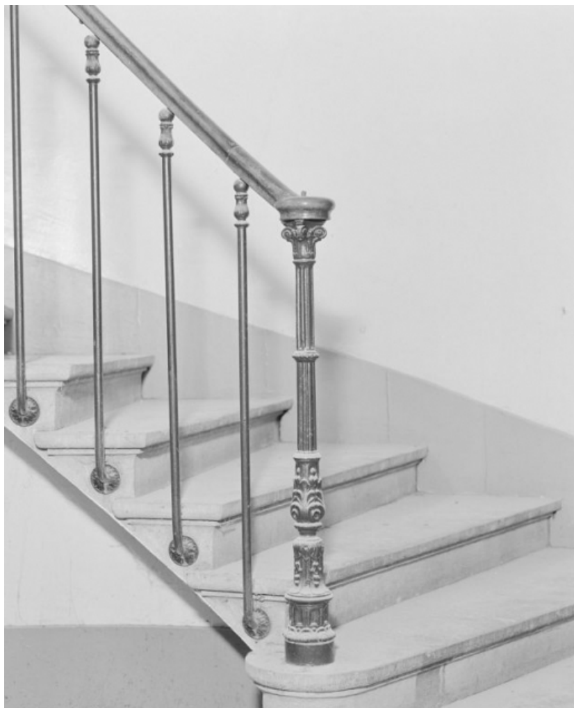
Détail du départ d'escalier menant aux galeries par la droite, en 1988.
