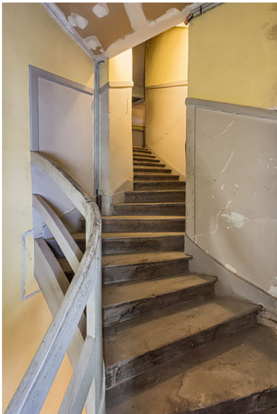
Escalier conduisant au 3e balcon (côté cour) : jonction entre le corps d'entrée et le corps principal. 21, Beaune, 64 rue de Lorraine
