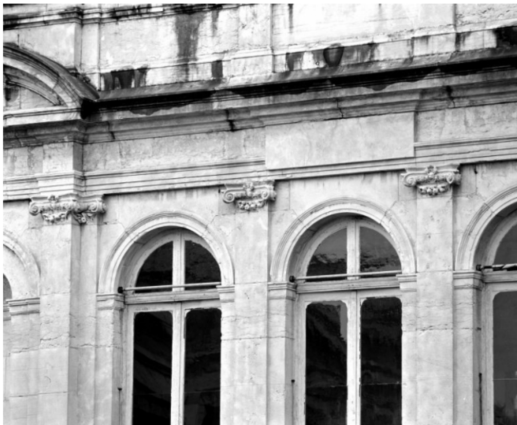
Façade : détail de l'entablement, en 1988.
