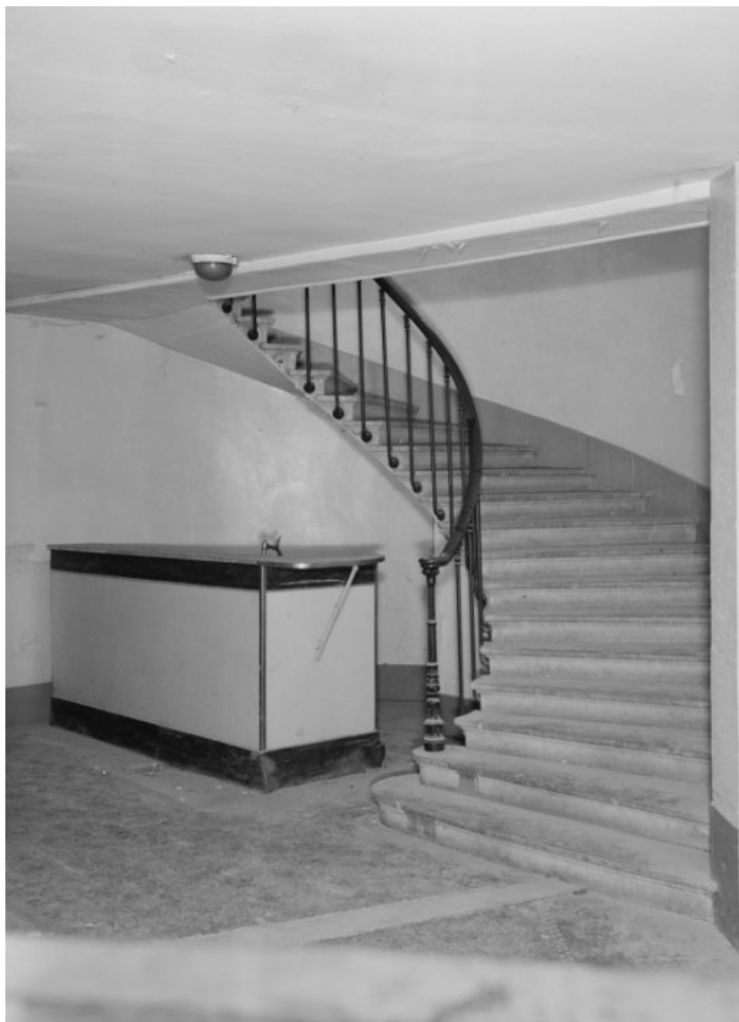
Escalier menant aux galeries par la droite, en 1988.
