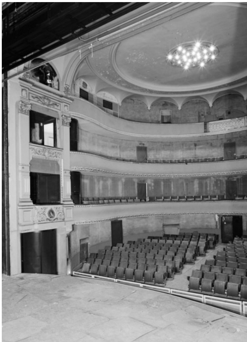
Salle : côté cour (partie gauche) en 1988, avant restauration. 21, Beaune, 64 rue de Lorraine
