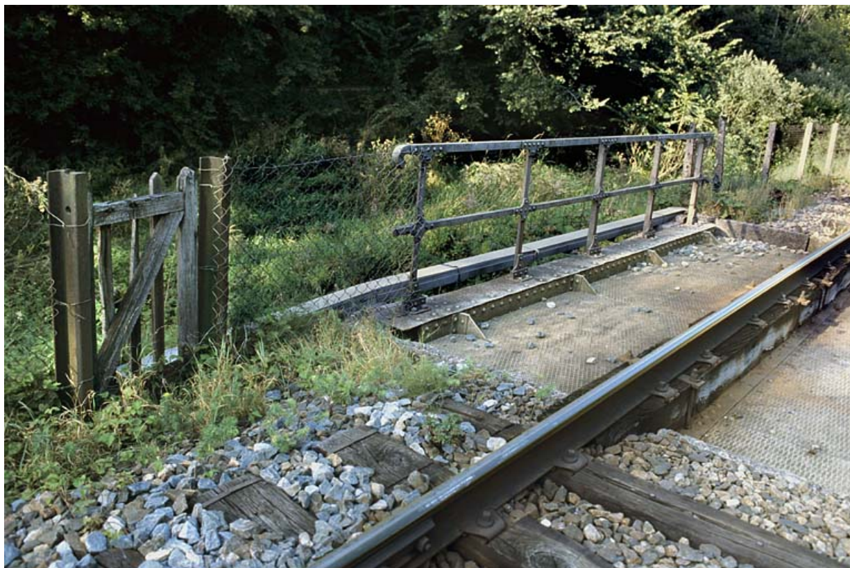
Vue d'ensemble, depuis la voie côté La Cluse (sud-ouest).
