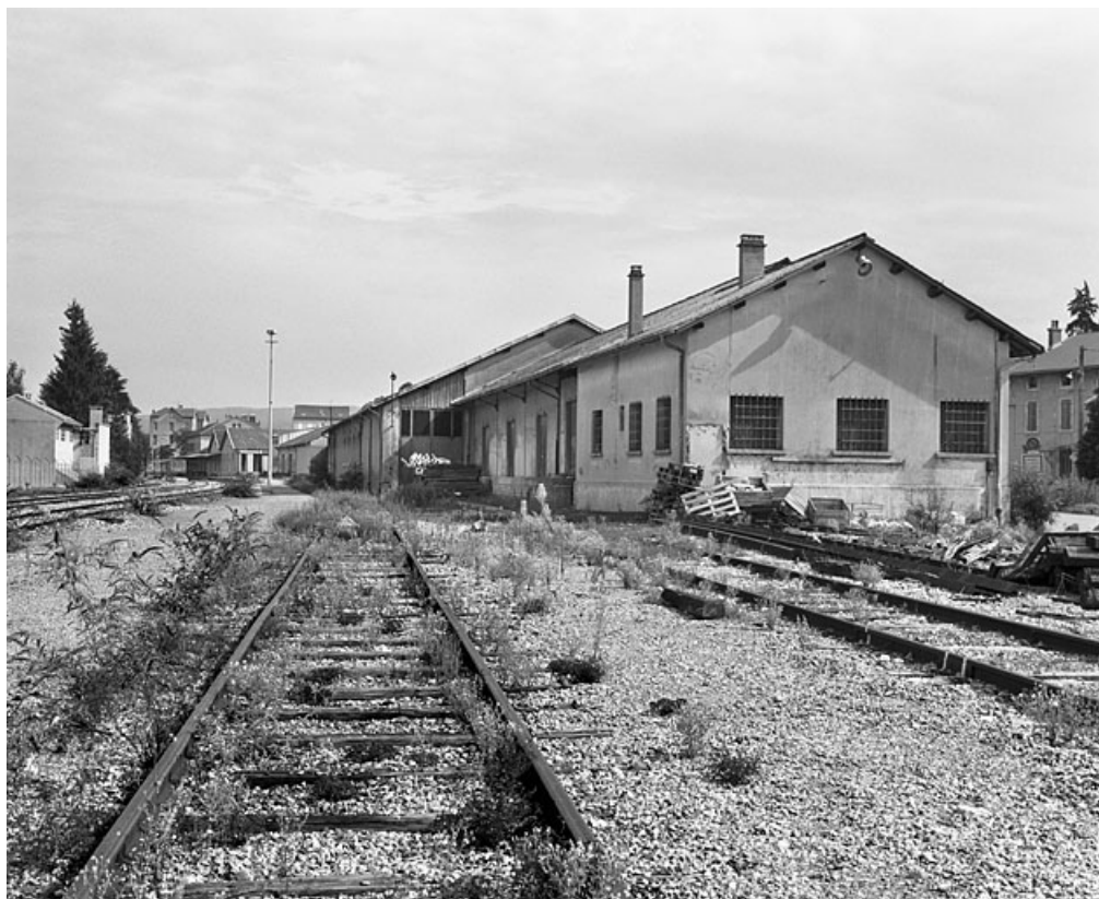
Entrepôts, depuis le sud-ouest (côté La Cluse).
