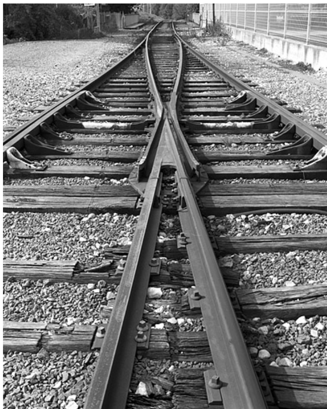
Appareil de voie (" aiguillage ") à l'extrémité de la gare, côté La Cluse (sud-ouest). 01, Oyonnax place Vaillant Couturier
