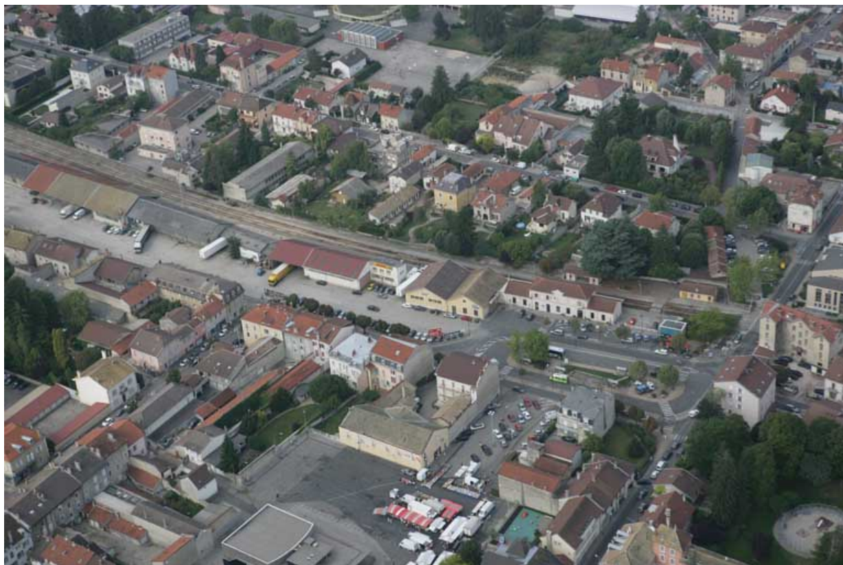
Vue aérienne du bâtiment des voyageurs et des entrepôts, depuis l'est. 01, Oyonnax place Vaillant Couturier
