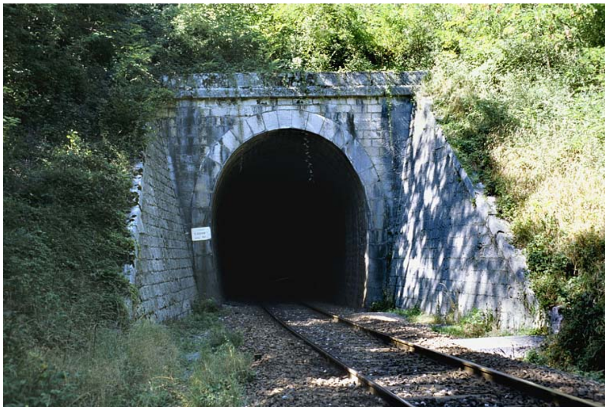
Tunnel d'Arbent 1 : tête côté La Cluse (sud-est). 01, Arbent rue du Point B, lieudit : la Queue du Lac
