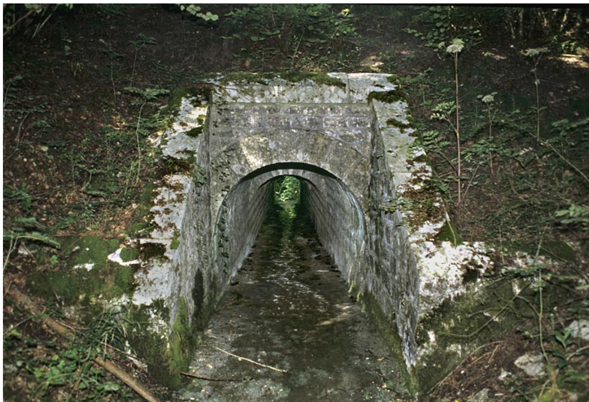
Tête amont (avec éclairage au flash).
