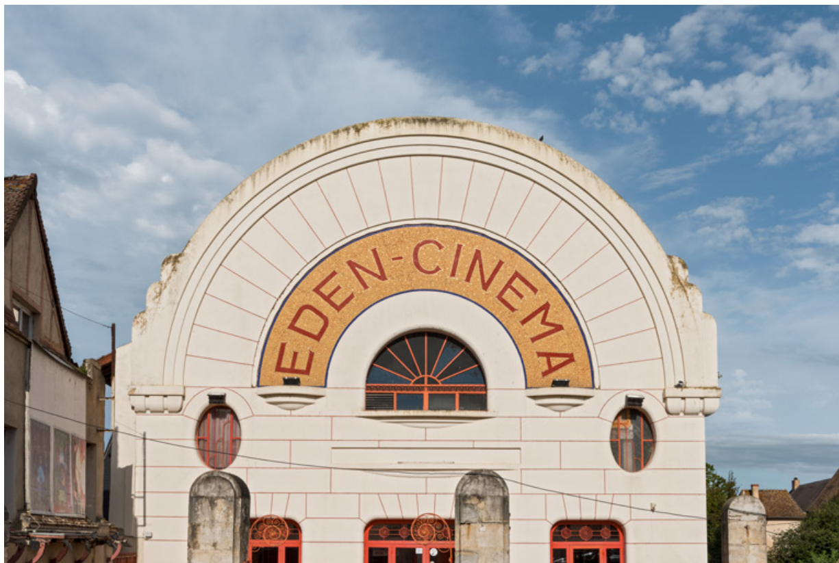
Façade antérieure : partie haute.
