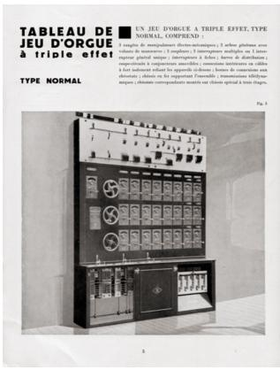
Cie générale de Travaux d'éclairage et de Force (Anciens Ets Clémençon). Appareillages électriques pour théâtre [catalogue]. Tableau de jeu d'orque à triple effet, type normal. S.d. [années 1940-1950].
