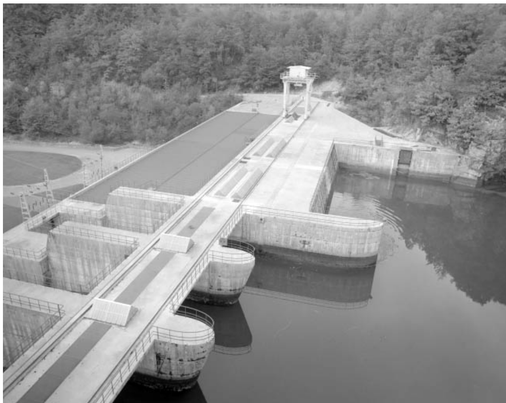
Evacuateur de crue et toiture de l'usine.
