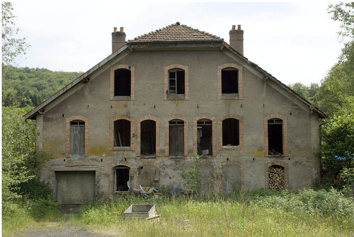
Bâtiment industriel du puits du Magny (commune de Magny-d'Anigon).
