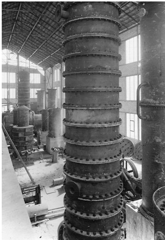
Intérieur de la raffinerie. Colonnes de distillation.
