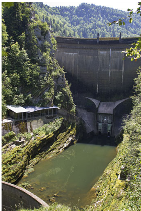
Barrage du Châtelot : le bassin d'amortissement.
