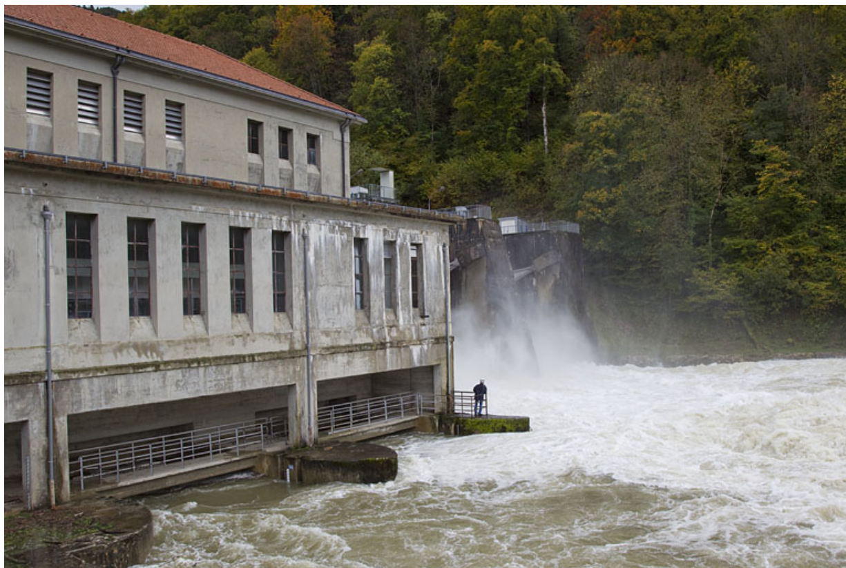
Elévation aval de la centrale, en période de crue.
