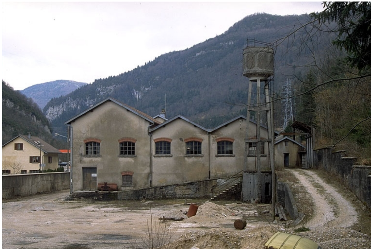
Cour, atelier de fabrication et château d'eau.
