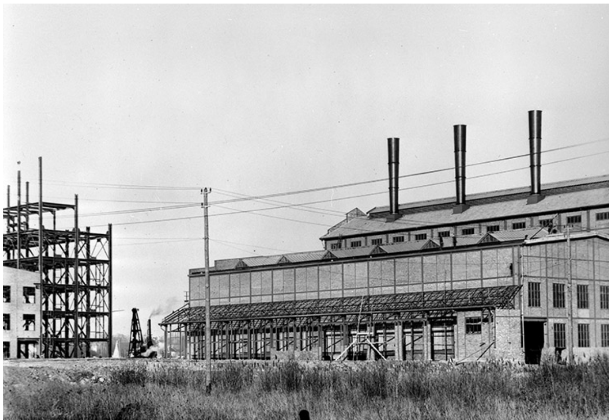
Générateurs de vapeur et d'électricité en construction.
