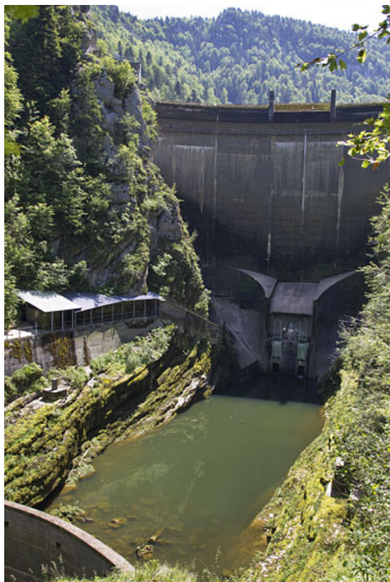
Barrage du Châtelot : le bassin d'amortissement.
