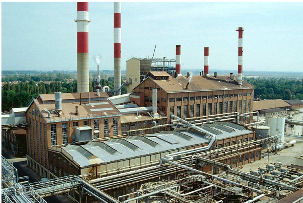
Chaudière et générateurs de vapeur et d'électricité (19), vus depuis le haut de la soudière.
