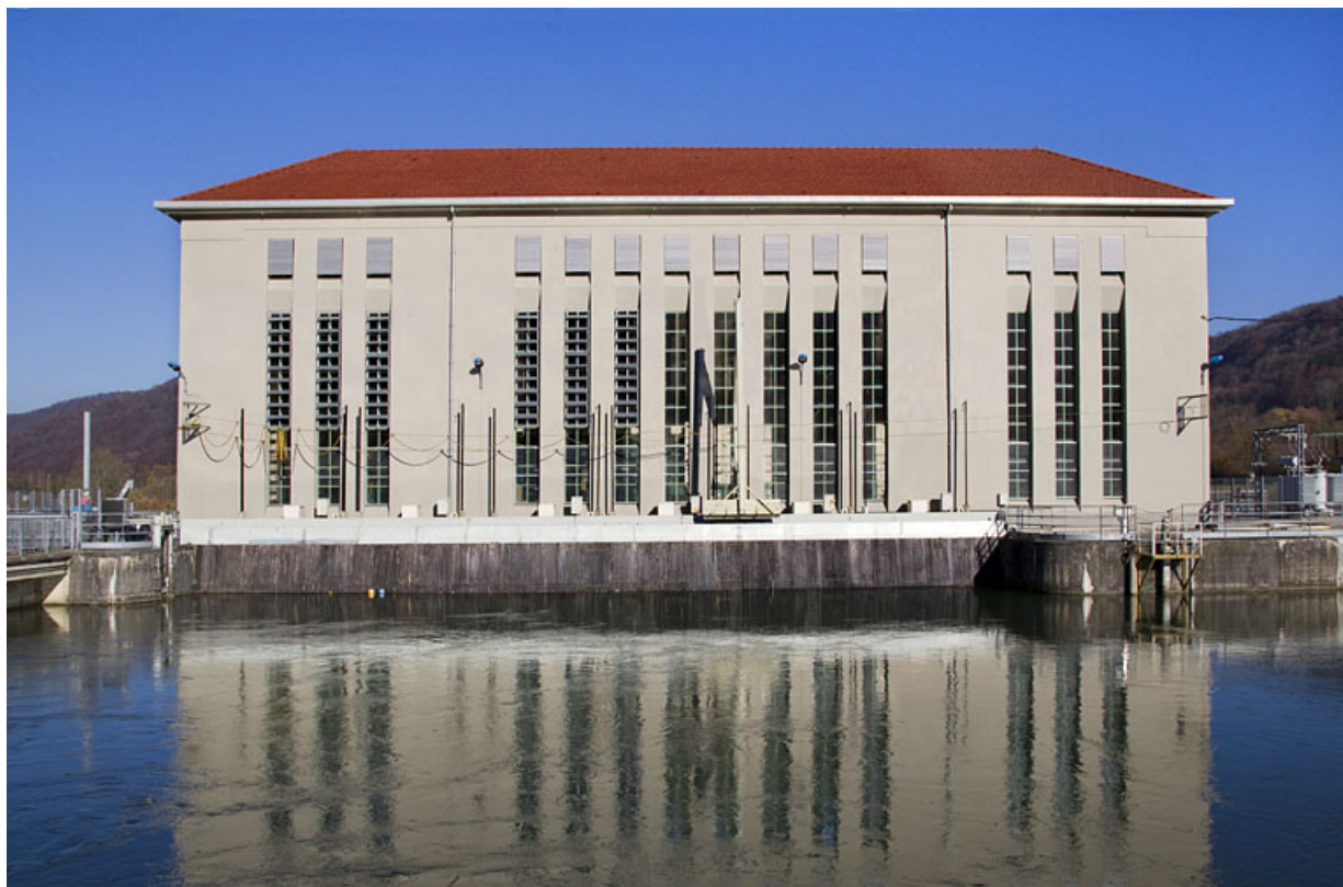
Façade sud de la salle des machines.
