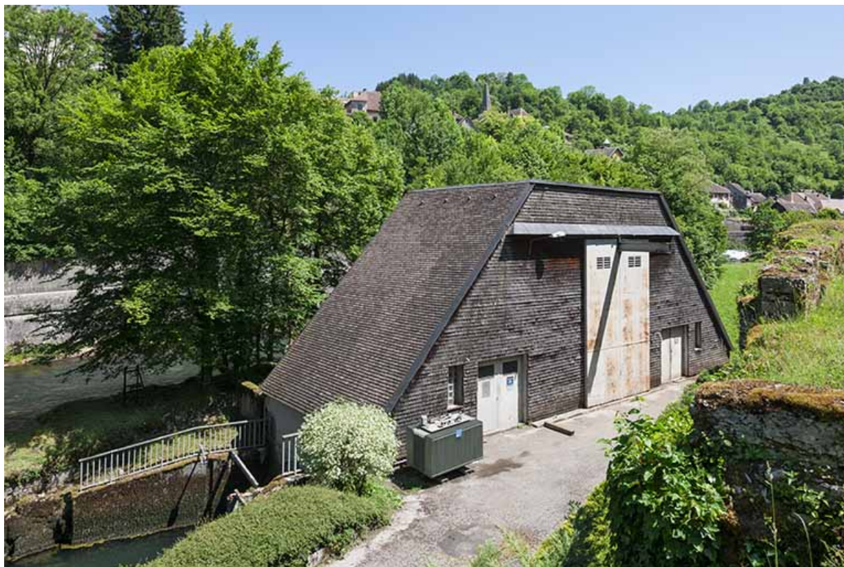
La centrale hydroélectrique vue de trois quarts.
