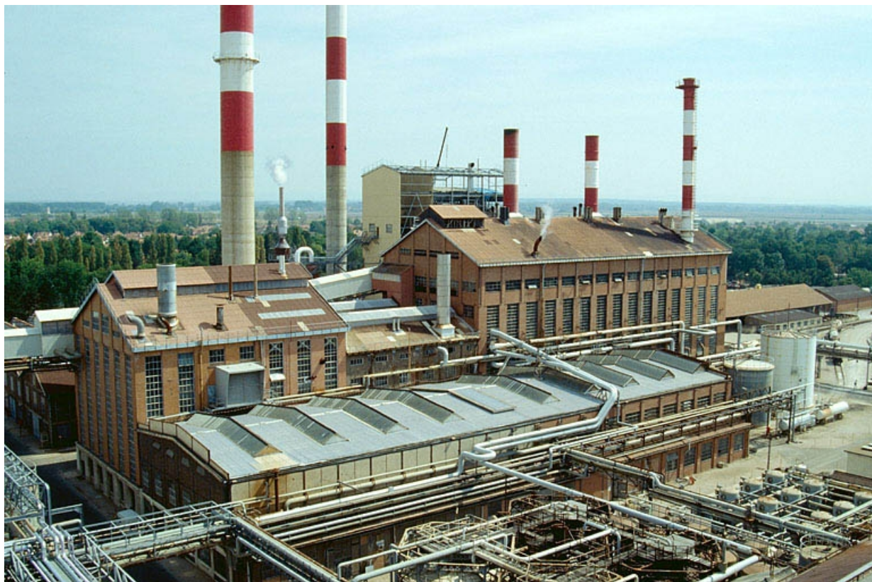
Chaufferie et générateurs de vapeur et d'électricité (19), vus depuis le haut de la soudière.
