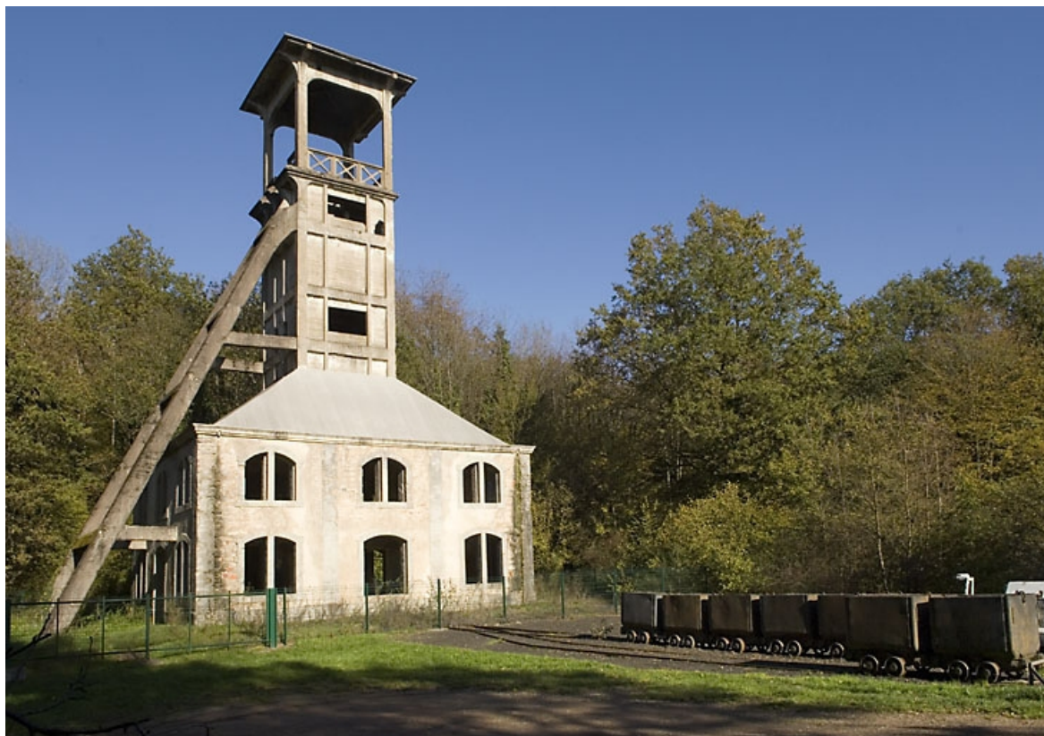
Le chevalement. Vue d'ensemble depuis l'ouest.
