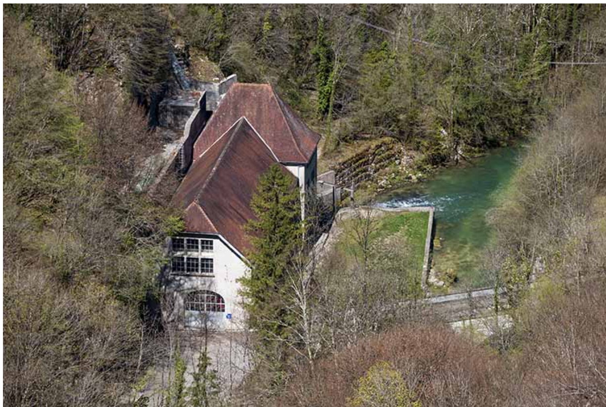
Vue plongeante sur la centrale hydroélectrique depuis le sud-est.
