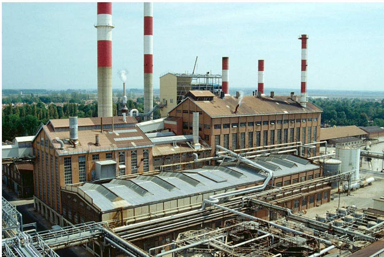
Chaudière et générateurs de vapeur et d'électricité (19), vus depuis le haut de la soudière.
