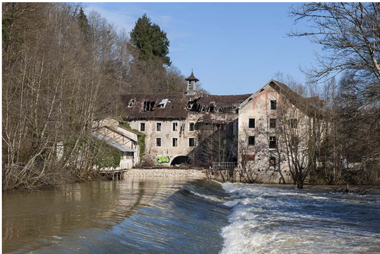
Vue depuis la rive droite du barrage.
