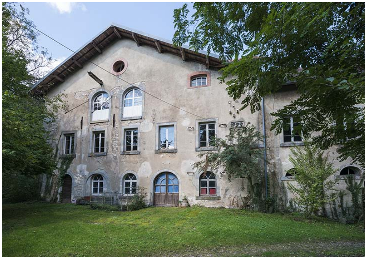
Façade antérieure de l'atelier de fabrication.
