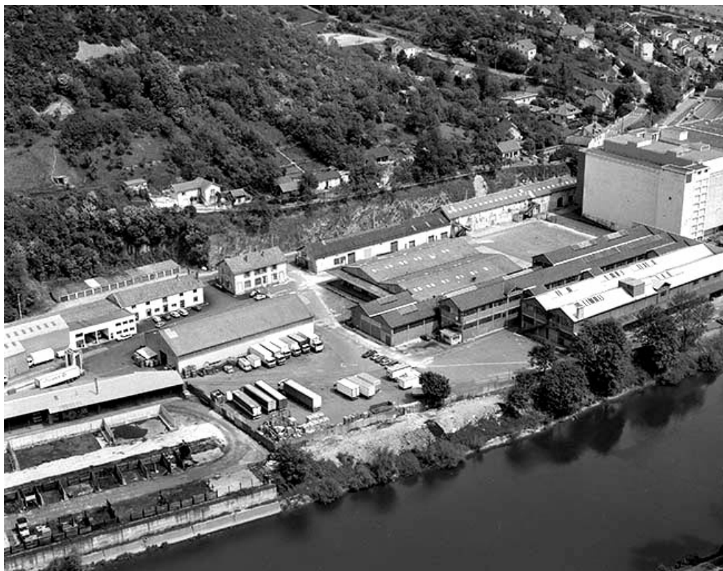
Usine B : bâtiments de l'ancienne papeterie.
