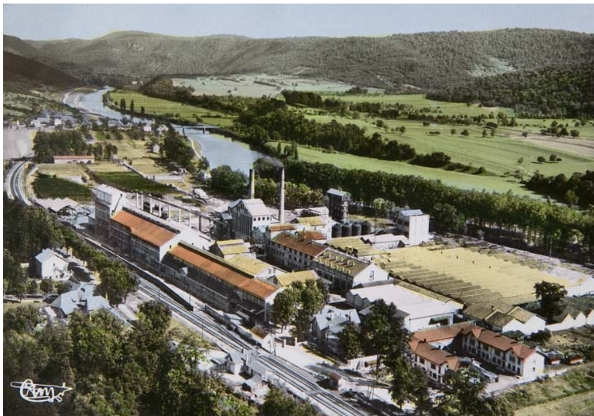
Vue aérienne, depuis le nord-ouest.
