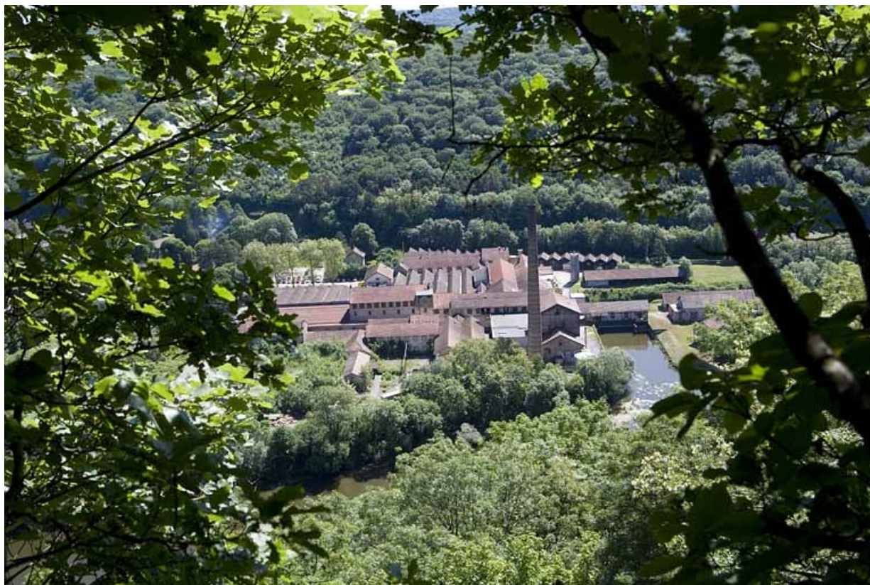
Vue plongeante depuis l'ouest.
