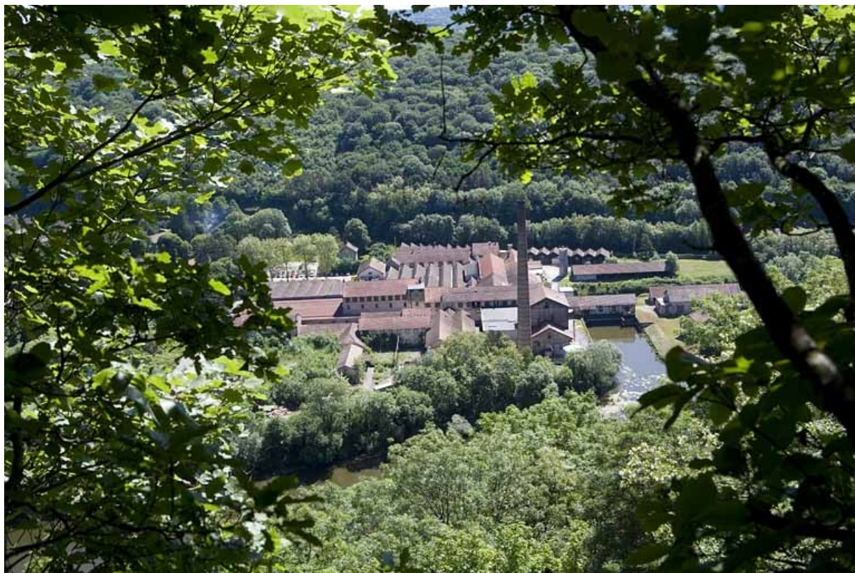
Vue plongeante depuis l'ouest.
