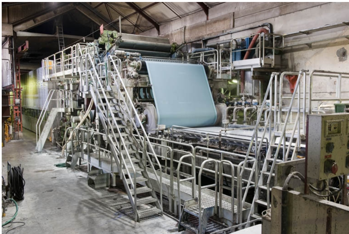
Partie amont de la machine à papier : table de fabrication et tête de machine.
