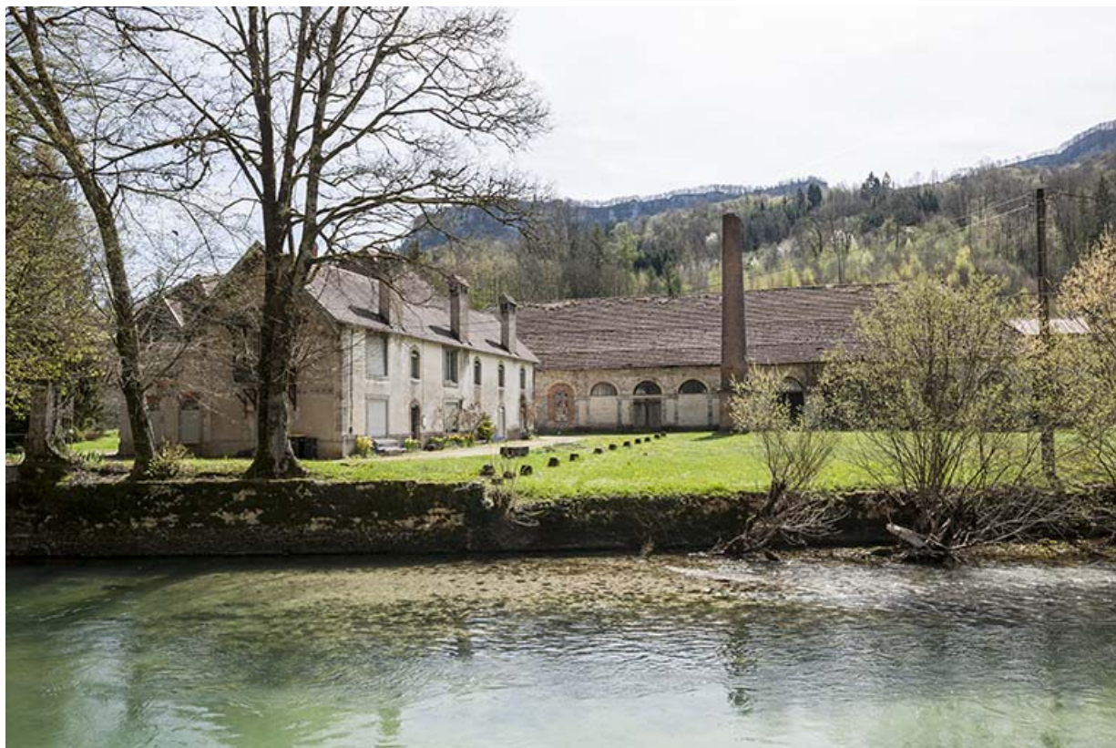
Logement et atelier depuis le nord.
