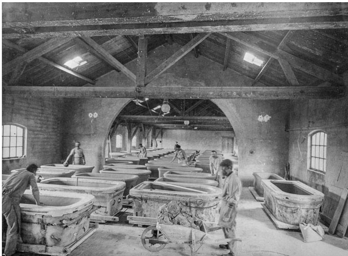
Le moulage des baignoires (bâtiment 42).
