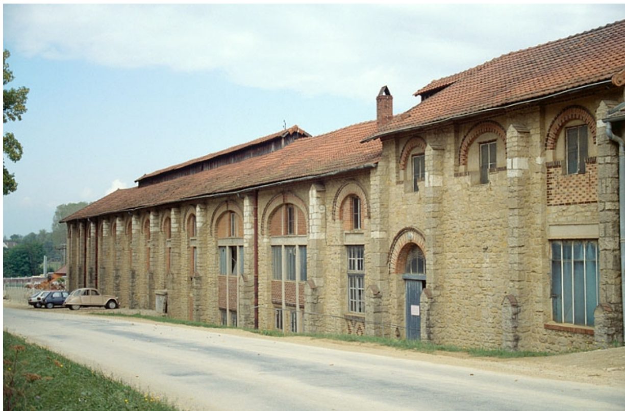
Atelier (A) : façade sur route.
