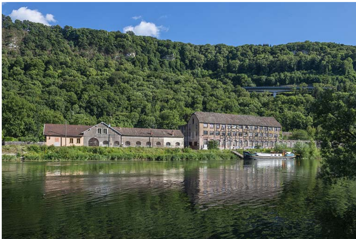
Vue d'ensemble depuis le nord (rive droite du Doubs).
