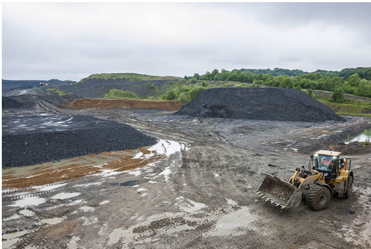
Chargeuse sur pneus devant le poste de préparation des terres.
