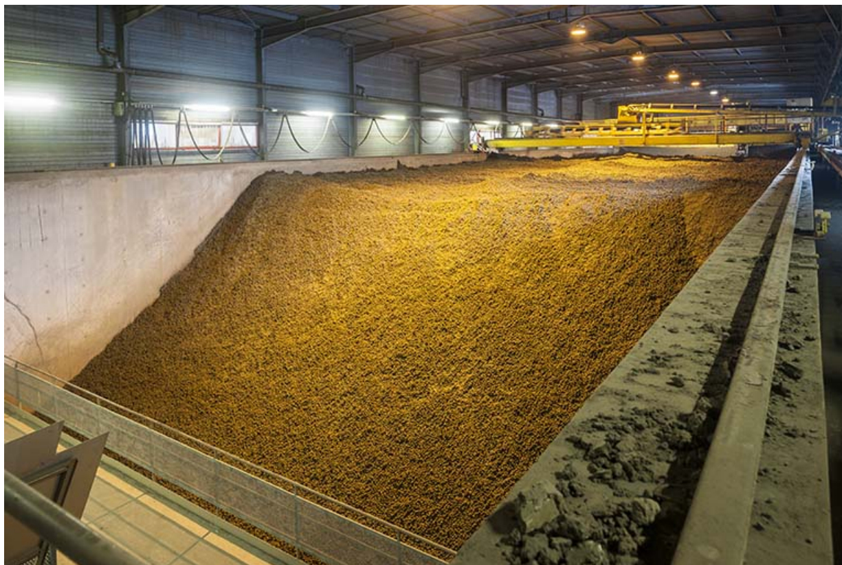
Fosse à terre (homogénéisation, maturation). Vue d'ensemble.
