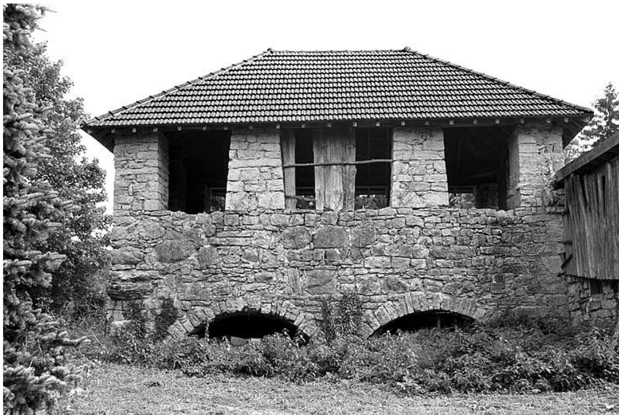
Four : ouvertures du foyer.
