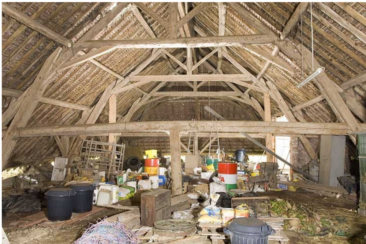
Séchoir. Partie sud de la charpente.
