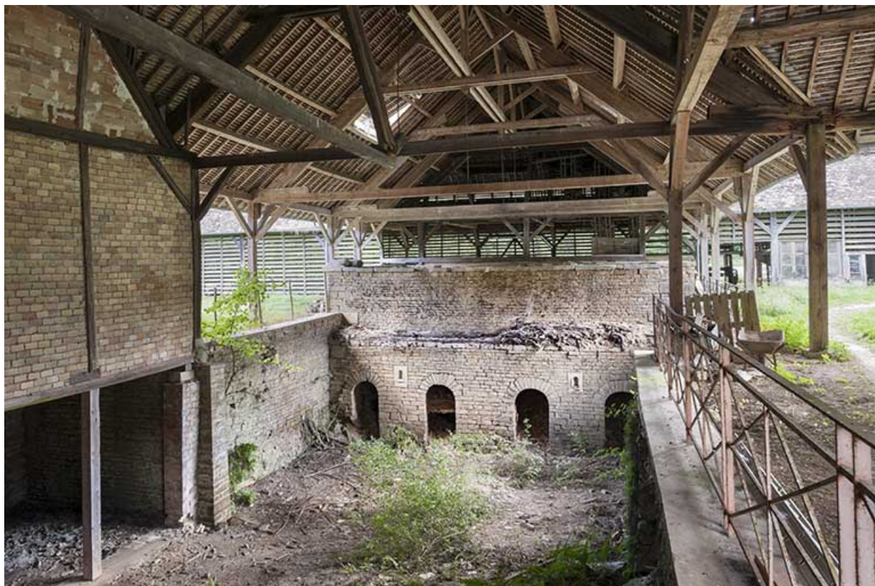
Aire d'enfournement et gueules de charge des fours.
