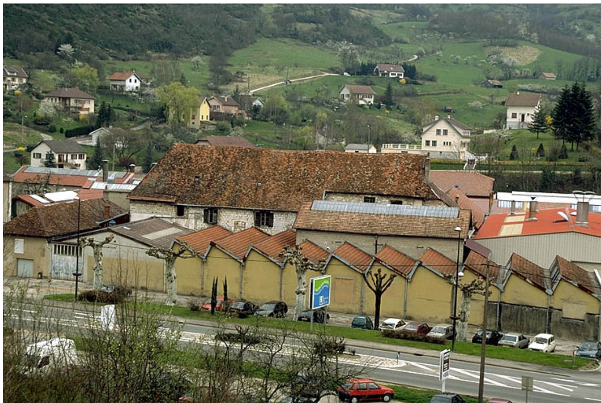
Vue plongeante sur la partie ouest de l'usine.
