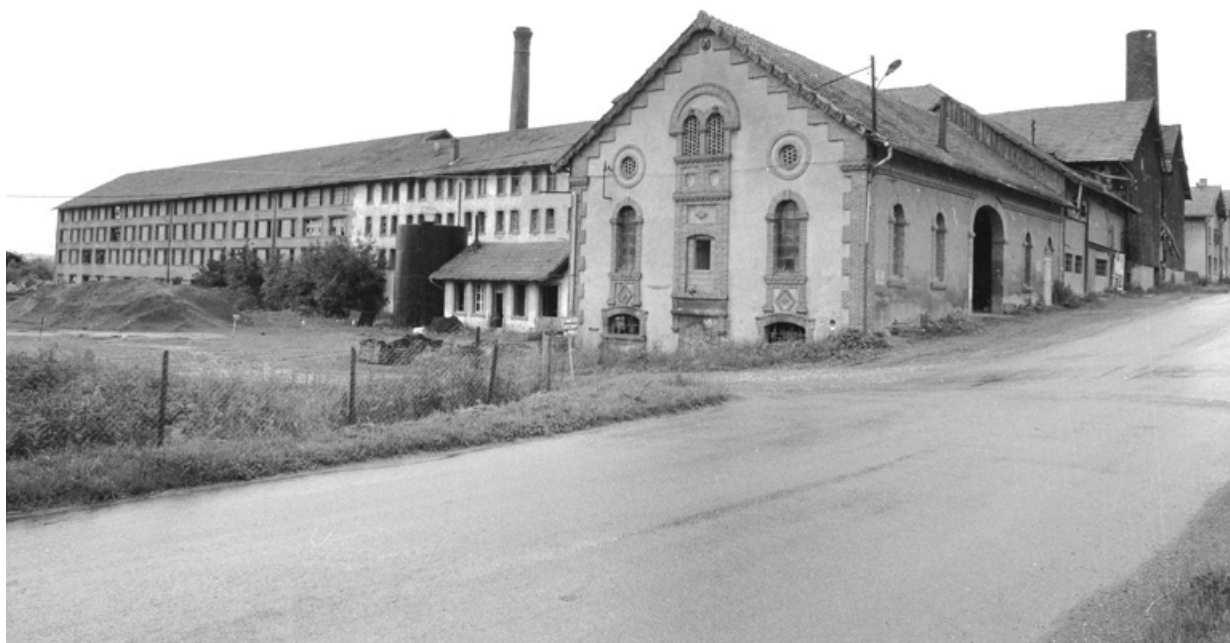
Ancienne et nouvelle tuilerie, et briqueterie (?) en 1980. SRI. Enquête régionale sur les bâtiments industriels (1979-1981).
