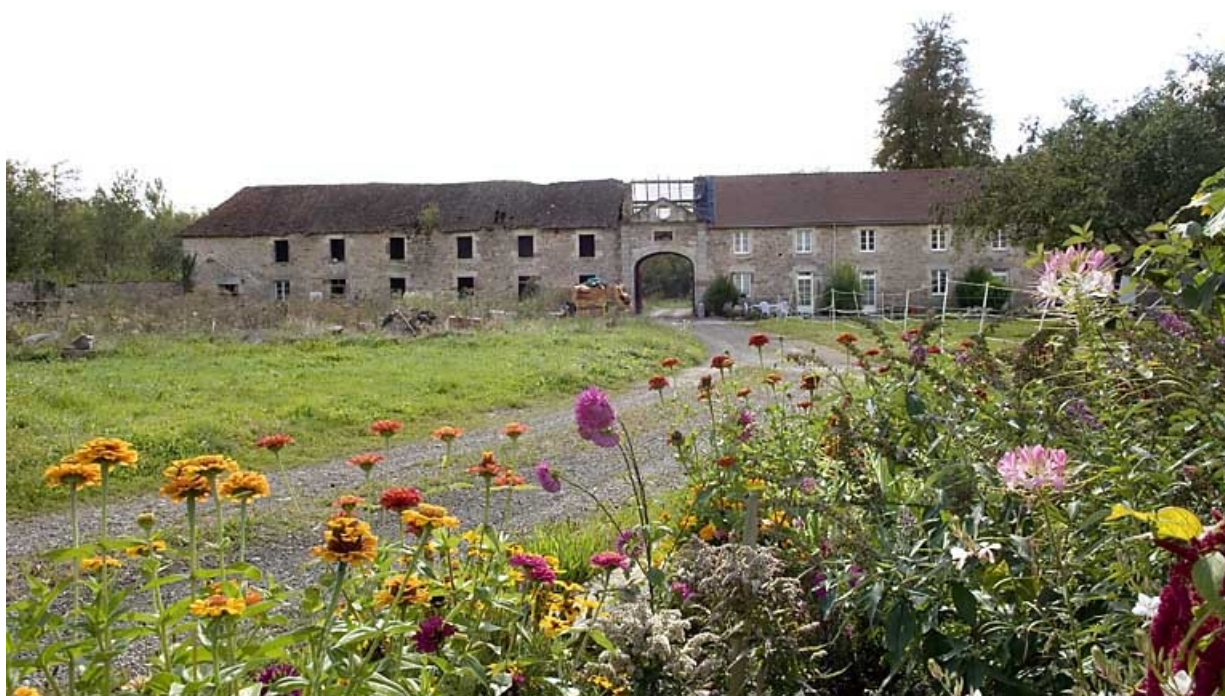
Corps de bâtiment des logements. Vue depuis le nord.
