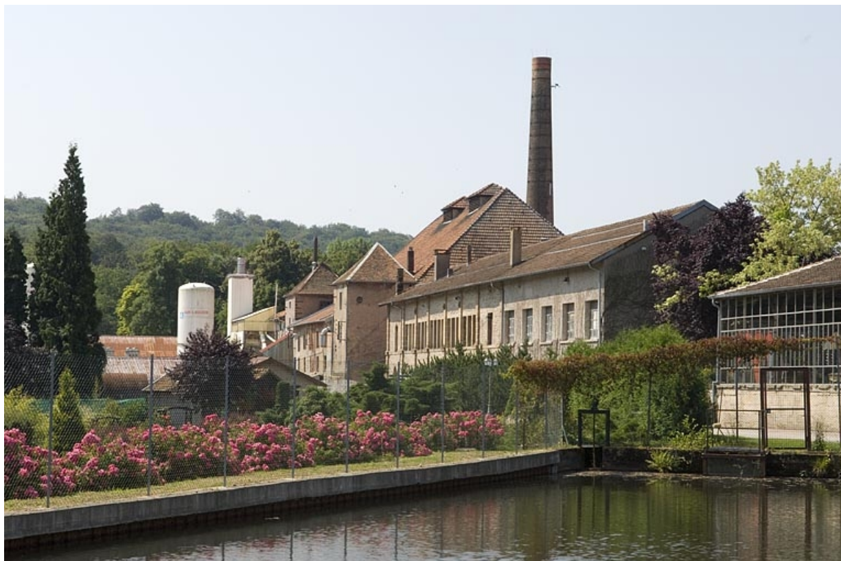
Façades est des ateliers de fabrication.
