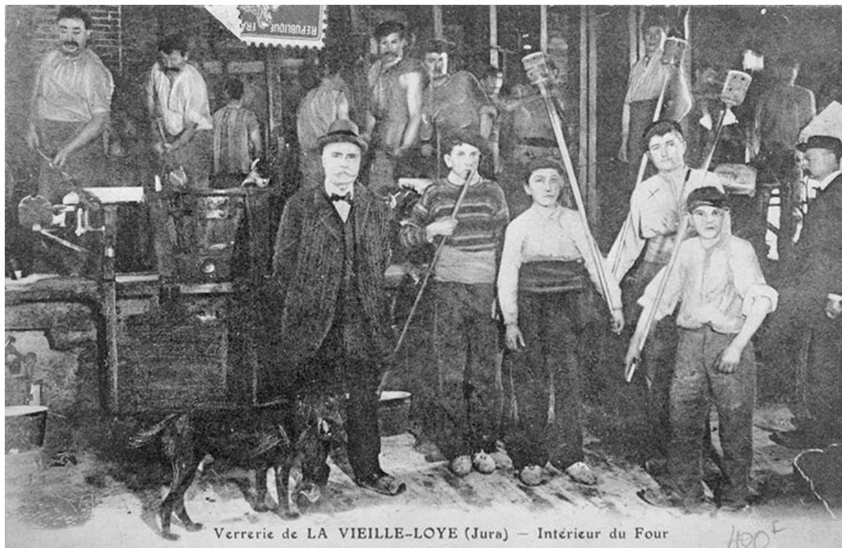
Verrerie de la Vieille-Loye (Jura) - Intérieur du Four.
