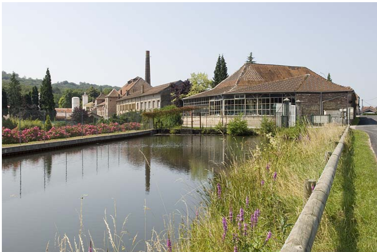
Bassin de retenue et ateliers depuis le nord-est.
