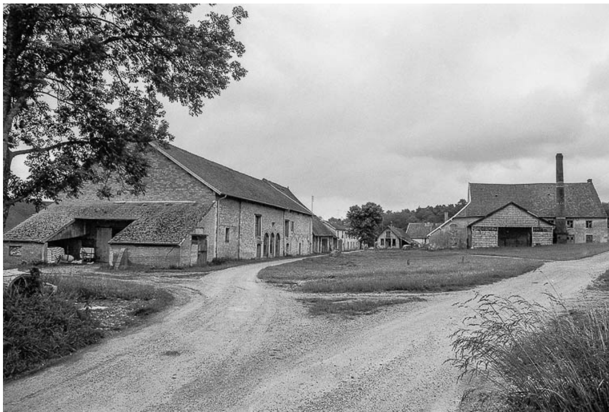
Vue de la cour et de l'entrepôt.
