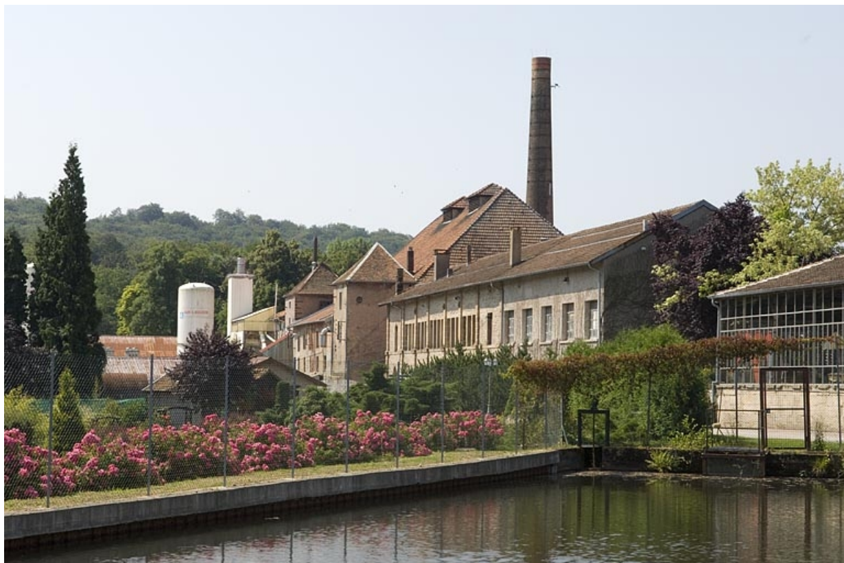
Façades est des ateliers de fabrication.
