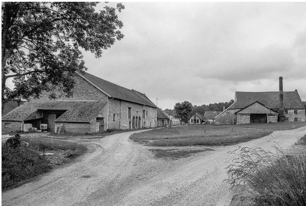
Vue de la cour et de l'entrepôt.
