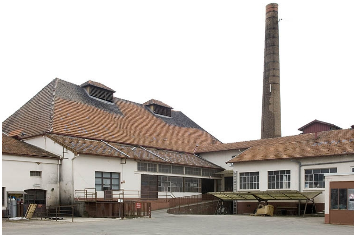
Atelier des fours vu de trois quarts.
