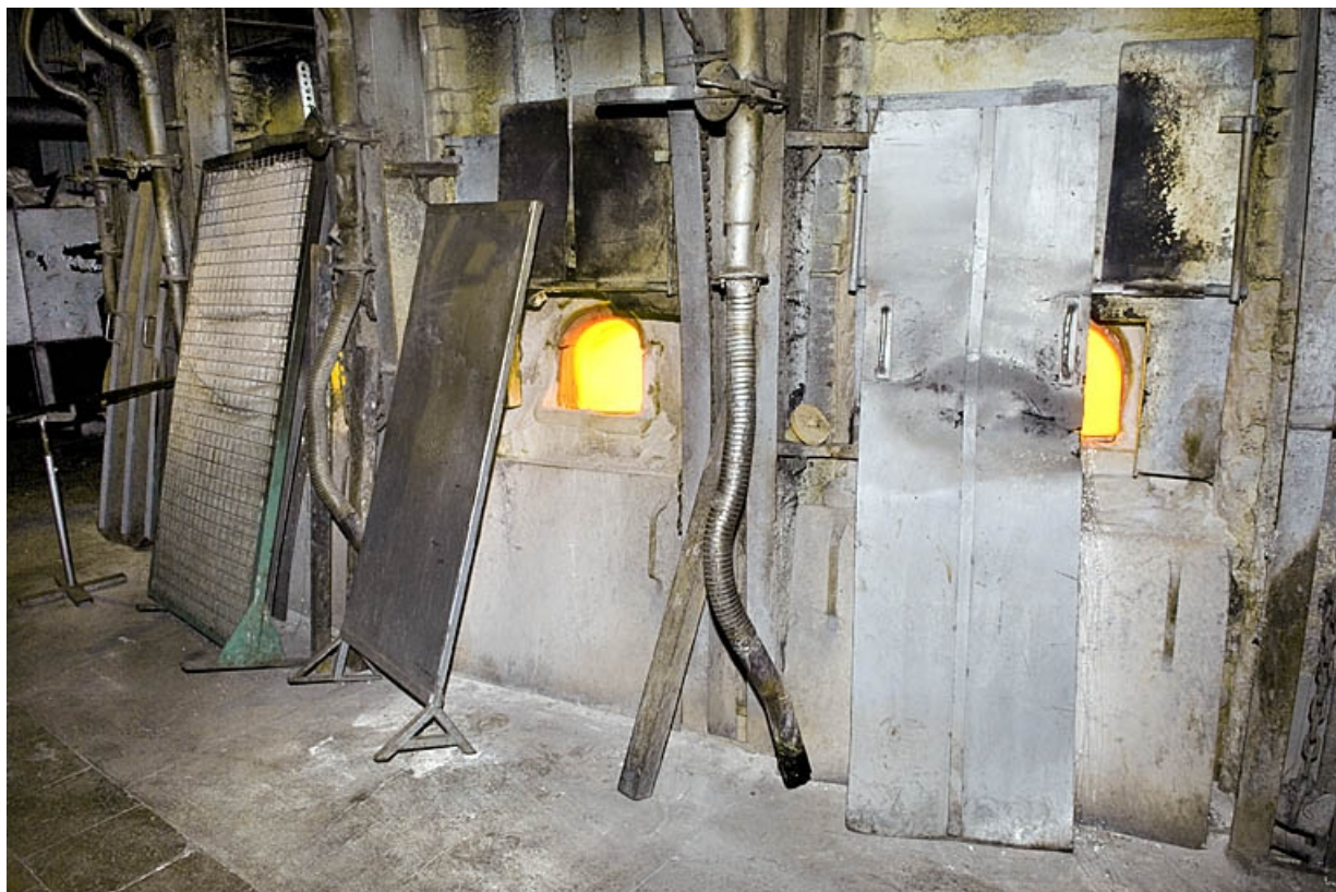
Atelier verrerie main. Four à pots.
